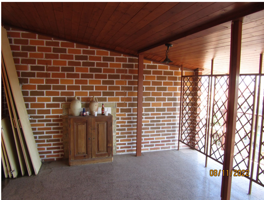
FOTO N.13 – Terrazzo esterno, porzione nord-est.
