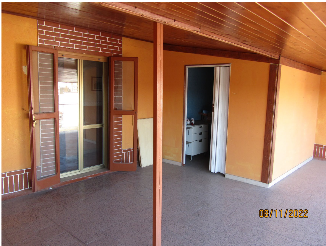
FOTO N.15 - Terrazzo esterno, porta di accesso alla porzione sud-est con vista del ripostiglio esterno.
