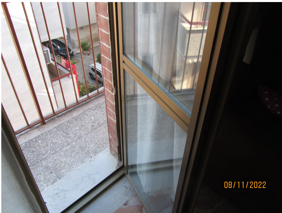
FOTO N.18 – Particolare serramenti esterni in lega di alluminio con vetrocamera.
