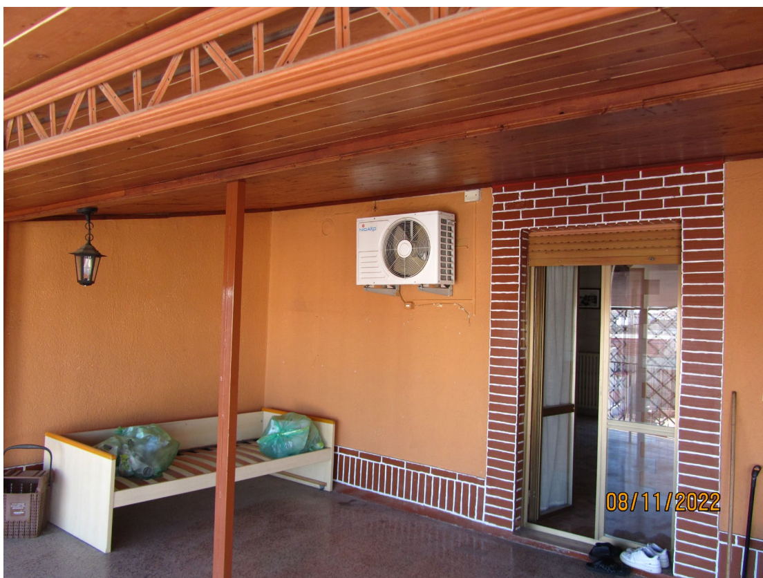
FOTO N.14 – Terrazzo esterno, porta di accesso alla porzione nord-est.
