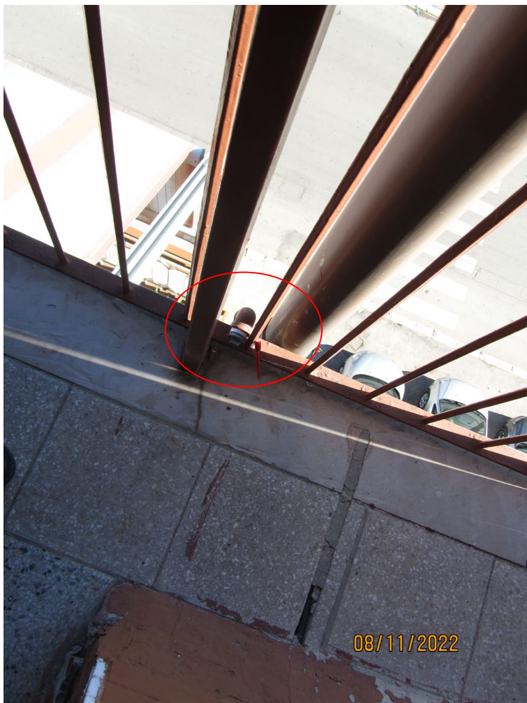
FOTO N.16 – Particolare del tappo con sigillo alla tubazione esterna del gas.
