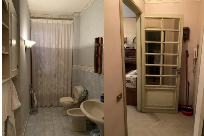
A Sx vista del wc ed a DX vista del disimpegno
