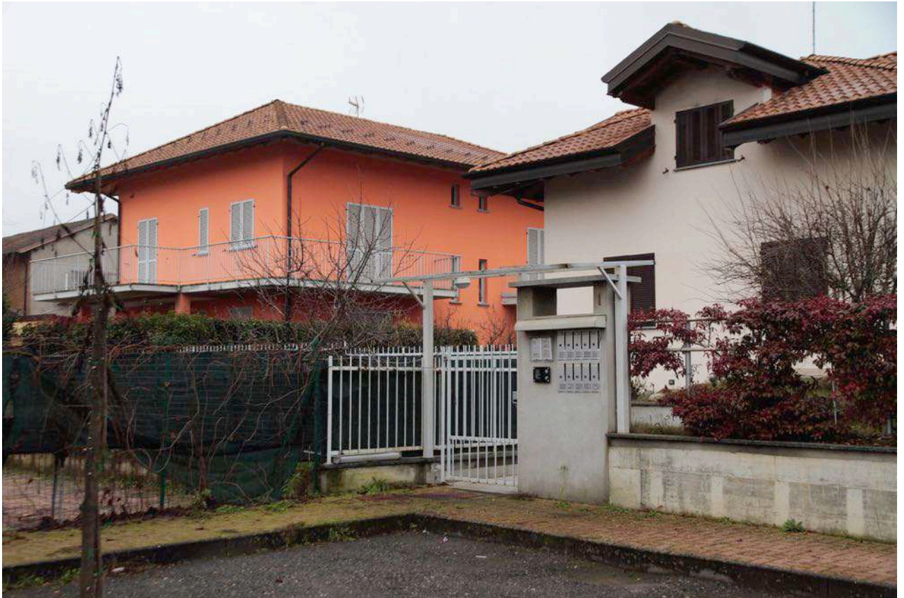
Foto n° 1 - Vista ingresso pedonale
