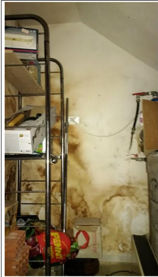
Foto 15 – vano sottoscala, piano seminterrato
