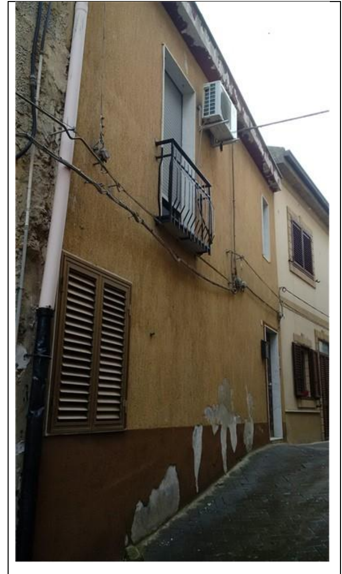
Foto 3- Prospetto con ingresso su via Messina n.4/6
