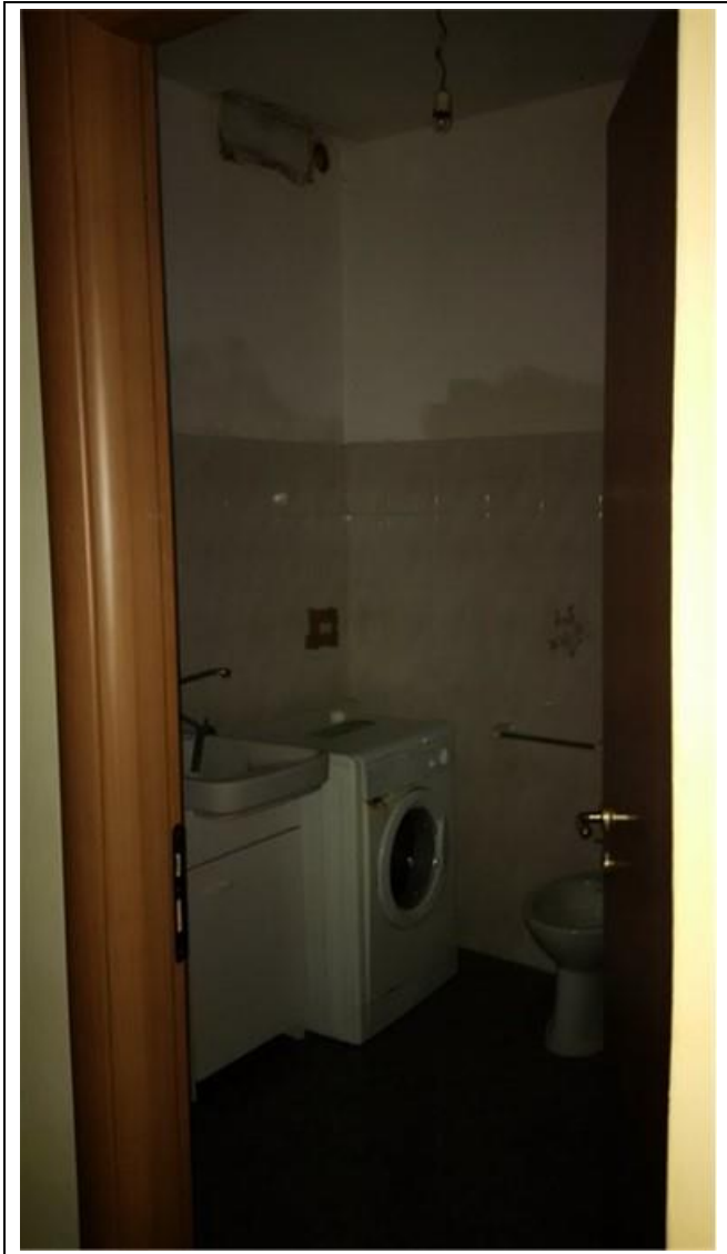
Foto 11 – vano w.c., piano seminterrato
