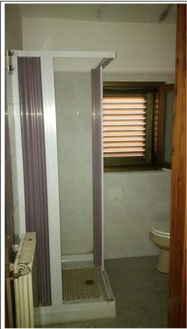
Foto 29- bagno/wc abusivo, 1° piano
