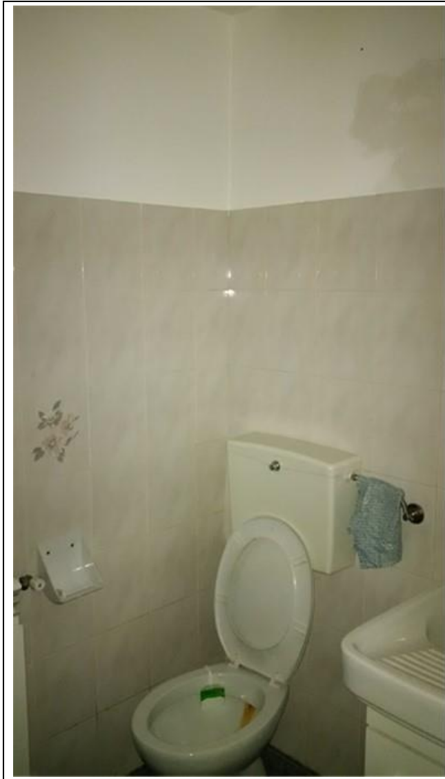
Foto 12 – vano w.c., piano seminterrato
