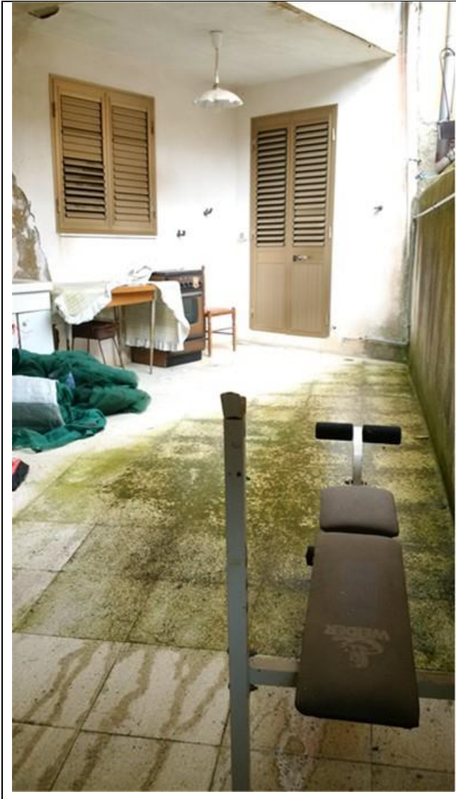
Foto 5 – Ingresso all'U.I.U. dal cortile (via Erbitea)
