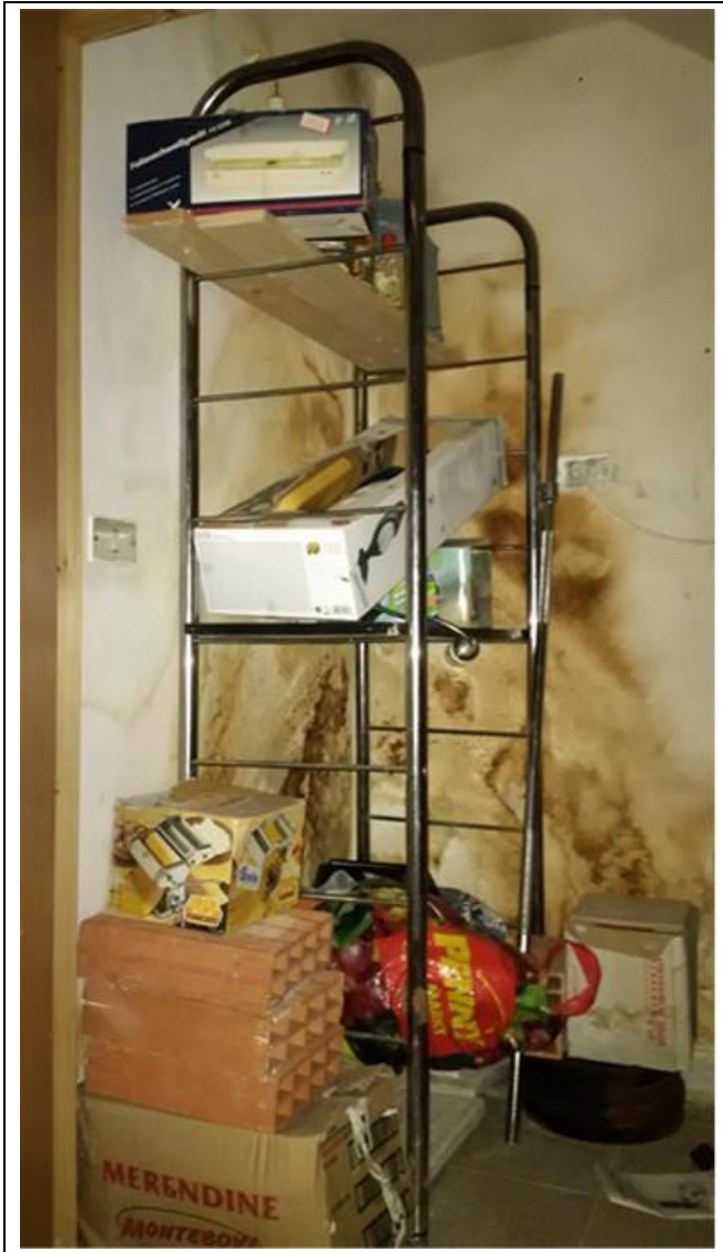
Foto 14 – vano sottoscala, piano seminterrato
