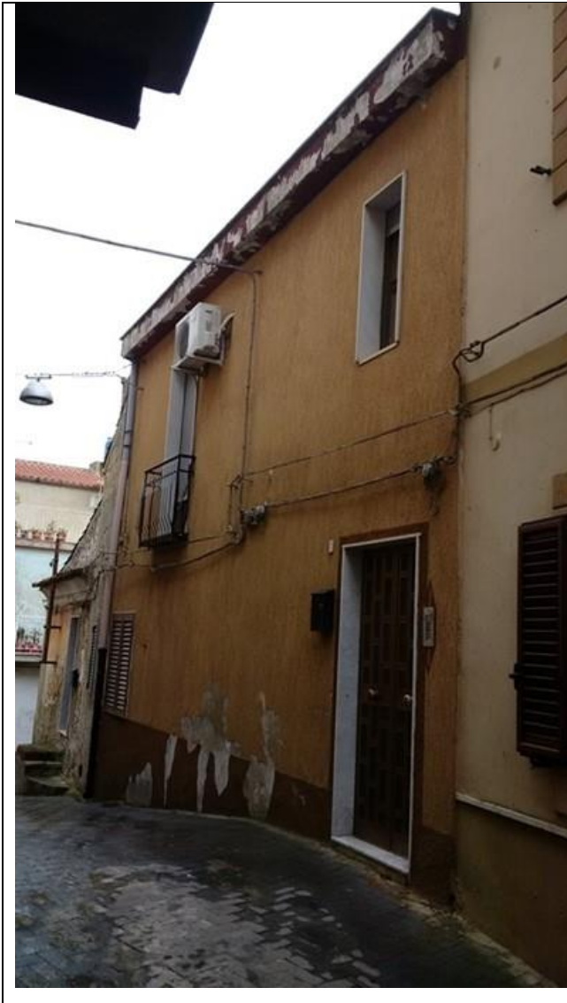
Foto 2 – Prospetto con ingresso su via Messina n.4/6
