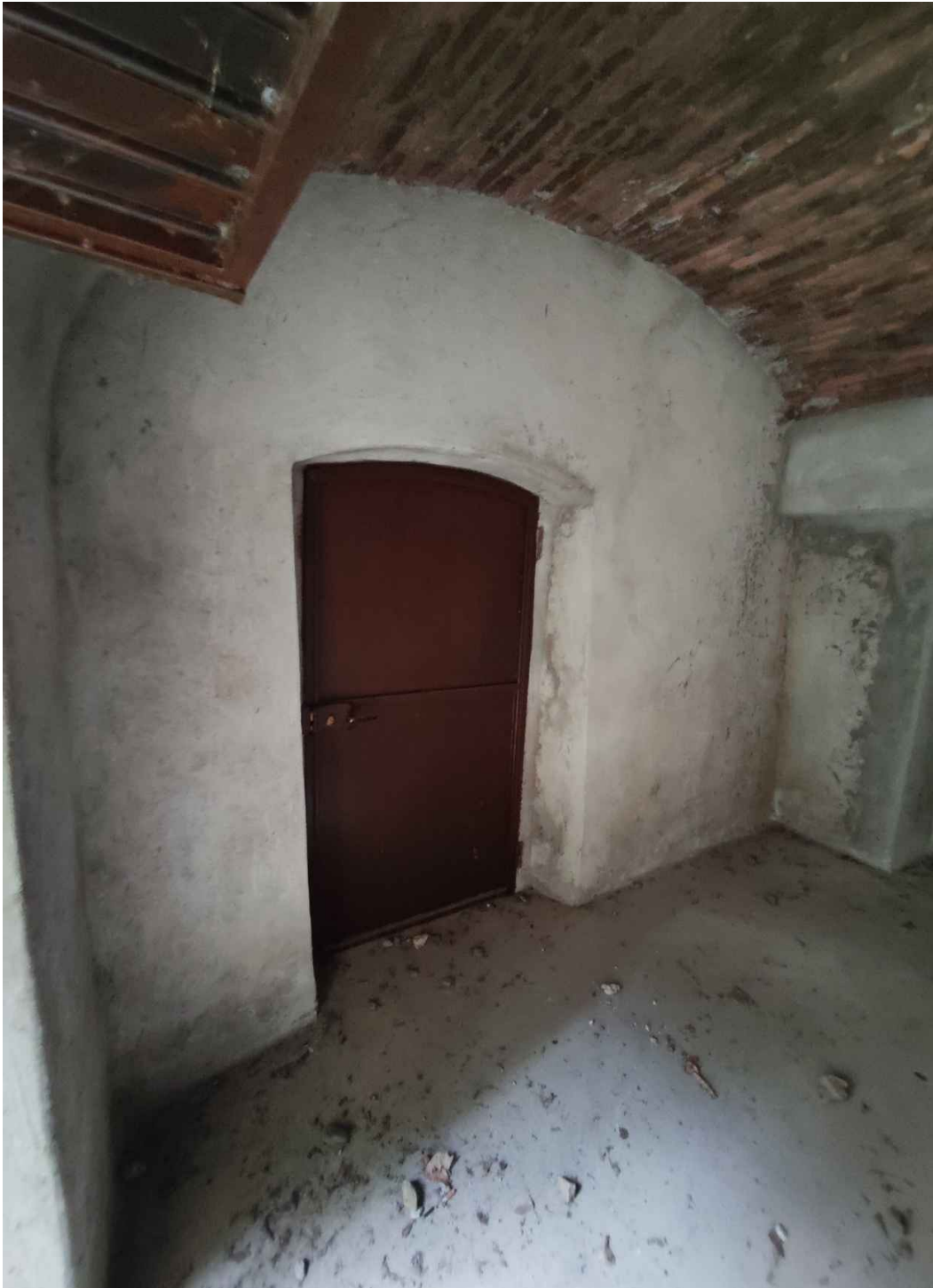
Porta di ingresso pedonale al locale garage (vista interna)
