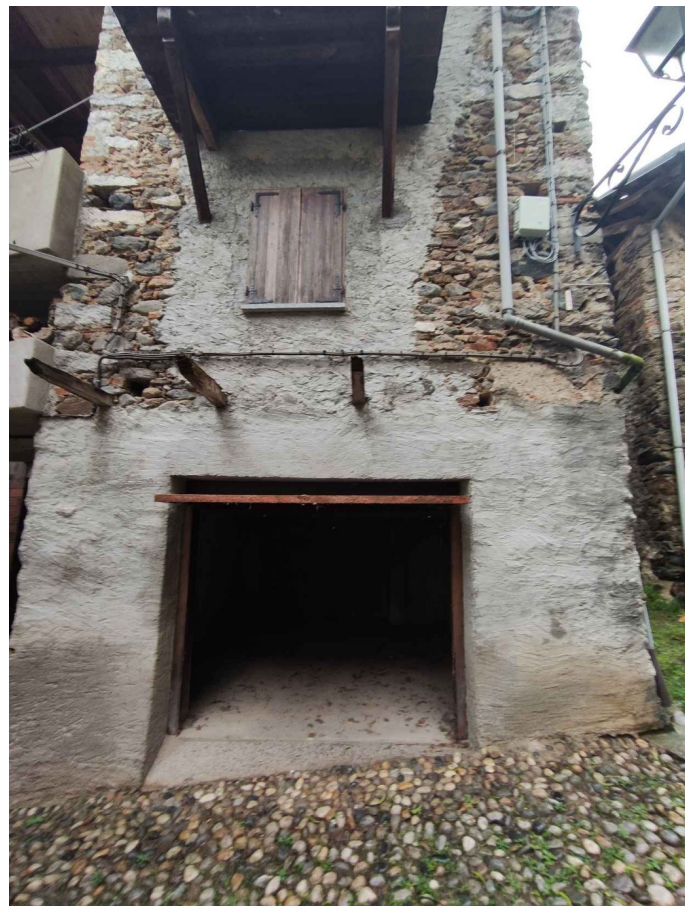
Ingresso carraio al locale garage
