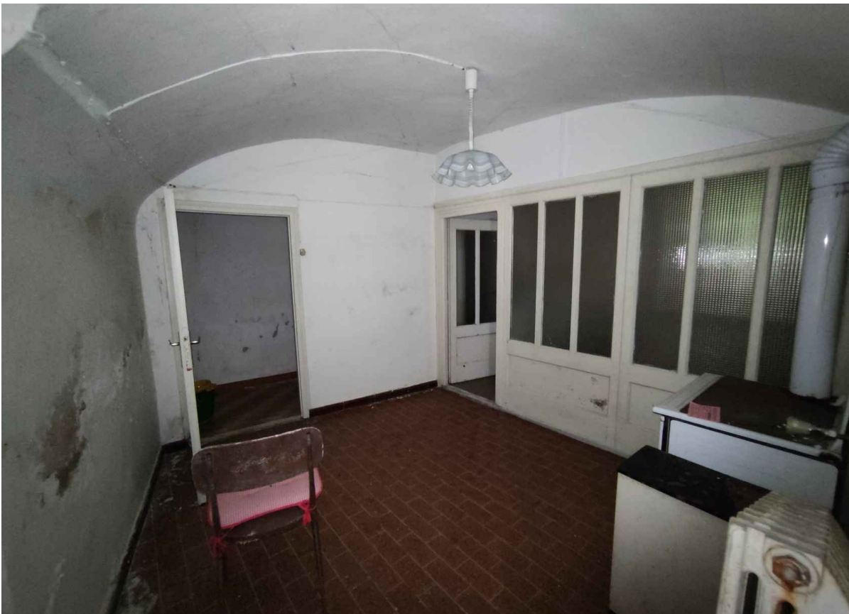
Locaie cucina a piano terra
