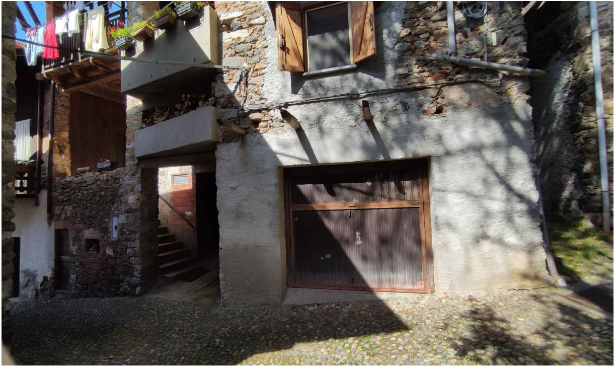
Ingresso carraio al locale garage
