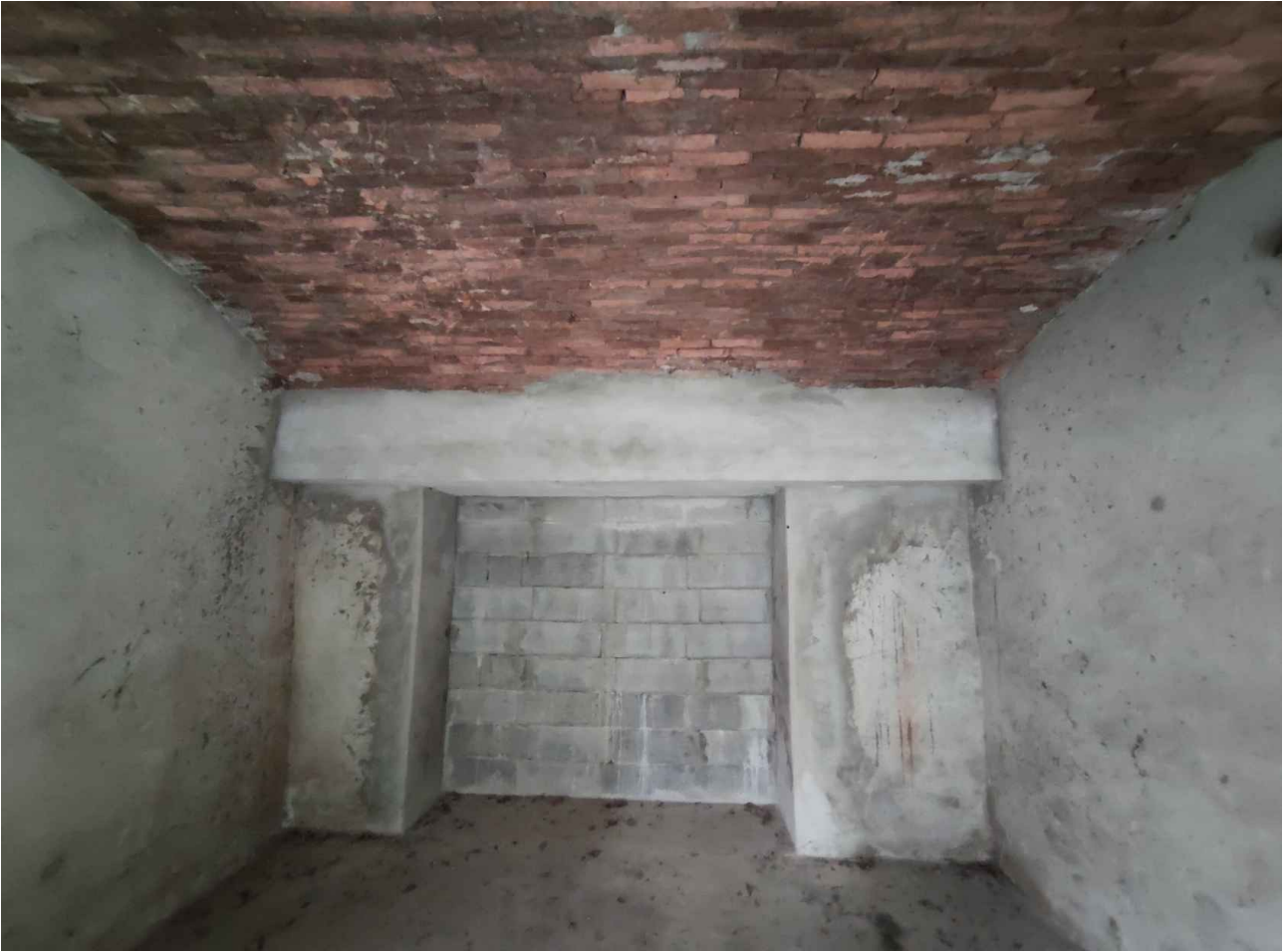
Interno del garage
