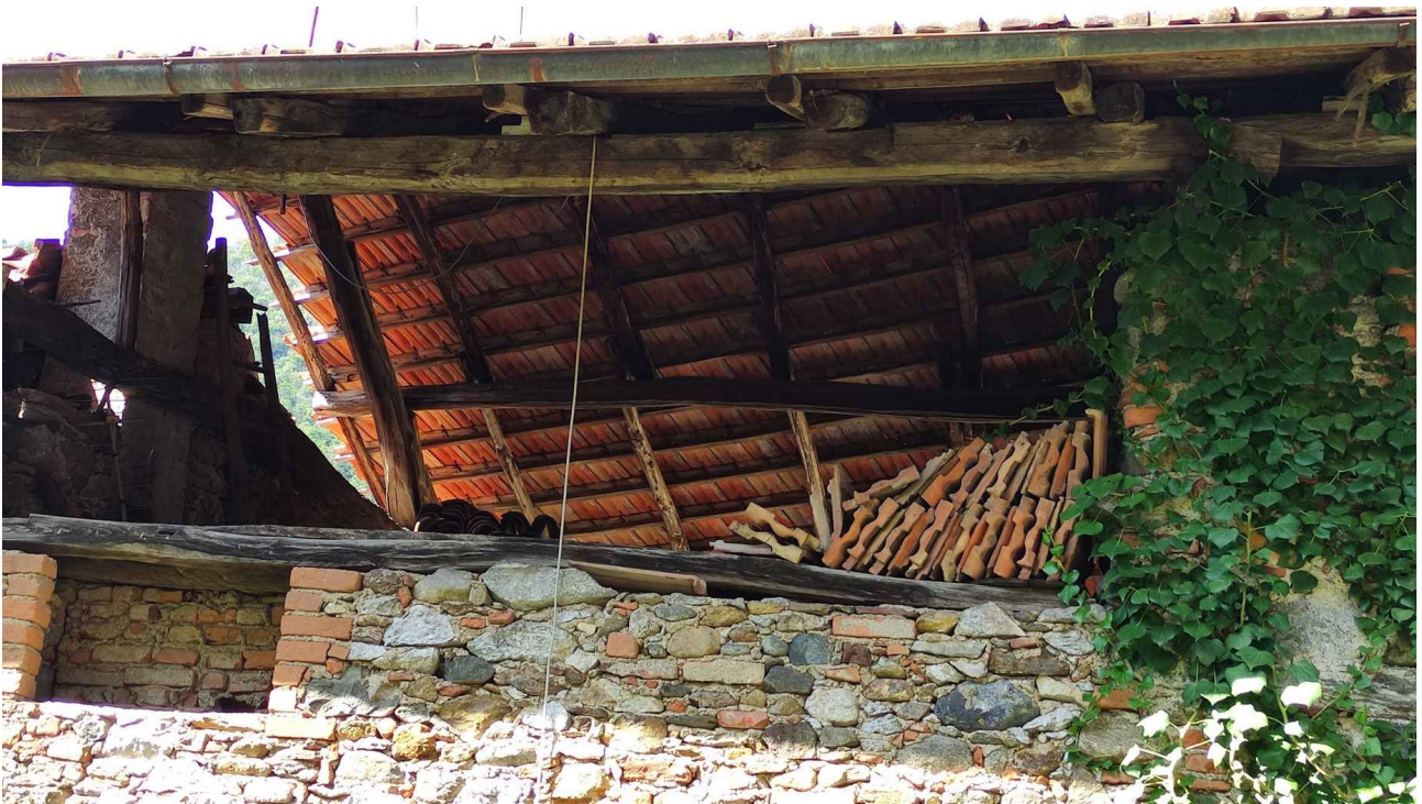
Vista della copertura da ovest
