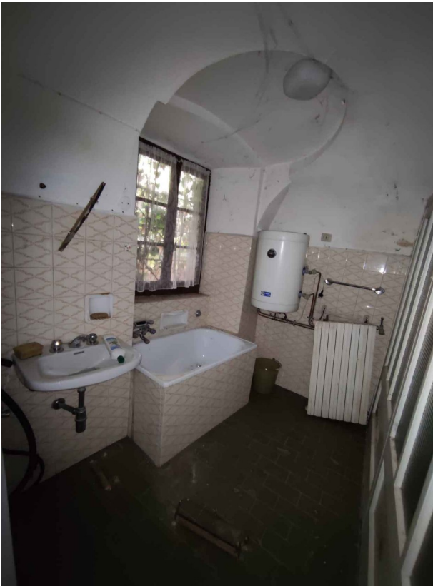
bagno (piano terra)
