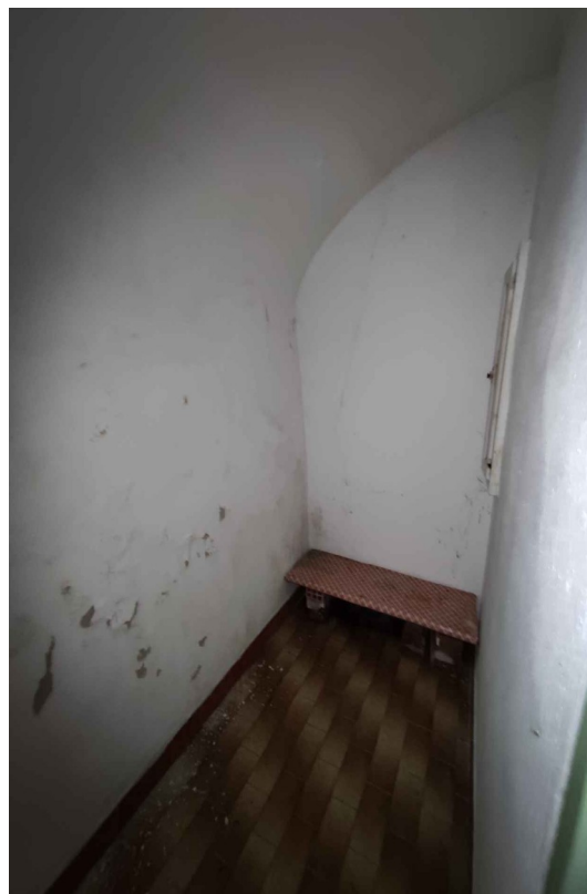
ripostiglio (piano terra)
