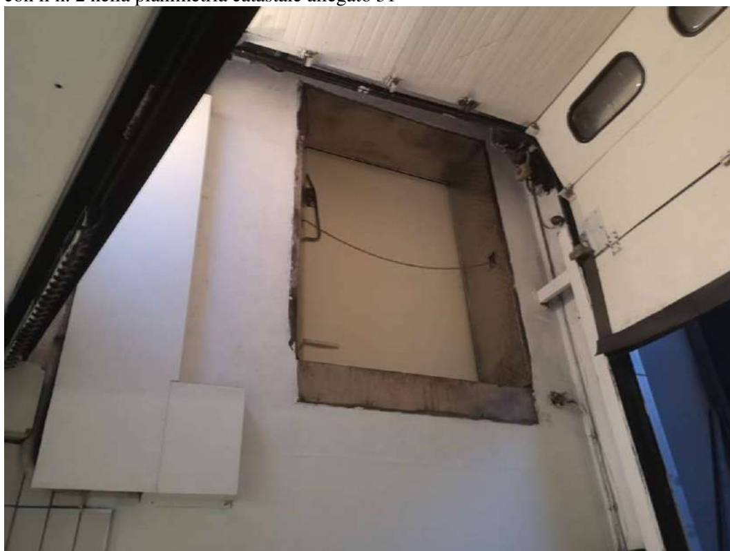
FOTO 118 – STABILIMENTO AL PIANOTERRA, zona scarico merci, vedi foto esterne 17 e 18, riprese dal cortile p.c.ed. 211/2 , vedi allegato 49. A destra il serramento a chiusura sezionale automatica, in alto il foro porta presente nel laboratorio al primo piano (quello indicato con altezza interna variabile di m. 2,60, m. 3,95 e m. 3,20 nella planimetria catastale. Zona corrispondente al pianoterra al vano più grande identificato con il n. 2 nella planimetria catastale allegato 31
