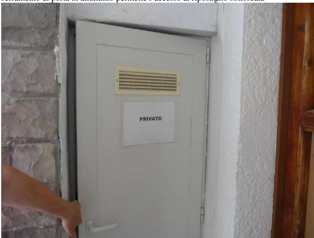
FOTO 60 – UFFICIO SUB 1, portico, vedi planimetria catastale allegato 32. Il serramento di porta in alluminio permette l'accesso al ripostiglio sottoscala
