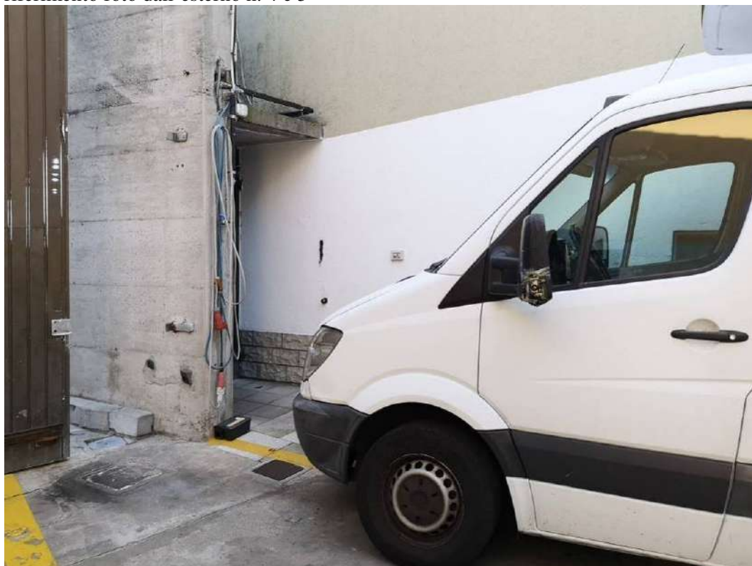
FOTO 21 – immagine ripresa dal cortile p.c.ed. 211/2 censita nel c.t. 1° della P.T 1277 del C.C. di Monti, particolare a sinistra dell'accesso carrabile dalla strada pubblica, a destra l'edificio presente sulla p.c.ed. 211/1 e particolare dell'accesso pedonale, riferimento foto dall'esterno n. 4 e 5
