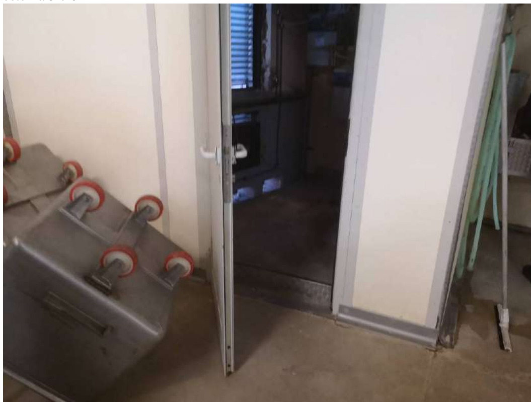
FOTO 211 – STABILIMENTO AL PRIMO PIANO, laboratorio. Vedi planimetria catastale allegato 31. Vano identificato con il numero 1 che presenta una altezza variabile Il serramento di porta permette l'accesso ad un piccolo vano compressori, vedi foto esterna 5 e 6
