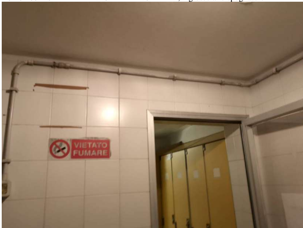
FOTO 133 – STABILIMENTO AL PIANOTERRA, ingresso allo spogliatoio
