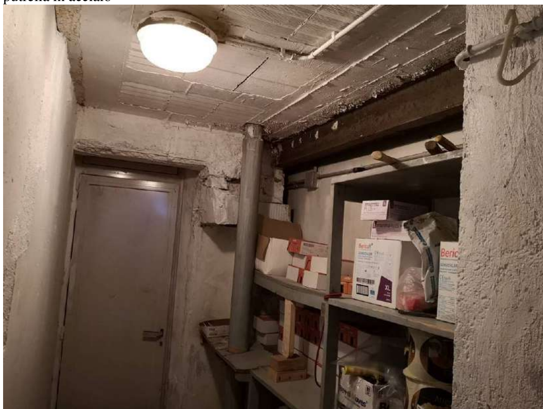
FOTO 124 – STABILIMENTO AL PIANOTERRA, ripostiglio (LOCALE NON IN USO). Zona corrispondente al pianoterra al vano più grande identificato con il n. 2 nella planimetria catastale allegato 31. Visibile sulla destra una nicchia nella muratura ed una putrella in acciaio
