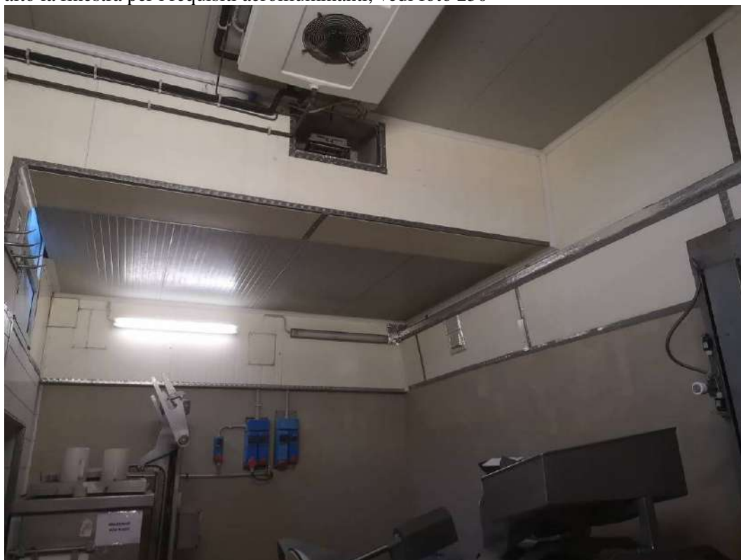
FOTO 145 – STABILIMENTO AL PIANOTERRA, laboratorio al pianoterra (zona individuata nella planimetria catastale con il numero 1, vedi allegato 31), sulla sinistra in alto la finestra per i requisiti aeroilluminanti, vedi foto 230
