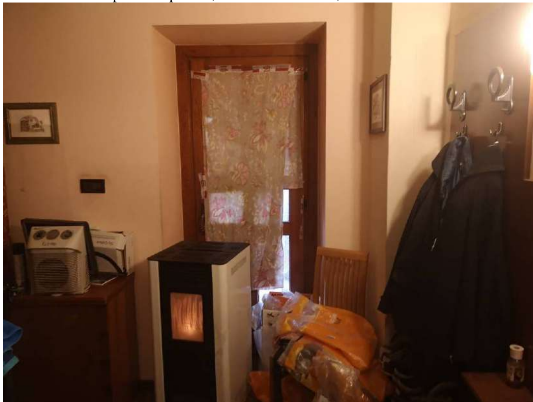
FOTO 99 – ALLOGGIO SUB 2 PRIMO PIANO, atrio, vedi planimetria catastale allegato 33. Visibile la stufa a pellet posizionata accanto al portoncino di ingresso in maniera tale da impedire l'apertura, vedi foto esterne 27, 28 e 67
