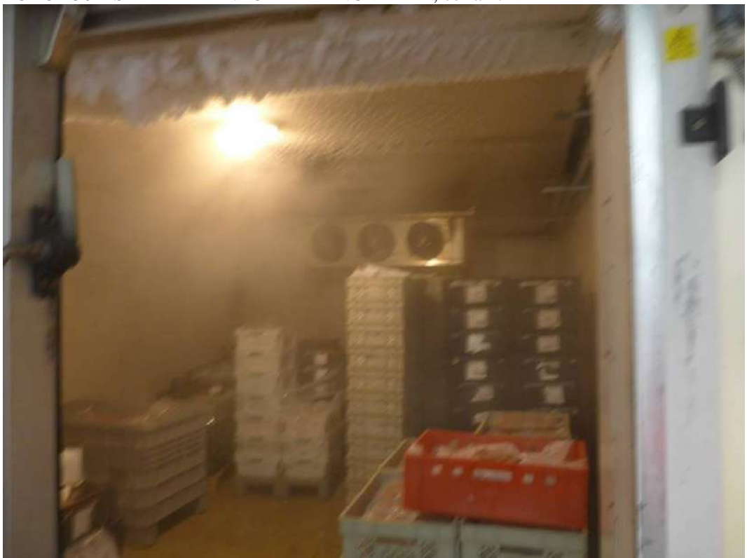
FOTO 130 – STABILIMENTO AL PIANOTERRA, cella n. 2
