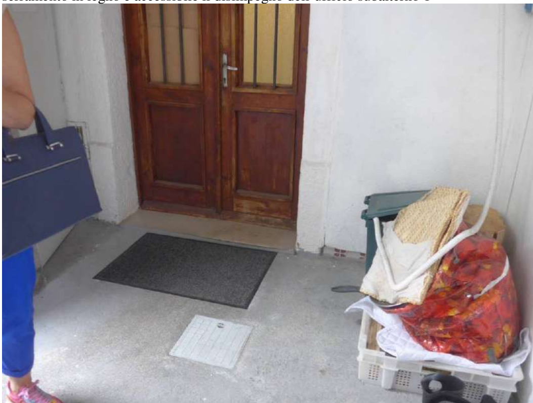
FOTO 59 – UFFICIO SUB 1, portico, vedi planimetria catastale allegato 32. Sulla destra risulta ricavato un vano ripostiglio nella zona sottostante la cucina, vedi foto 30 e 47. Dal serramento in legno è accessibile il disimpegno dell'ufficio subalterno 1
