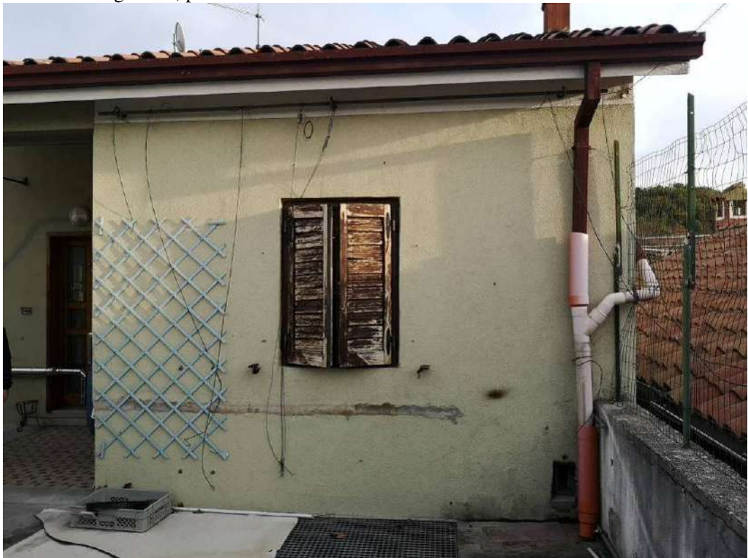
FOTO 26 – foto ripresa dalla terrazza presente al primo piano dello stabilimento artigianale presente sulla p.c.ed. 211/2 e sulla p.c. 1625/11, in primo piano la facciata dell’edificio eretto sulla p.c.ed. 211/1 dove si trova l’alloggio sub 2 (vedi planimetria catastale allegato 33, particolare della finestra della cucina.
