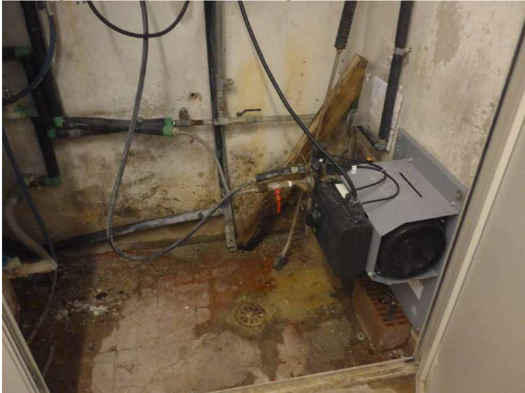
FOTO 171 – STABILIMENTO AL PIANOTERRA, disimpegno-locale idropulitrice. Vano con soprastante la terrazza al primo piano, dove si trovano i compressori delle celle frigorifero. Sulla sinistra si trova il vano aromi (chiuso per infiltrazioni d'acqua). Visibili anche in questo vano segni di infiltrazione d'acqua.
