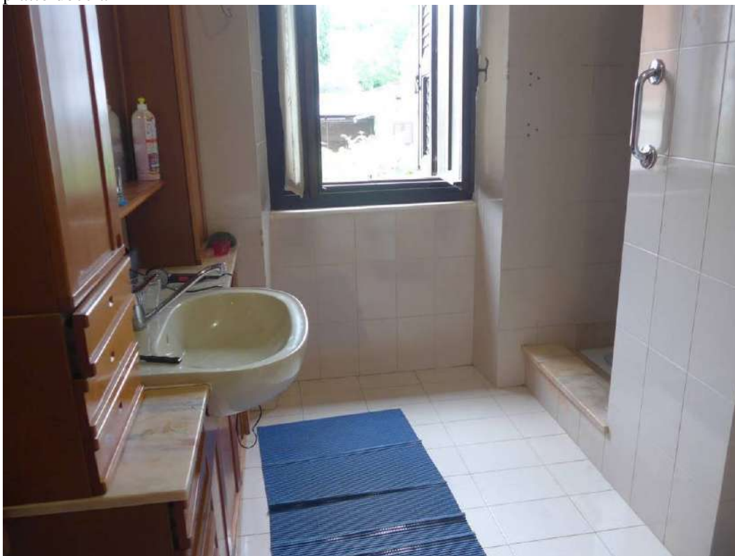
FOTO 87 – ALLOGGIO SUB 2 PRIMO PIANO, bagno, vedi planimetria catastale allegato 33. Nella planimetria catastale non sono rappresentate le pareti dove si trova il piatto doccia
