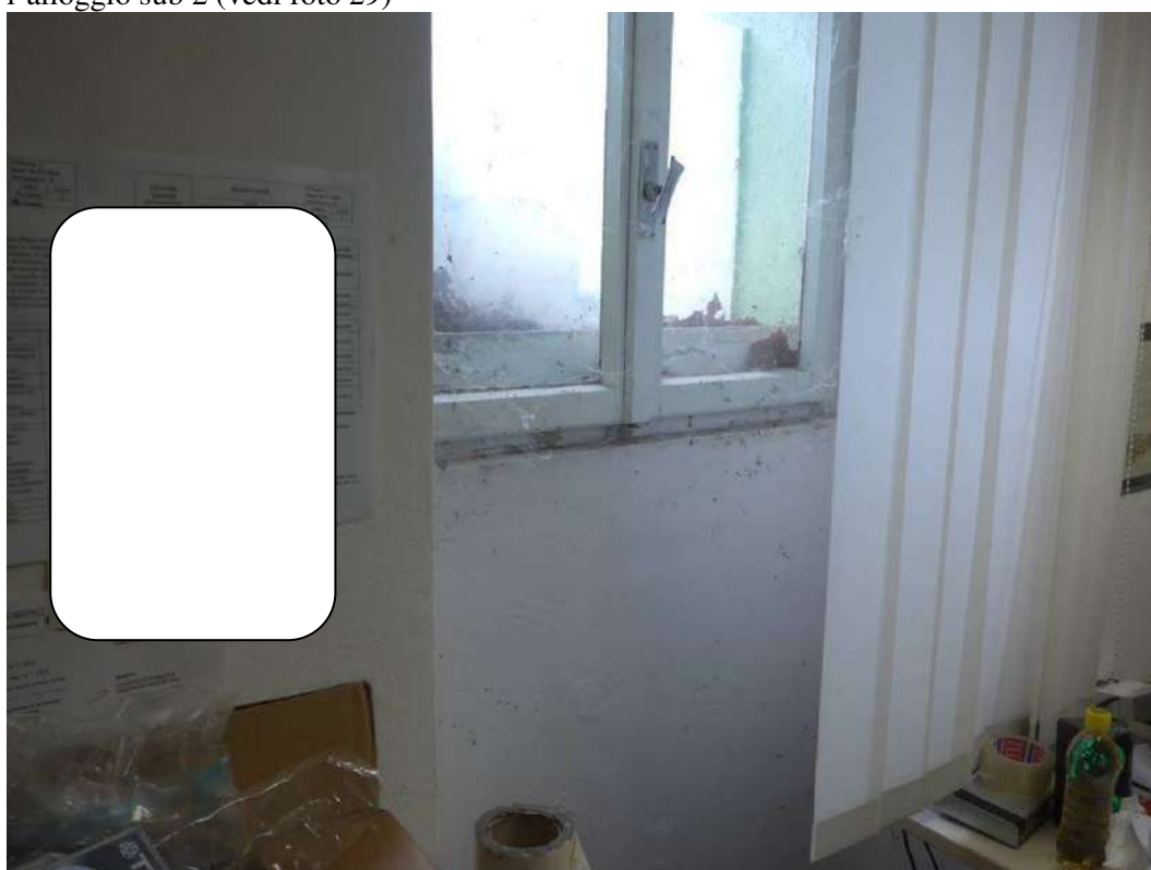
FOTO 52 – UFFICIO SUB 1, ufficio (Marketing), vedi planimetria catastale allegato 32. (Questo vano ufficio non risulta locato, vedi contratto di locazione allegato 13). Visibile dalla finestra la rampa scale esterna (accostata al foro finestra) che occlude parzialmente il foro finestra. La rampa scale esterna, permette l'accesso al primo piano dove si trova l'alloggio sub 2 (vedi foto 29)
