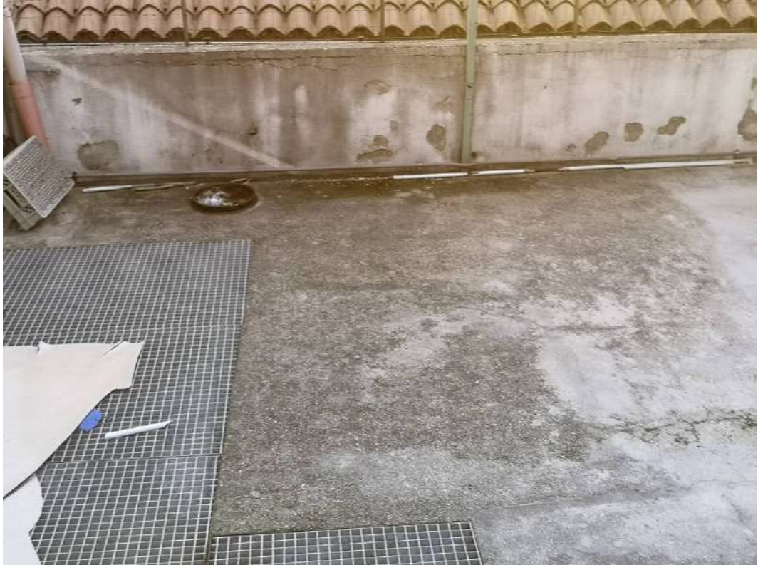
FOTO 239 – STABILIMENTO AL PRIMO PIANO, terrazza, accessibile dal laboratorio e precisamente dal vano con altezza m. 2,85, vedi planimetria catastale allegato 31 e vedi progetto variante in sanatoria allegato 49
