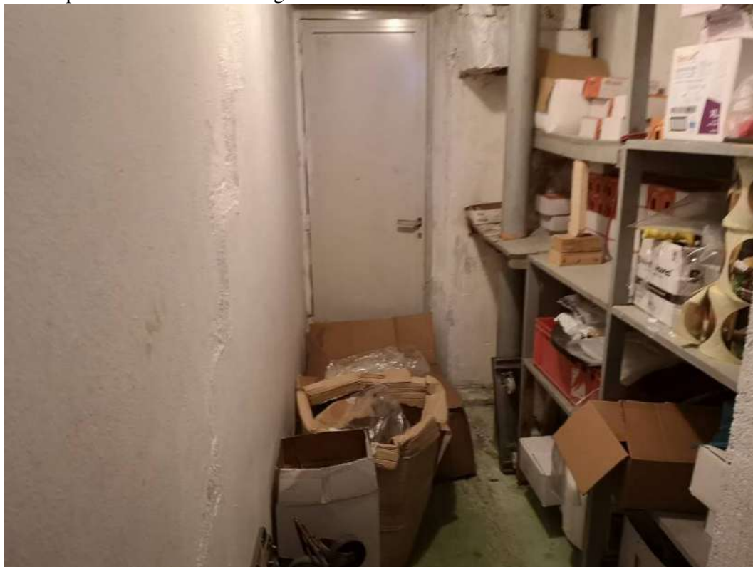
FOTO 125 – STABILIMENTO AL PIANOTERRA, scarico merci, ripostiglio (LOCALE NON IN USO). Zona corrispondente al pianoterra al vano più grande identificato con il n. 2 nella planimetria catastale allegato 31
