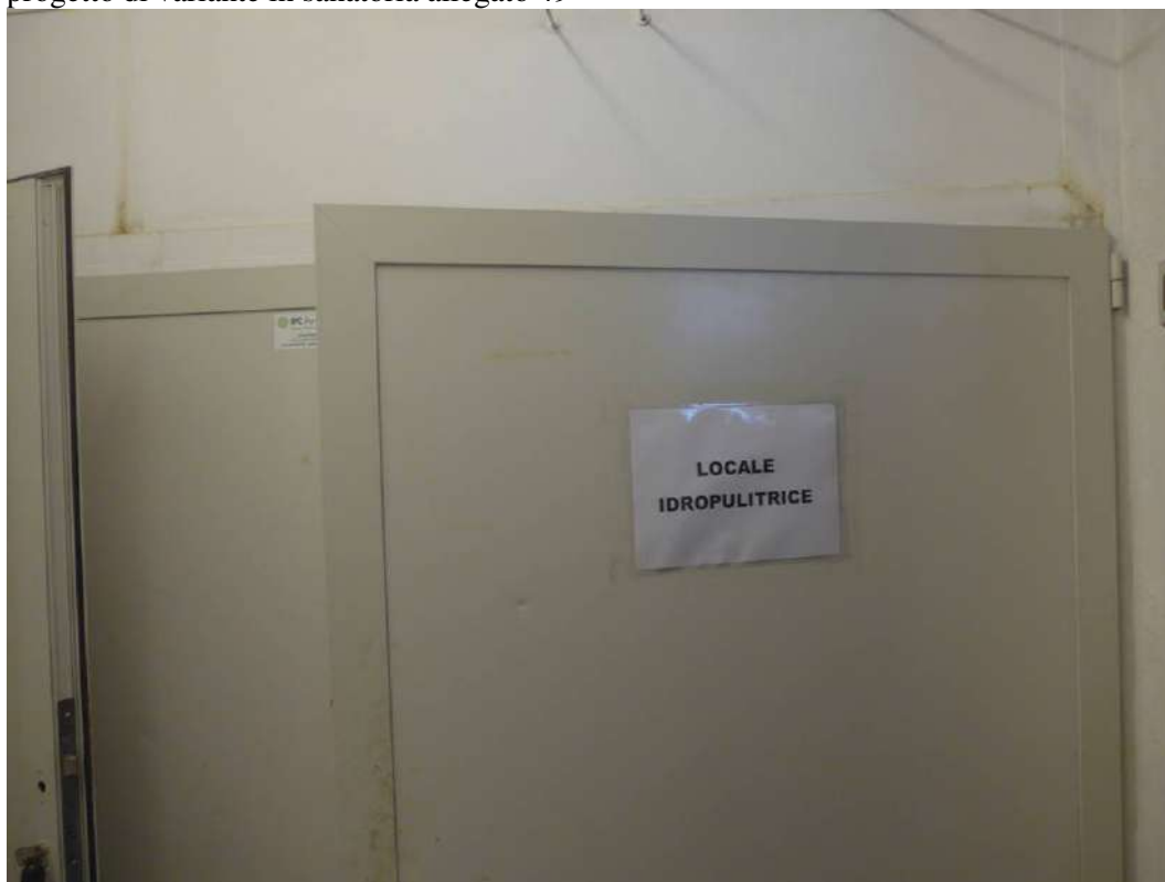
FOTO 169 – STABILIMENTO AL PIANOTERRA, disimpegno-locale idropulitrice. Vano con soprastante la terrazza al primo piano, dove si trovano i compressori delle celle frigorifero. Sulla sinistra si trova il vano aromi (chiuso per infiltrazioni d'acqua), vedi progetto di variante in sanatoria allegato 49
