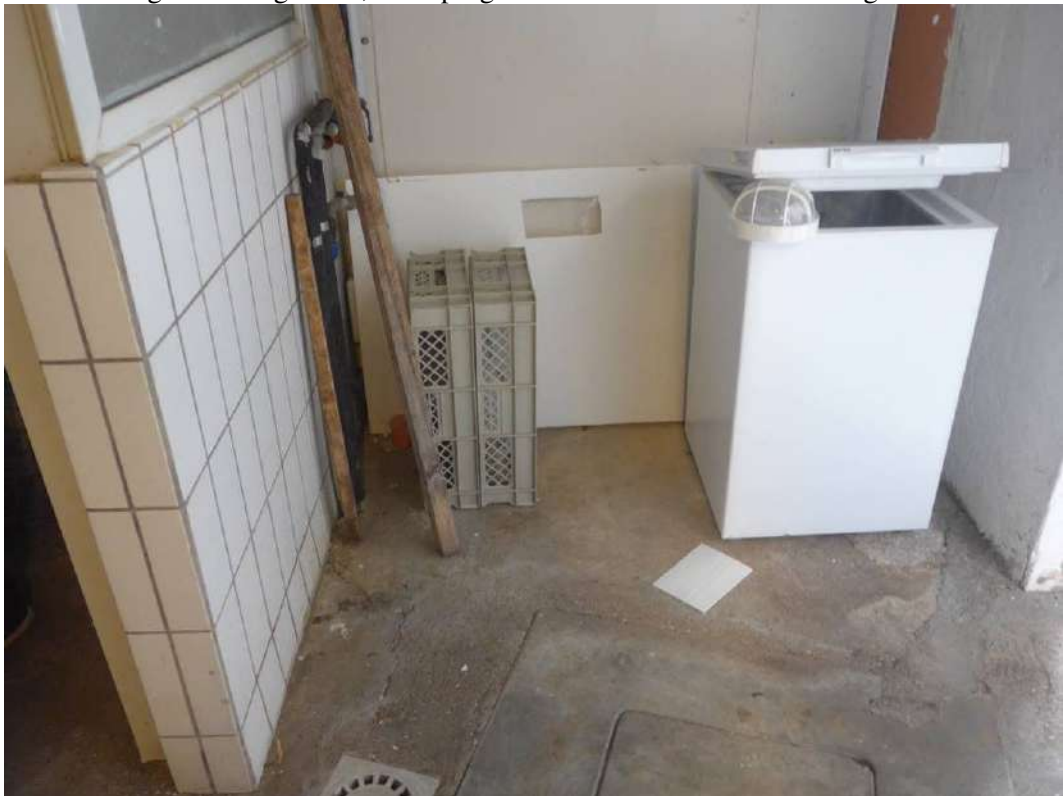
FOTO 164 – STABILIMENTO AL PIANOTERRA, zona esterna coperta dalla soprastante terrazza al primo piano, zona denominata stoccaggio sottoprodotti di origine animale nei grafici allegato 20, vedi progetto di variante in sanatoria allegato 49
