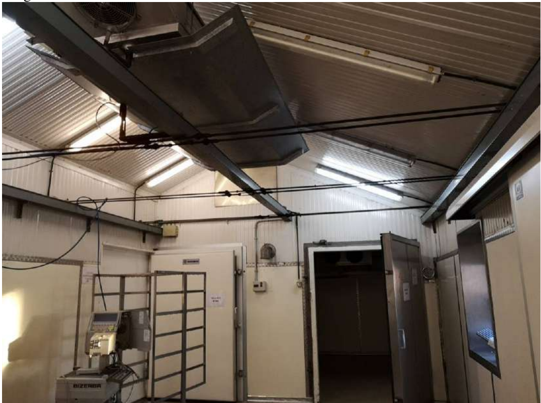
FOTO 216 – STABILIMENTO AL PRIMO PIANO, laboratorio. Vedi planimetria catastale allegato 31, il vano identificato con il numero 1 che riporta una altezza variabile di m. 260, m. 3,95 e 3,20 (nella planimetria catastale). Sul fondo della foto la cella frigorifero 8 (a destra) e 9 (a sinistra), celle frigorifero non utilizzate e come dichiarato dal titolare della ditta eseguita e non funzionanti. Vedi progetto di variante in sanatoria allegato 49
