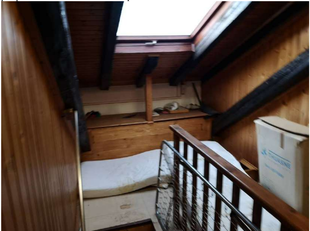
FOTO 106 – ALLOGGIO SUB 2 SECONDO PIANO, foto ripresa dal secondo piano, livello di piano non rappresentato nella planimetria catastale allegato 33. Visibile l'arrivo della rampa scale posizionata in un piccolo vano ricavato nel disimpegno del primo piano, con la quale si raggiunge il secondo piano soffitta. Visibile il lucernario che prospetta verso la corte interna della p.c.ed. 211/2
