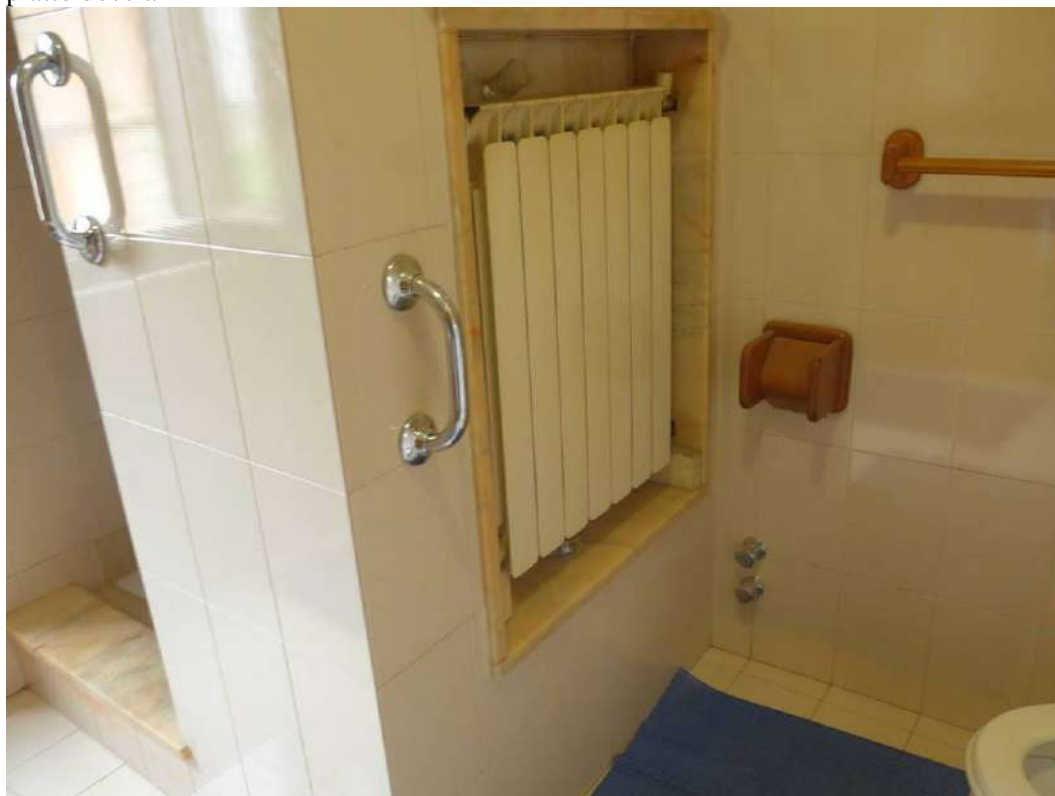
FOTO 93 – ALLOGGIO SUB 2 PRIMO PIANO, bagno, vedi planimetria catastale allegato 33. Nella planimetria catastale non sono rappresentate le pareti dove si trova il piatto doccia
