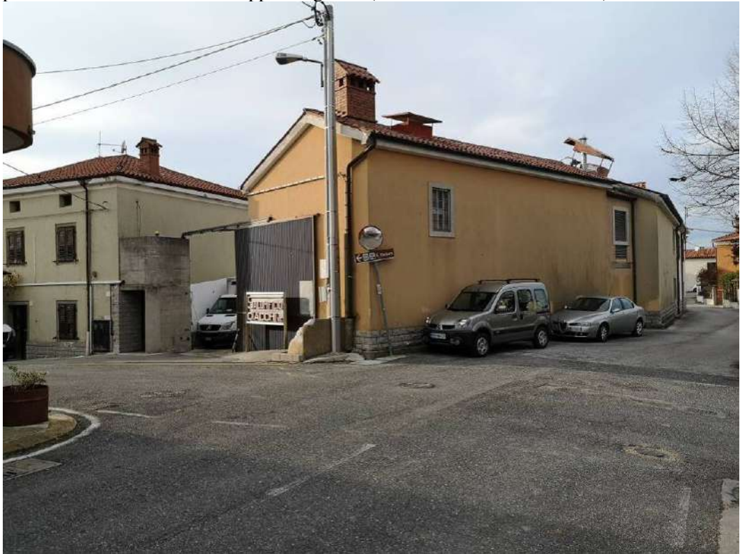
FOTO 5 – Sulla sinistra l'edificio presente p.c.ed. 211/1 a destra l'edificio costruito sulla p.c.ed. 211/2, vedi estratto mappa allegato 6 (Località Santa Barbara 81/a)
