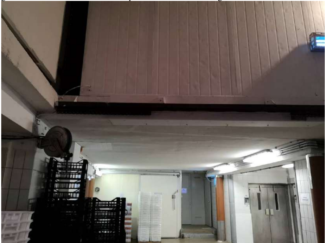
FOTO 119 – STABILIMENTO AL PIANOTERRA, zona scarico merci, vedi foto esterne 17 e 18, riprese dal cortile p.c.ed. 211/2 , vedi allegato 49. Sulla destra è visibile il montacarichi, sul fondo della foto è visibile la cella frigorifera n. 3 ed un ripostiglio (attualmente destinato a sala additivi). Zona corrispondente al pianoterra al vano più grande identificato con il n. 2 nella planimetria catastale allegato 31
