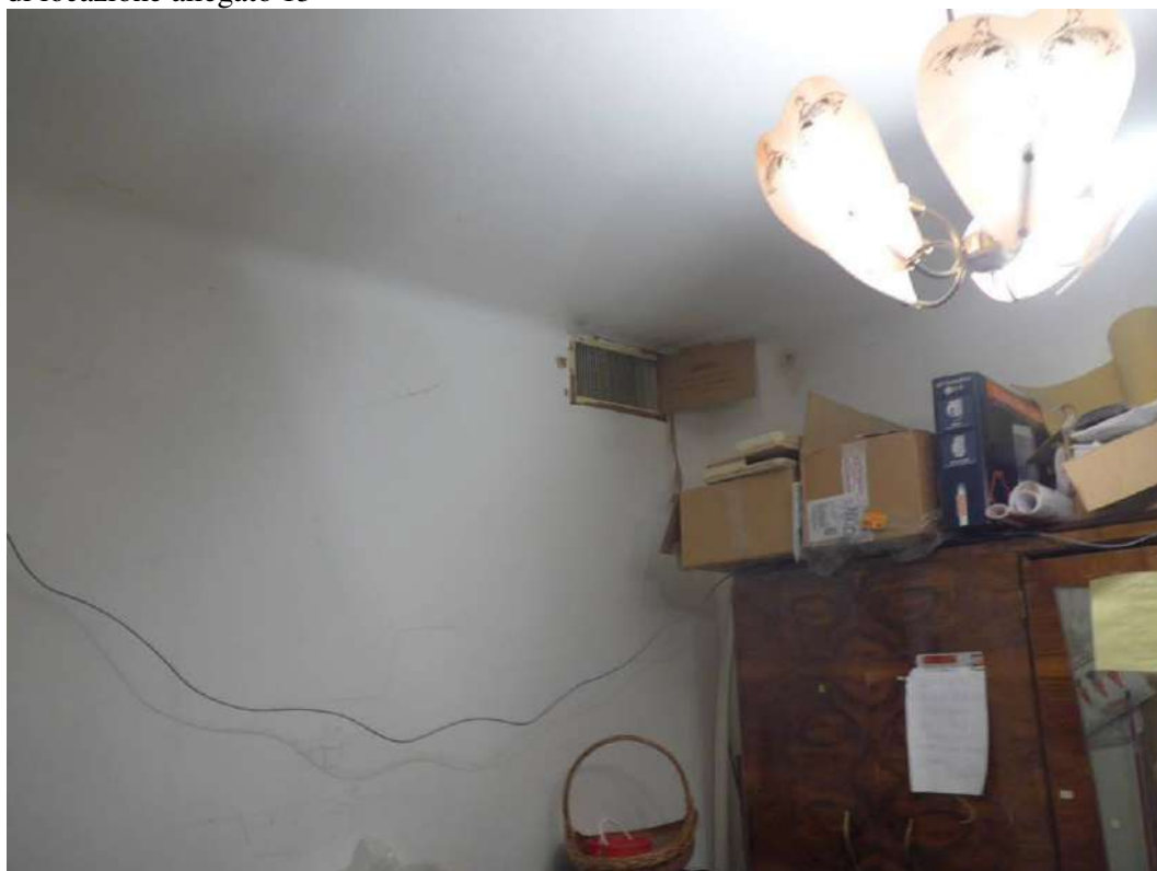
FOTO 50 - UFFICIO SUB 1, archivio (locale apparecchiature impianti tecnologici), vedi planimetria catastale allegato 32. Questo vano archivio non risulta locato, vedi contratto di locazione allegato 13
