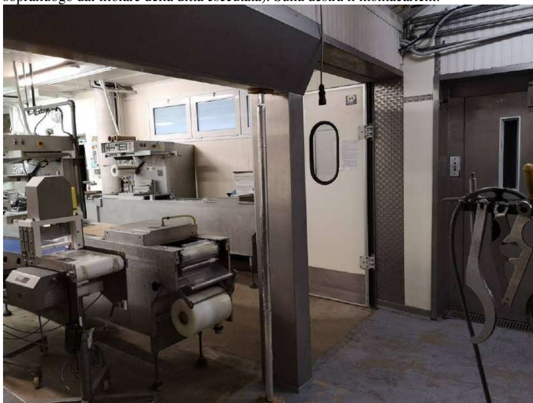
FOTO 210 – STABILIMENTO AL PRIMO PIANO, laboratorio al primo piano. Vano identificato nella planimetria catastale allegato 31 con il numero 1 e con altezze di m. 2,60, m. 3,95 e m. 2,60 (nella planimetria catastale). Visibile delle puntellazioni eseguite con tubi innocenti, realizzate in seguito alla rimozione di un pilastro (come segnalato in sopralluogo dal titolare della ditta esecutata). Sulla destra il montacarichi.
