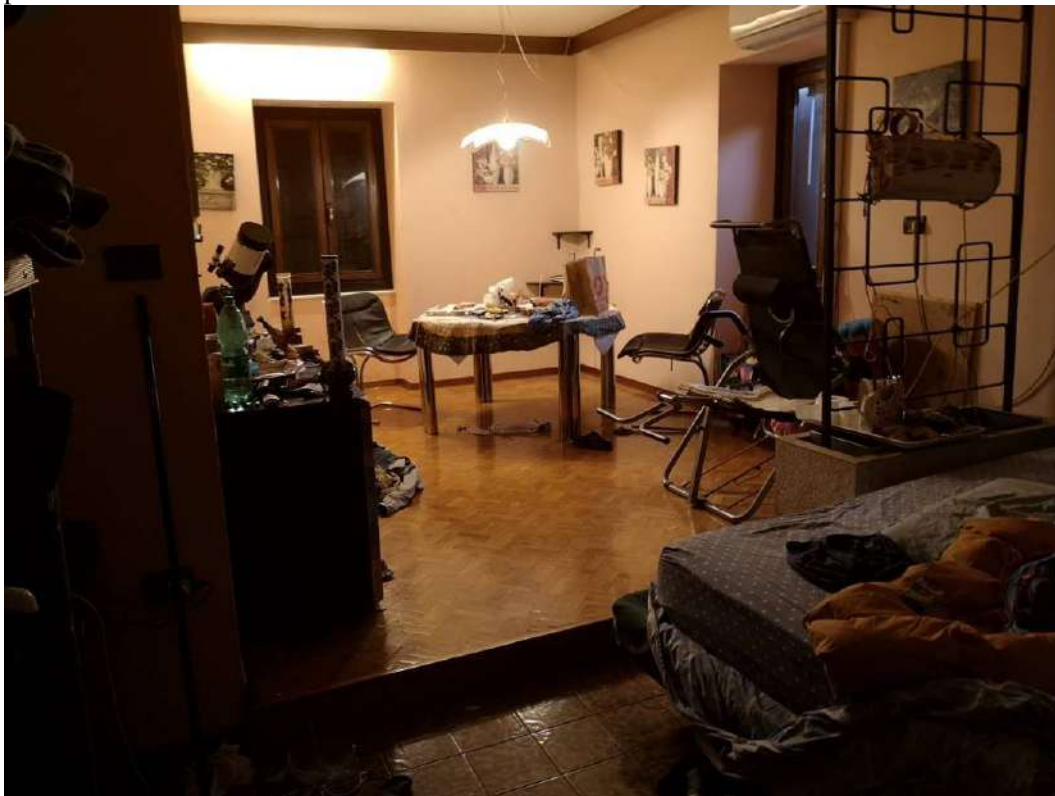
FOTO 77 – ALLOGGIO SUB 2 PRIMO PIANO, soggiorno, vedi planimetria catastale allegato 33. nel soggiorno risulta presente un salto di quota di circa 10 centimetri sulla pavimentazione.
