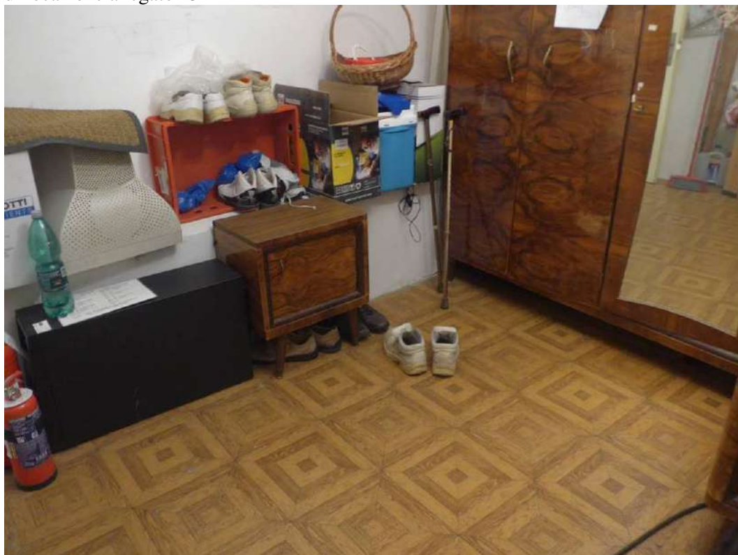
FOTO 49 - UFFICIO SUB 1, archivio (locale apparecchiature impianti tecnologici), vedi planimetria catastale allegato 32. Questo vano archivio non risulta locato, vedi contratto di locazione allegato 13
