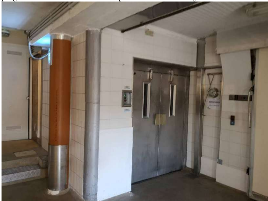
FOTO 126 – STABILIMENTO AL PIANOTERRA, scarico merci, particolare del montacarichi, sulla destra si trova la cella n. 4. Zona corrispondente al pianoterra al vano più grande identificato con il n. 2 nella planimetria catastale allegato 31
