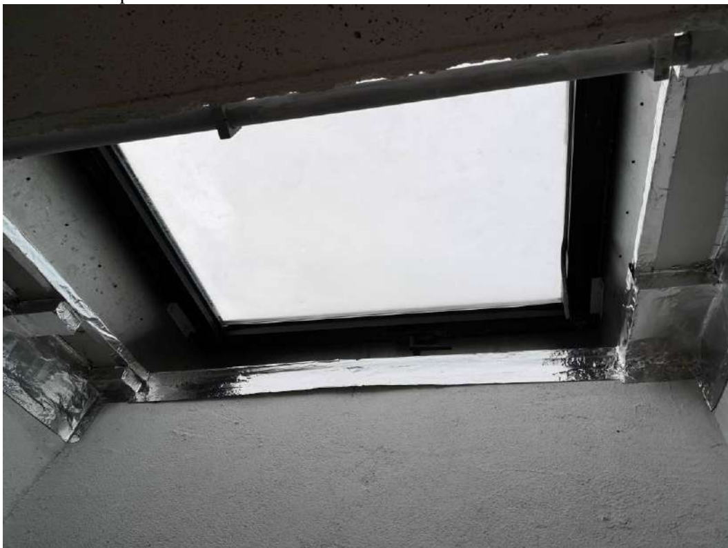
FOTO 250 – STABILIMENTO AL PRIMO PIANO, deposito, vano che si identifica con il n. 2 nella planimetria catastale e con altezza interna 225 (vedi allegato 31). Particolare del lucernario presente
