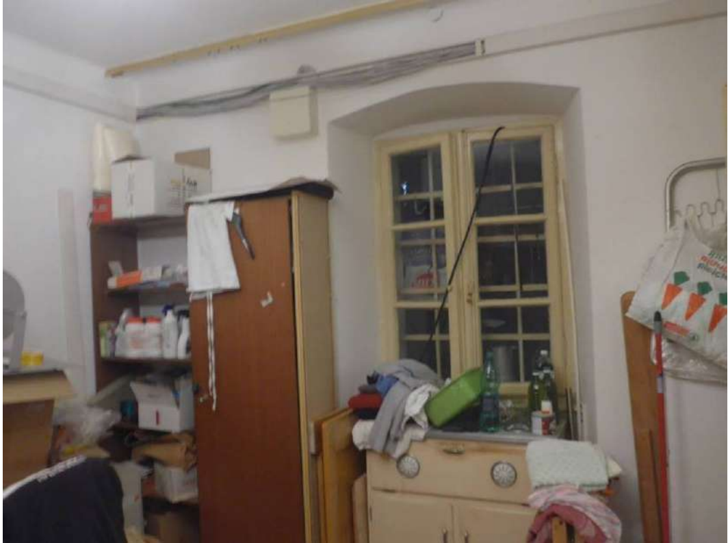
FOTO 47 – UFFICIO SUB 1, archivio (locale apparecchiature impianti tecnologici), vedi planimetria catastale allegato 32. Si evidenzia che la finestra prospetta su un vano ripostiglio presente nel portico, vano non rappresentato nella planimetria catastale allegato 32, vedi foto 30. (Questo ufficio – archivio, non risulta locato, vedi contratto di locazione allegato 13)
