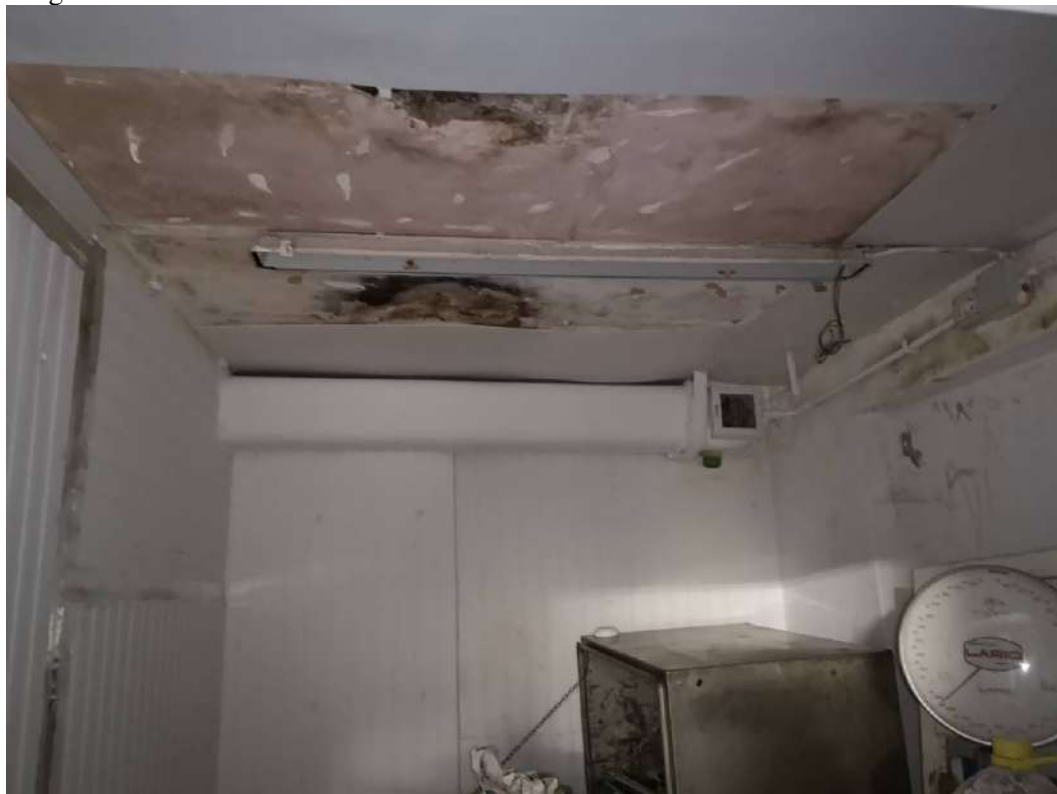
FOTO 173 – STABILIMENTO AL PIANOTERRA, disimpegno-locale idropulitrice. Vano con soprastante la terrazza al primo piano, dove si trovano i compressori delle celle frigorifero. Sulla sinistra si trova il vano aromi (chiuso per infiltrazioni d'acqua). Visibili anche in questo vano segni di infiltrazione d'acqua, vedi progetto di variante in sanatoria allegato 49
