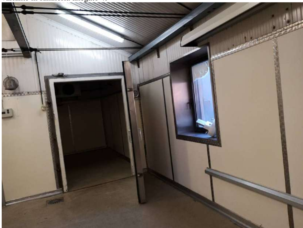
FOTO 214 – STABILIMENTO AL PRIMO PIANO, laboratorio. Vedi planimetria catastale allegato 31, il vano identificato con il numero 1 che riporta una altezza variabile di m. 2,60, m. 3,95 e 3,20 (altezza indicata nella planimetria catastale), vedi progetto di variante in sanatoria allegato 49
