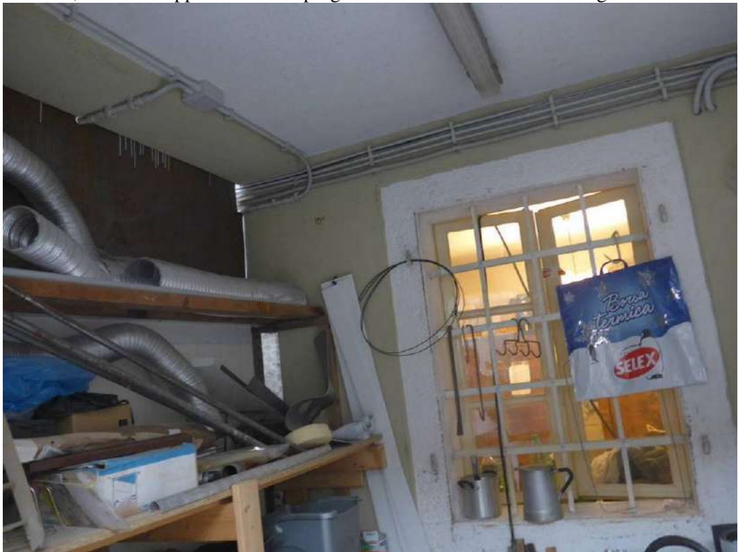
FOTO 64 – UFFICIO SUB 1, vano ripostiglio ricavato con una pannellatura a scapito del portico, vedi planimetria catastale allegato 32, vedi foto 30 e 59. La finestra è quella dell'archivio, vedi foto 47 e 48. Il ripostiglio non è rappresentato nella planimetria catastale, mentre è rappresentato nel progetto di variante in sanatoria allegato 49
