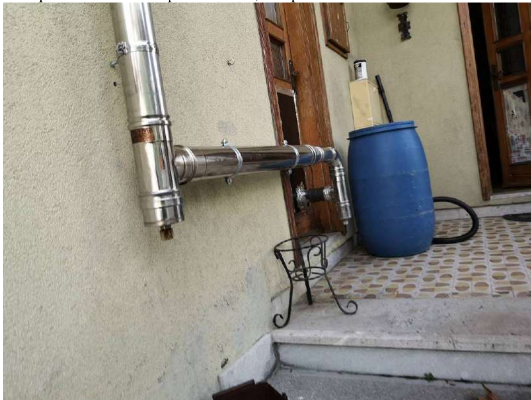
FOTO 67– ALLOGGIO SUB 2 PRIMO PIANO, rampa scale esterna che permette l'accesso all'alloggio al primo piano, vedi foto 23, 24 e 25 e 29. Per l'accesso all'alloggio non è possibile utilizzare la porta a sinistra, vedi pure foto 27 e 28.
