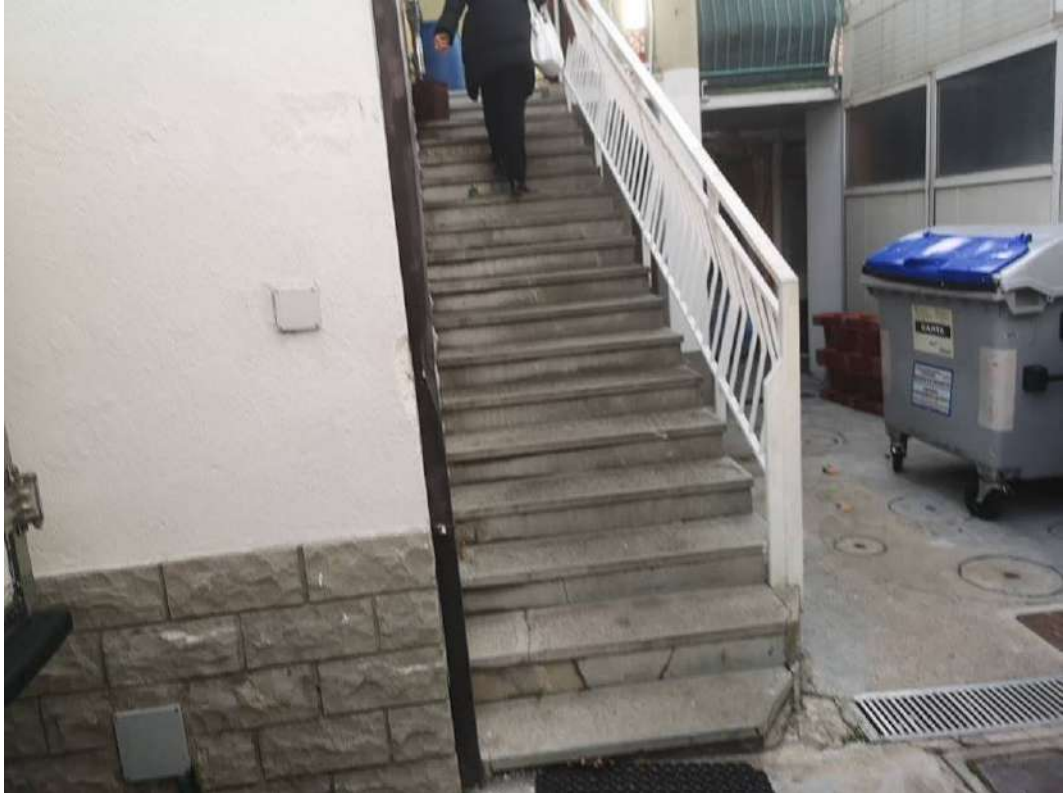
FOTO 23 – immagine ripresa dal cortile p.c.ed. 211/2 censita nel c.t. 1° della P.T 1277 del C.C. di Monti, sulla sinistra l'edificio eretto sulla p.c.ed. 211/1, in primo piano la rampa scale della p.c.ed.211/1 che permette l'accesso all'alloggio sito al primo piano (sub 2, vedi planimetria catastale allegato 33 e vedi estratto mappa allegato 6), sulla destra l'edificio eretto sulla p.c.ed. 211/2
