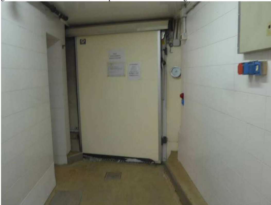
FOTO 127 – STABILIMENTO AL PIANOTERRA, scarico merci, sul fondo la cella 2, a sinistra la sala macchina montacarichi. Zona corrispondente al pianoterra al vano più grande identificato con il n. 2 nella planimetria catastale allegato 31
