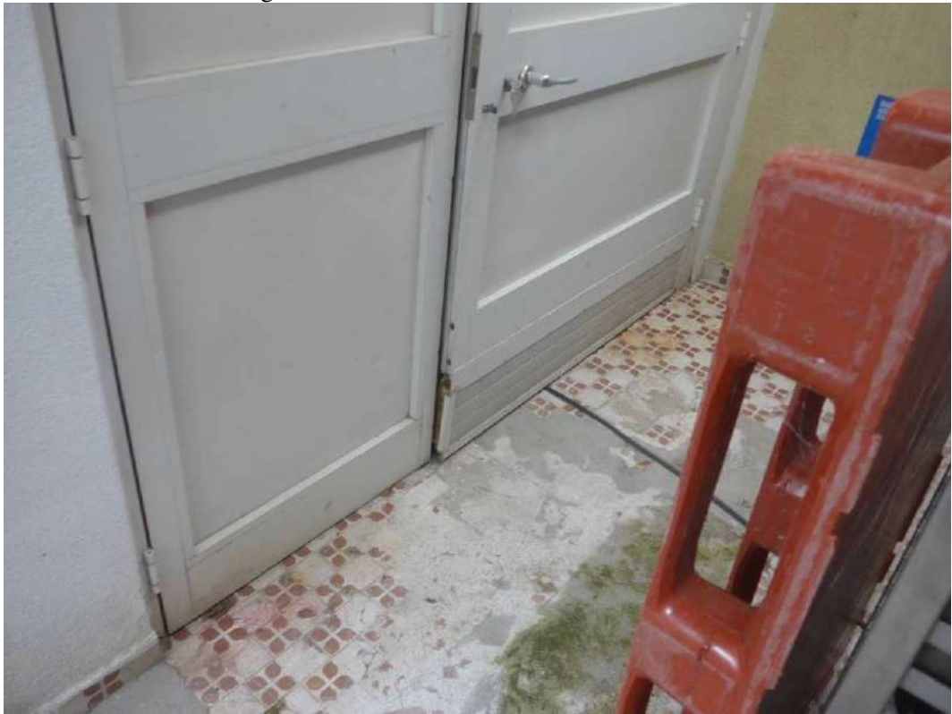
FOTO 63 – UFFICIO SUB 1, ingresso al vano ripostiglio ricavato con una pannellatura a scapito del portico, vedi planimetria catastale allegato 32, vedi foto 30 e 59. Il ripostiglio non è rappresentato nella planimetria catastale, mentre è rappresentato nel progetto di variante in sanatoria allegato 49
