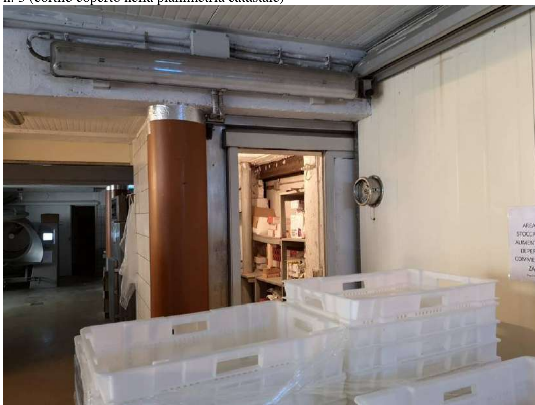
FOTO 123 – STABILIMENTO AL PIANOTERRA, scarico merci, la porta aperta sulla destra è quella di un ripostiglio non in uso. Zona corrispondente al pianoterra al vano più grande identificato con il n. 2 nella planimetria catastale allegato 31, sulla destra la cella n. 3 (cortile coperto nella planimetria catastale)
