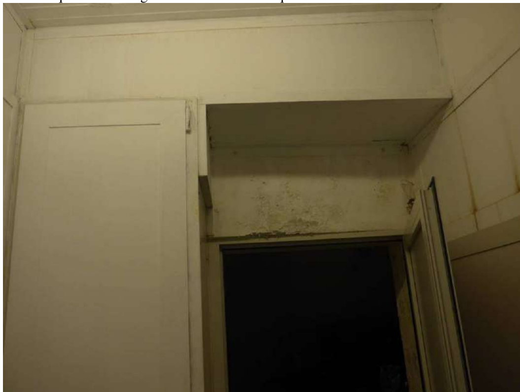
FOTO 170 – STABILIMENTO AL PIANOTERRA, disimpegno-locale idropultrice. Vano con soprastante la terrazza al primo piano, dove si trovano i compressori delle celle frigorifero. Sulla sinistra si trova il vano aromi (chiuso per infiltrazioni d'acqua). Visibili anche in questo vano segni di infiltrazione d'acqua.
