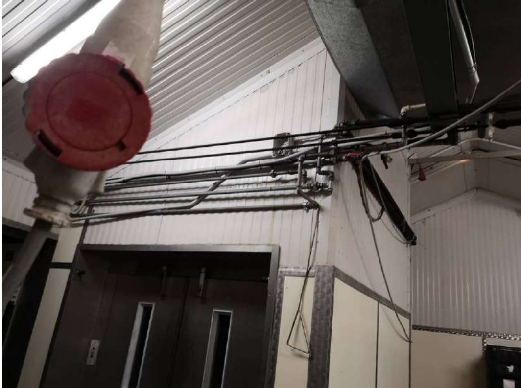
FOTO 189 – STABILIMENTO AL PRIMO PIANO, laboratorio, particolare del montacarichi che permette l'accesso al vano scale di comunicazione con il pianoterra. Vedi planimetria catastale allegato 31, il vano identificato con il numero 1 che riporta una altezza variabile di m. 260, m. 3,95 e m. 2,60 (altezze riportate nella planimetria catastale), vedi progetto di variante in sanatoria allegato 49
