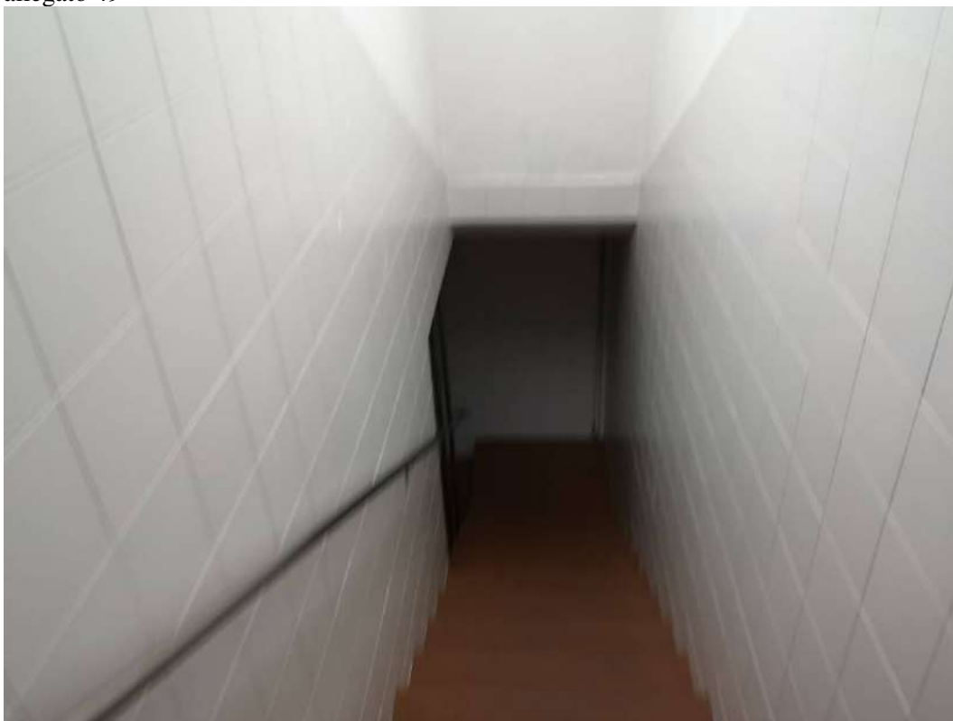
FOTO 185 – STABILIMENTO AL PRIMO PIANO, foto della rampa scale che dal pianoterra conduce al primo piano (vedi foto 132). La scala conduce al laboratorio al primo piano (vedi planimetria catastale allegato 31), vedi progetto di variante in sanatoria allegato 49
