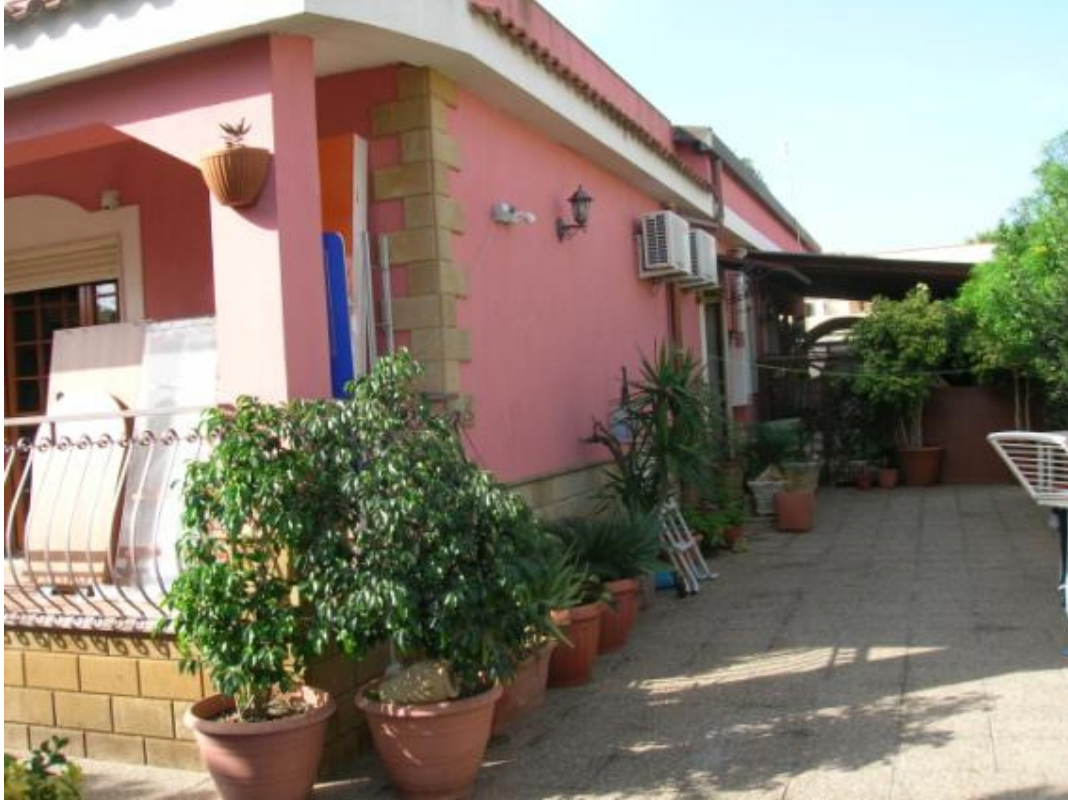
FOTO N.3 – Prospetto lato nord
