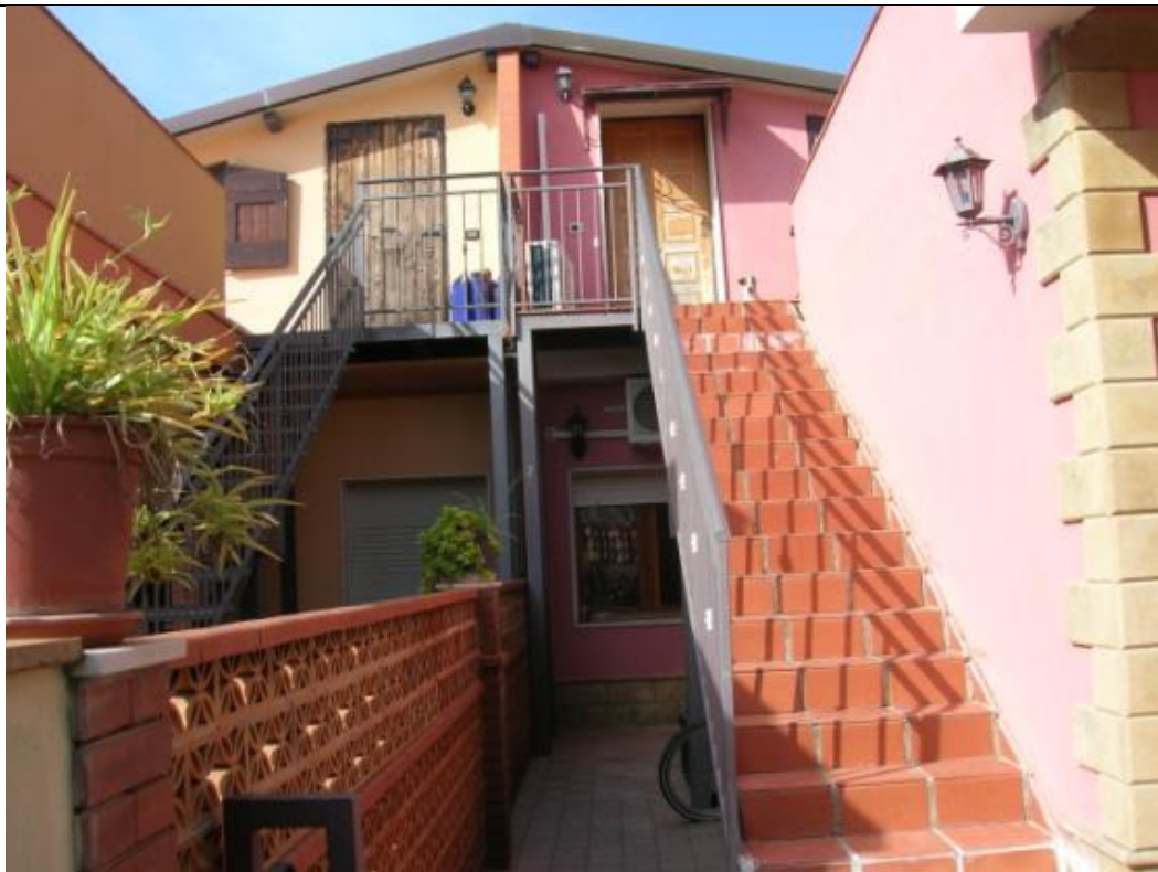
FOTO N.4 – Prospetto lato sud
