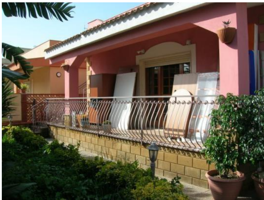
FOTO N.2 – Prospetto lato est
