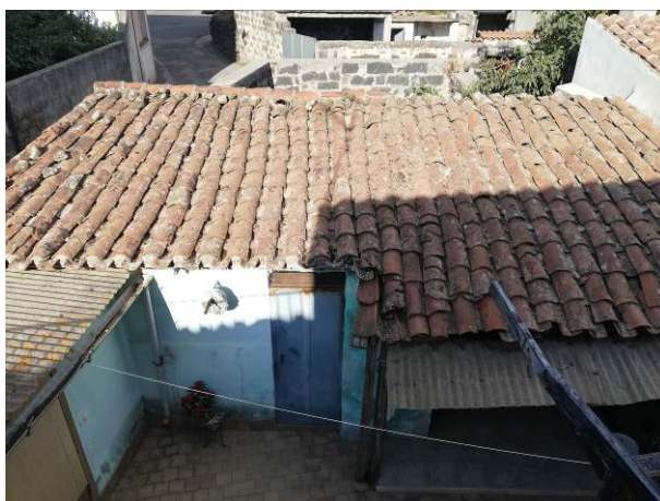
Foto 5 - Blocco 2 - prima costruzione
