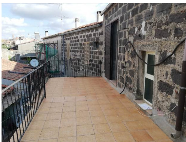
Foto 3 – Copertura a terrazza ampliamento blocco 1
