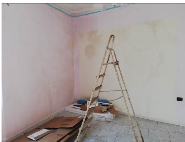
Foto 16 - Camera lato sinistro
