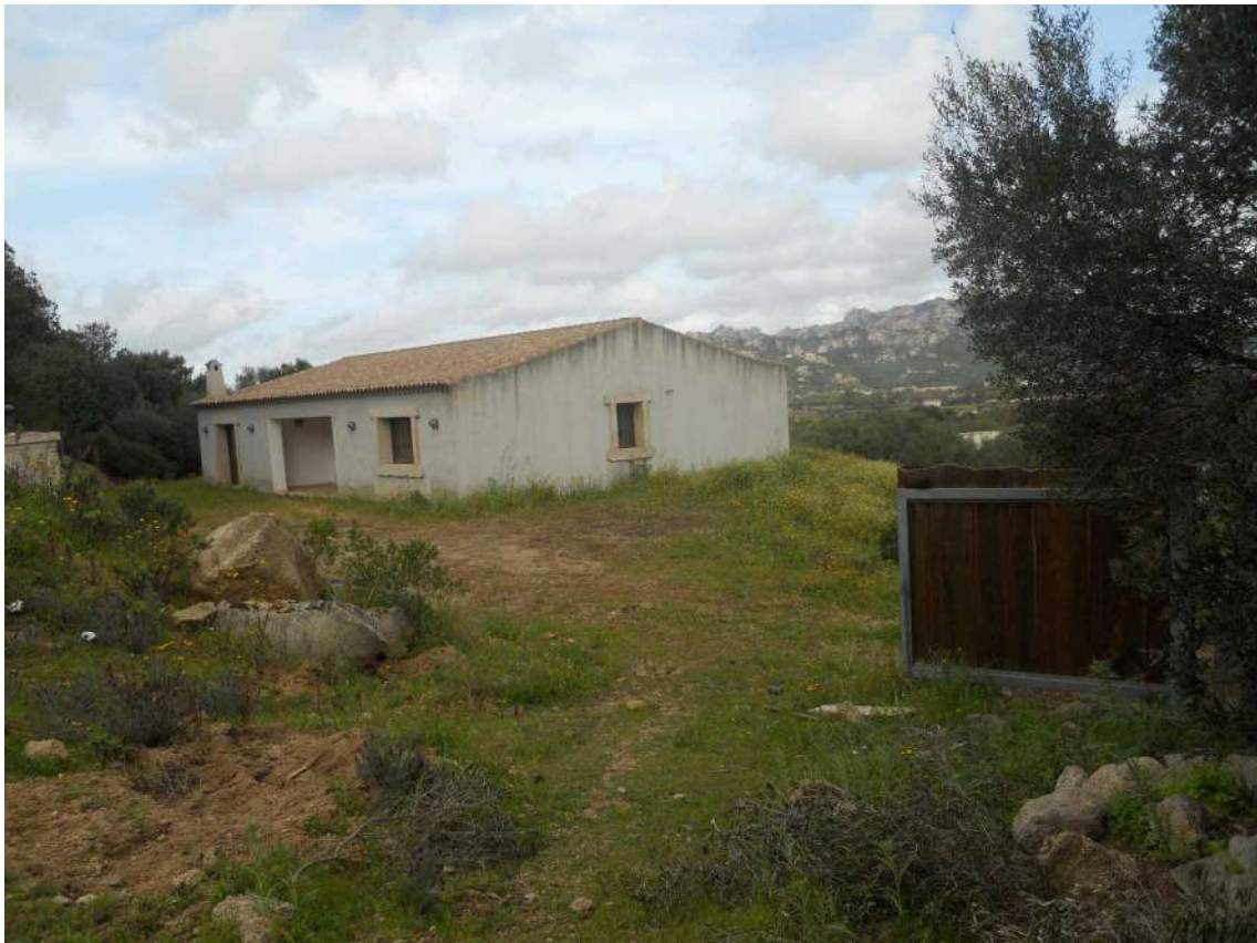
Foto 2: vista del fabbricato, varcato il cancello.
