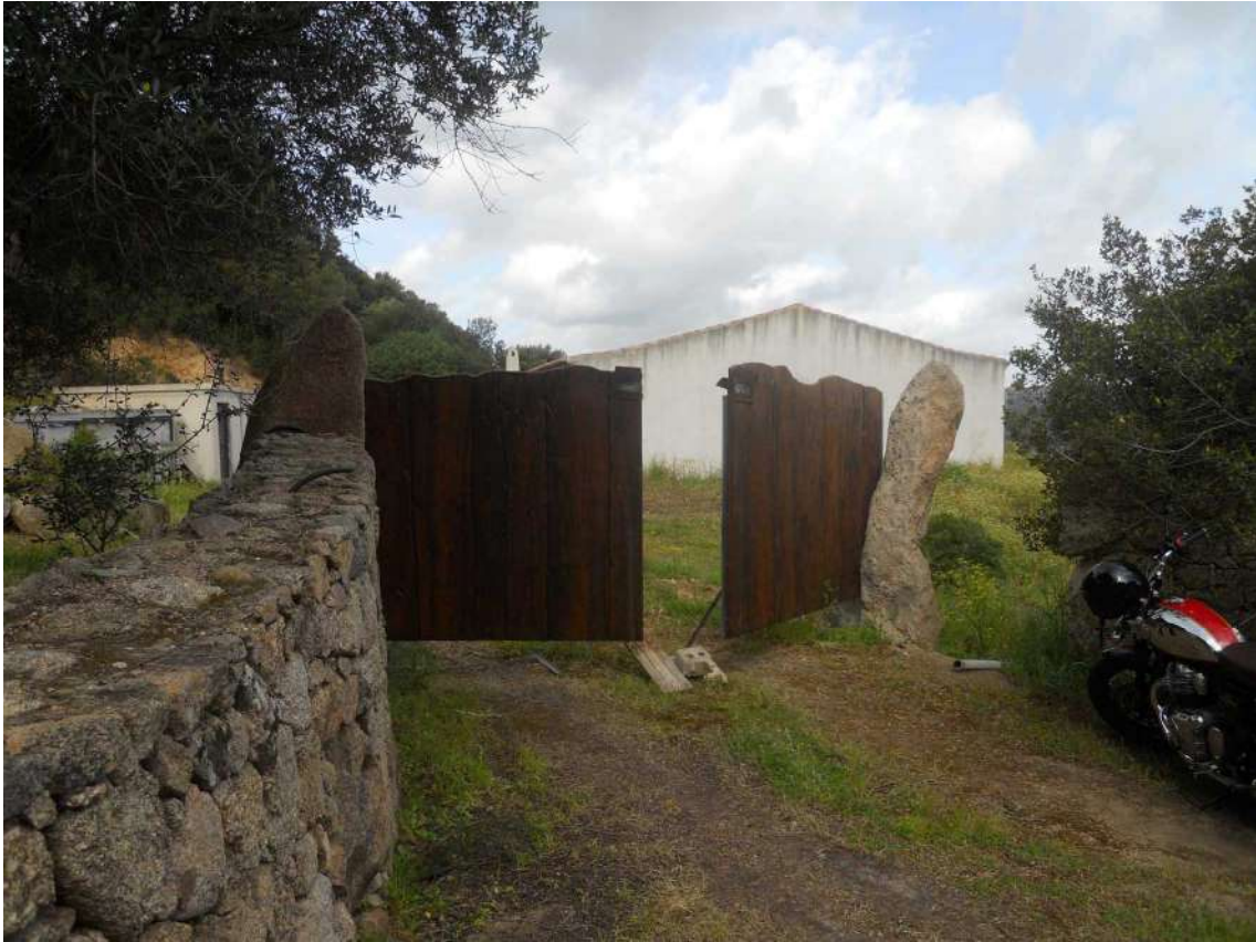
Foto 1: vista del cancello di accesso al compendio pignorato.
