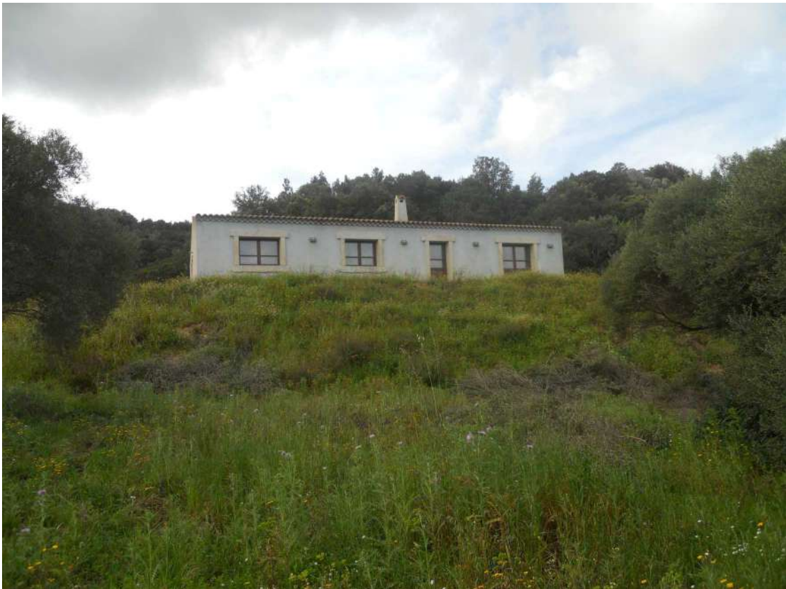
Foto 6: vista di insieme del fabbricato, verso sud.
