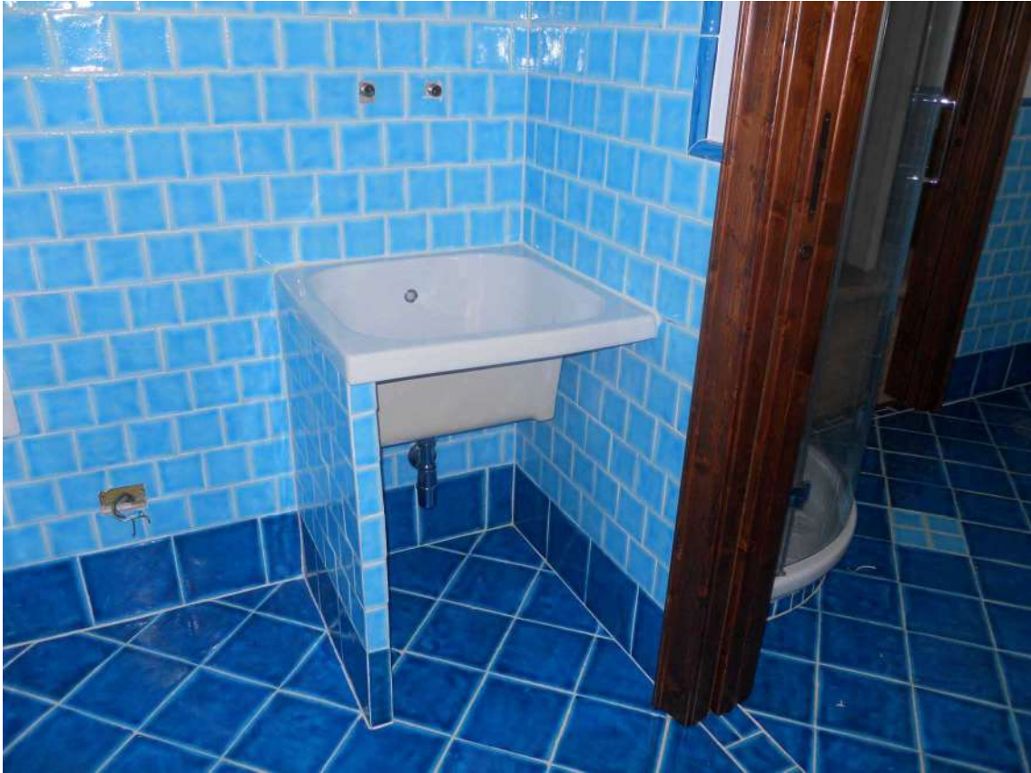
Foto 19: vista della lavanderia adiacente il bagno.
