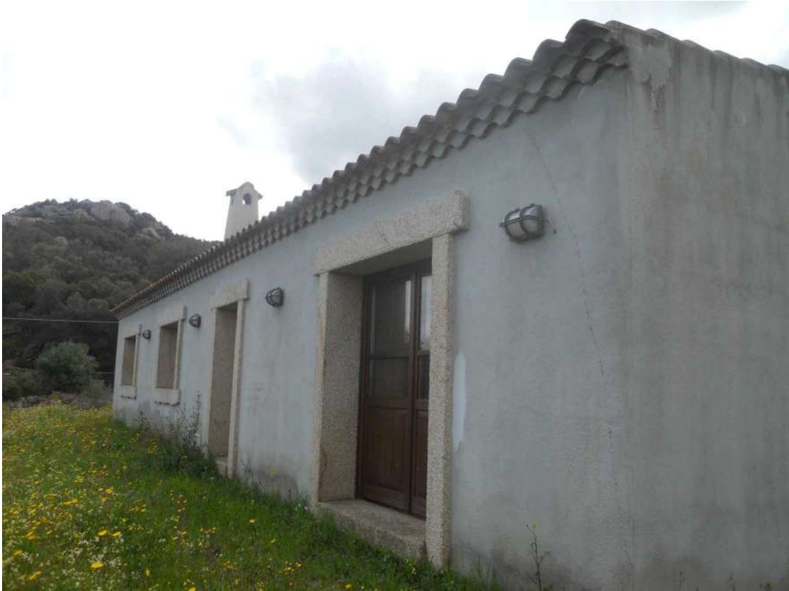
Foto 5: vista di scorcio del fabbricato, prospetto nord.
