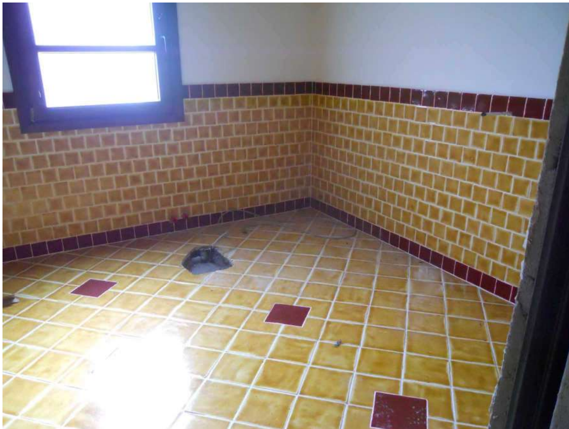
Foto 16: vista del bagno.
