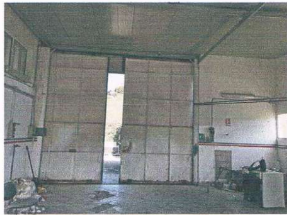
FOTO N. 4 PORTE D'INGRESSO INTERNO
