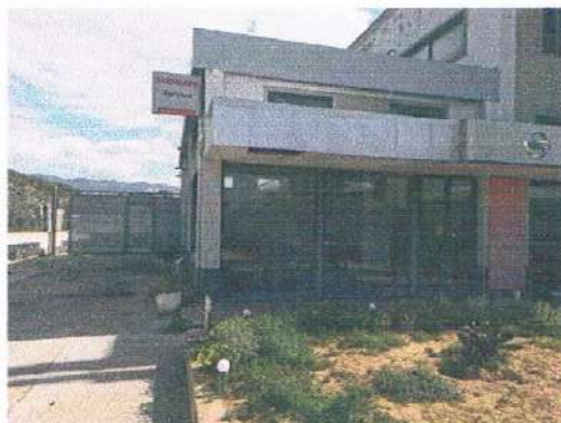
FOTO N. 7 PORTA SCORREVOLE DA RIMUOVERE
