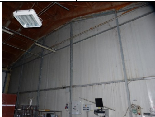
Telaio metallico che sorregge dall'interno, i pannelli sandwich che fungono da tamponamento del prospetto sud
