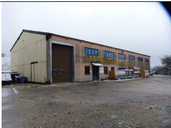
Prospetti Sud con pannelli sandwich a vista, ed Est
