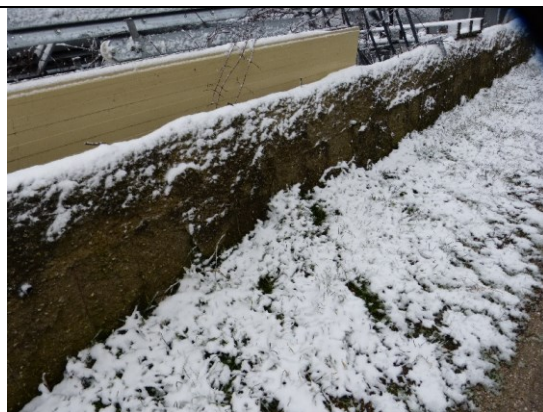
Particolare muro laterale in c.a.
