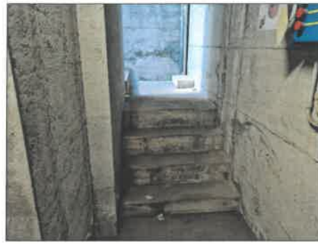
FOTO 14 - ACCESSO TECNICI MANUTENZIONE
