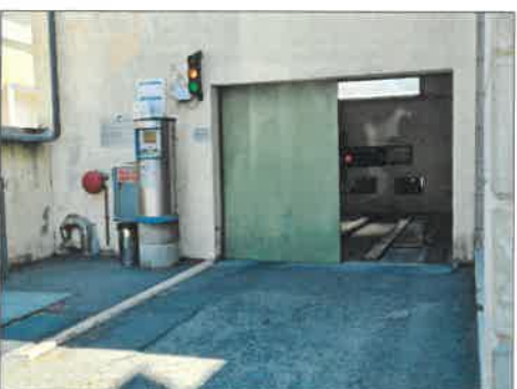
FOTO 10 - PORTONE DI ACCESSO IN FASE DI APERTURA
