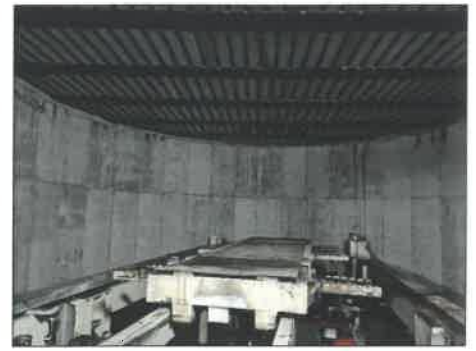
FOTO 15 - VISTA DEI MACCHINARI DEDICATI ALLA MOVIMENTAZIONE
