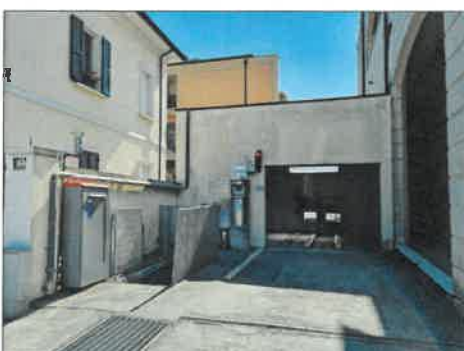
FOTO 11 - AREA DI PARCHEGGIO AUTOVETTURA PRE-MOVIMENTAZIONE
