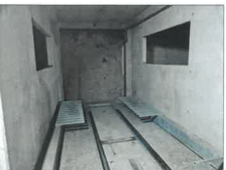
FOTO 22 - VISTA DELL'INTERNO DEL POSTO AUTO
