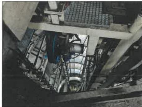
FOTO 17 - VISTA PIANI INTERRATI DELL'AUTOSILO TREVİ PARK
