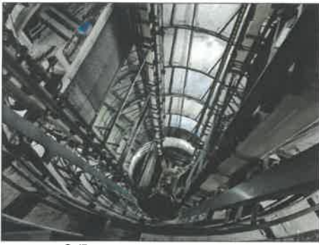
FOTO 25 - TREVI PARK VISTA DALL'ALTO DELL'AUTOSILO
