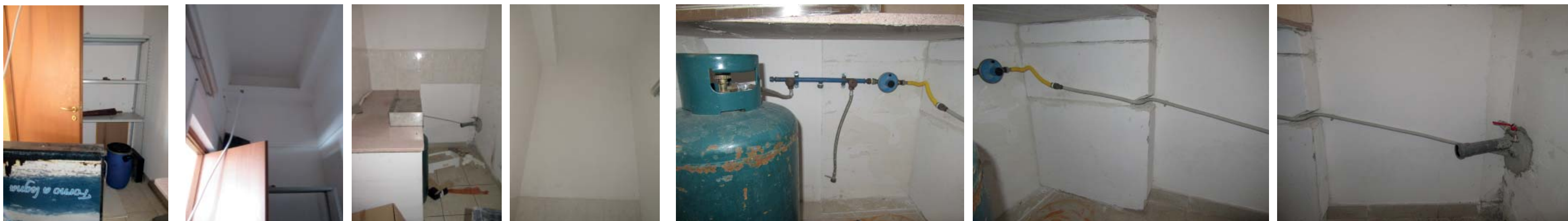
Foto da 72 a 78, vano A2
