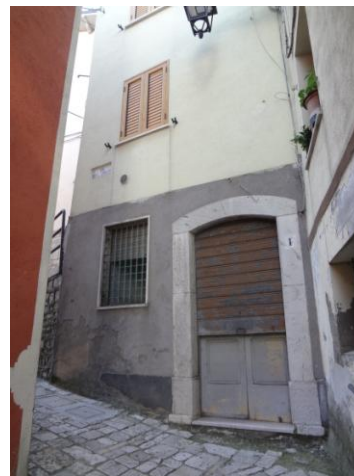
Foto n. 24 Roccavivara - Fg. n. 9 - p.lla n. 338 sub 1 - esterno
