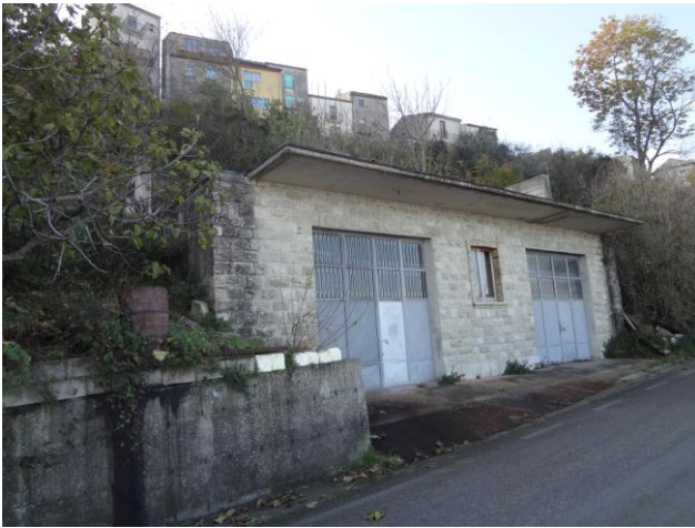
Foto n. 19 Roccavivara - Fg. n. 9 - p.lle n. 189 - 190 - esterno
