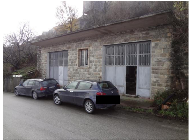
Foto n. 20 Roccavivara - Fg. n. 9 - p.lle n. 189 - 190 - esterno
