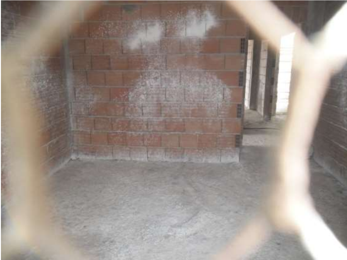
Figura 45 - Piano terzo (Rustico)
