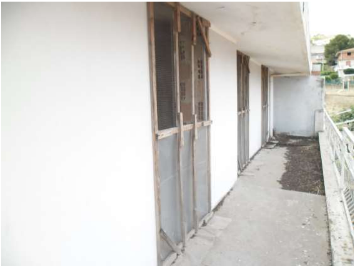
Figura 44 - Piano terzo (Rustico)
