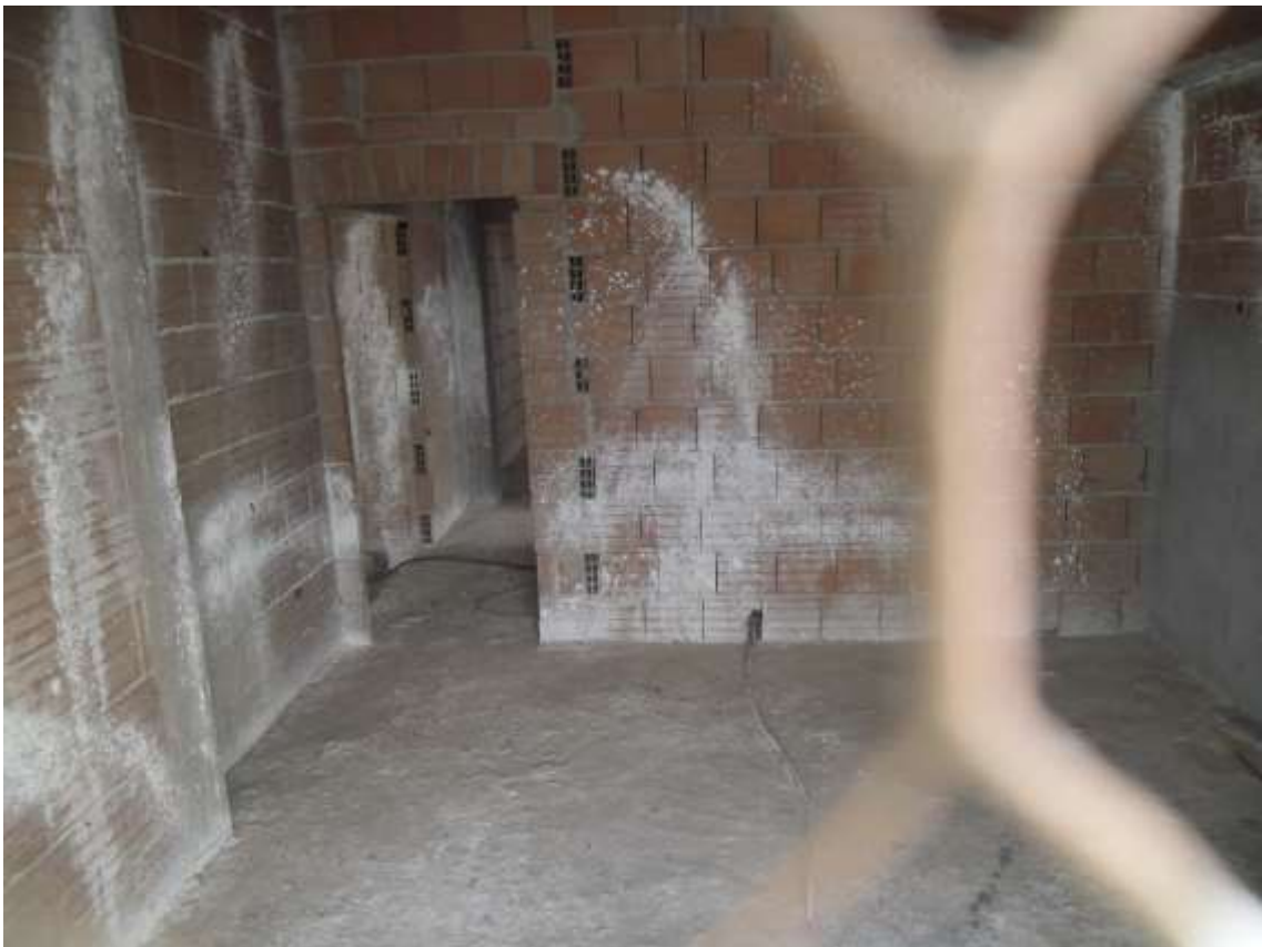
Figura 46 - Piano terzo (Rustico)
