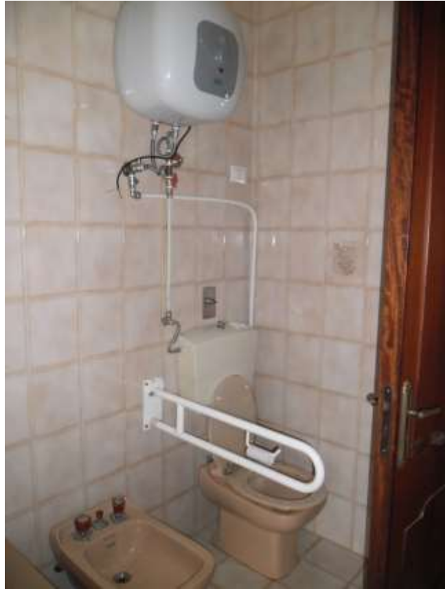
Figura 21 - Piano primo (Bagno)
