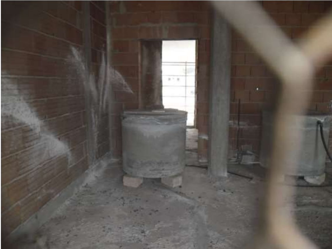
Figura 43 - Piano terzo (Rustico)
