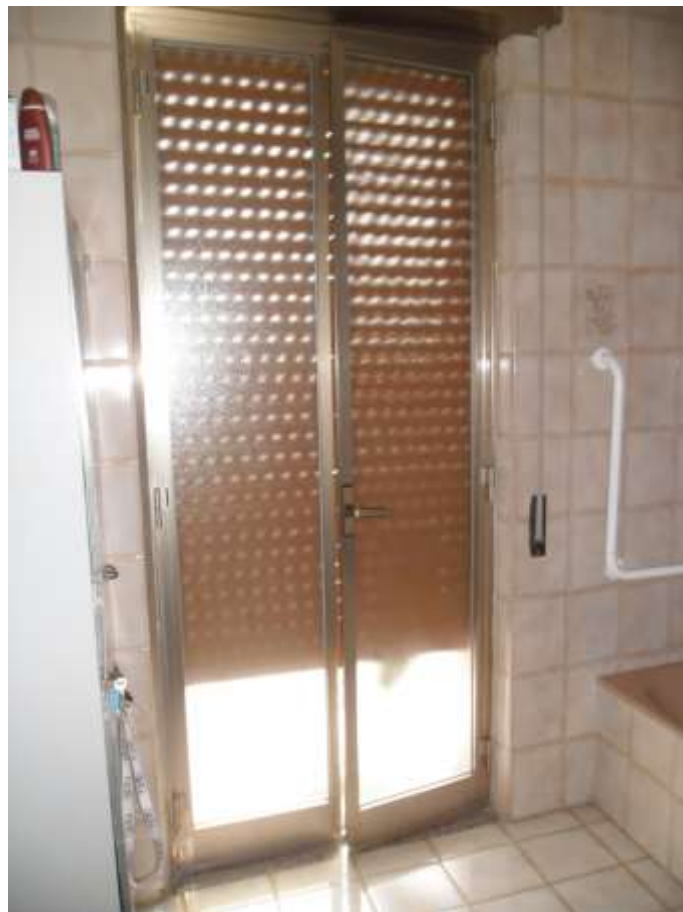
Figura 20 - Piano primo (Infisso bagno)
