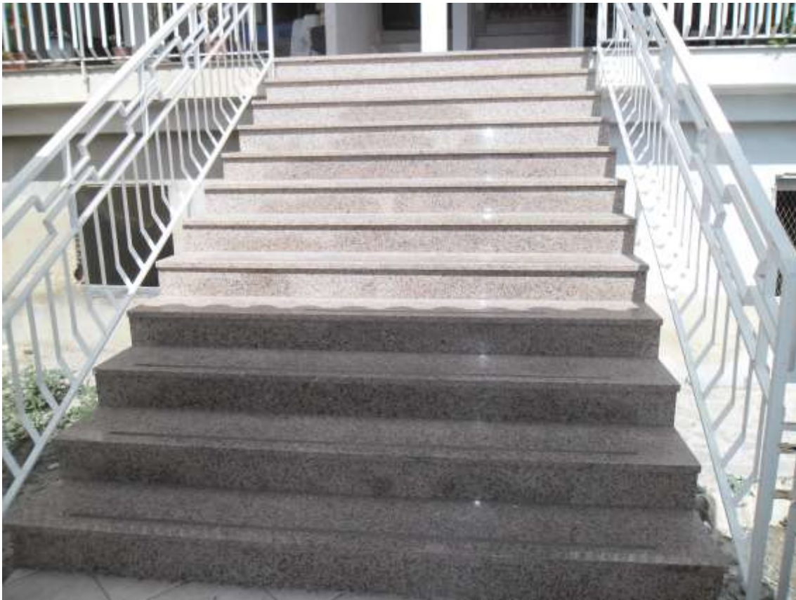
Figura 13 - Elemento di collegamento verticale
