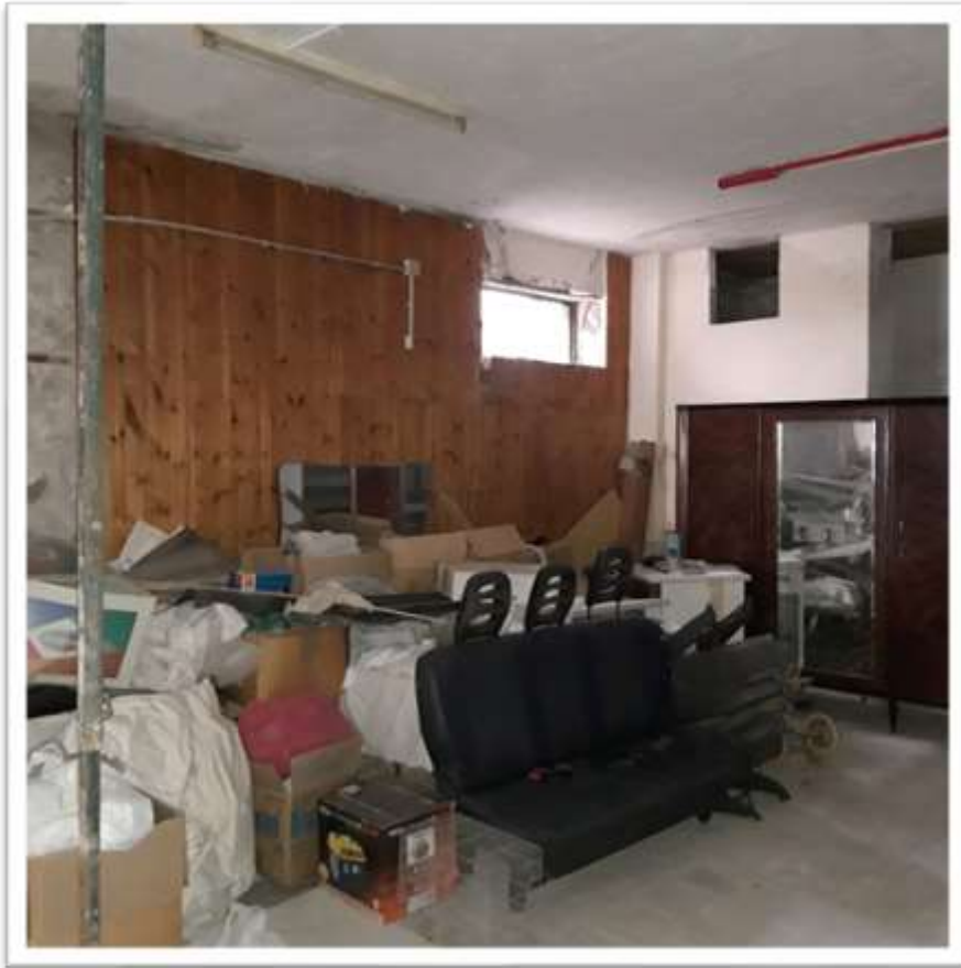
FOTO 7 – FINESTRA LUNGO LA PARETE OVEST
