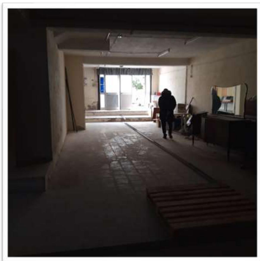
FOTO 5 – PARTE DEL DEPOSITO PROSPICIENTE ALL'INGRESSO
