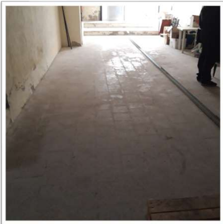
FOTO 12 – PAVIMENTAZIONE DEL DEPOSITO IN GRANIGLIA DI MARMO
