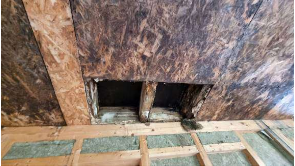
(Sondaggi solaio di piano primo – vista dal piano terra)
