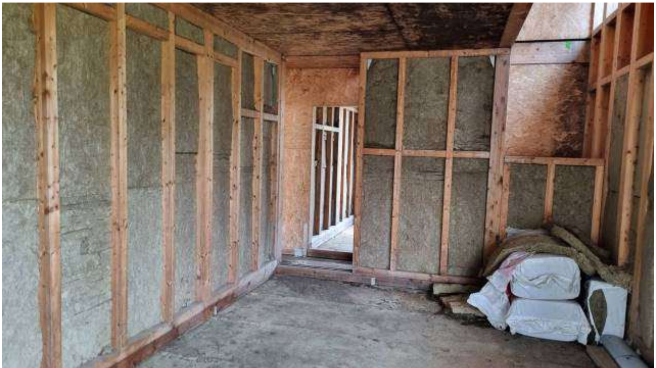
(Pareti Piano Terra)
