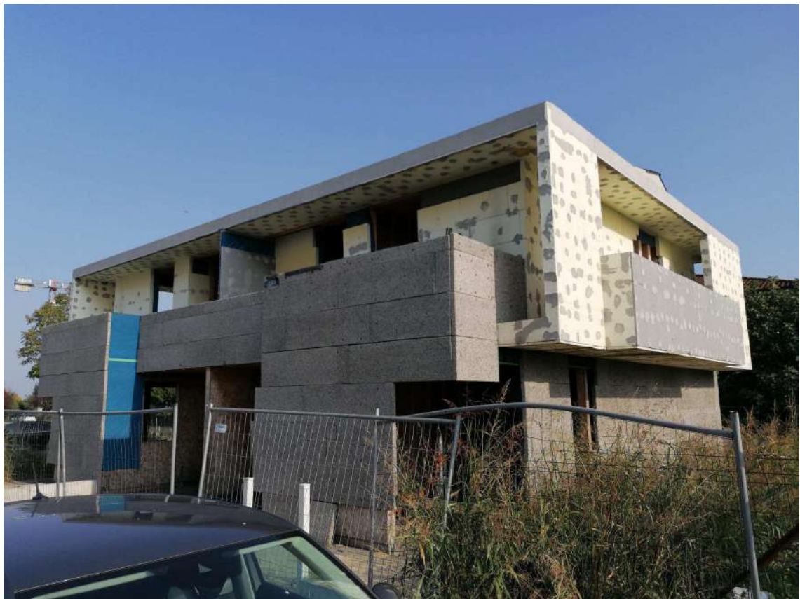
Viste complessivo del fabbricato
