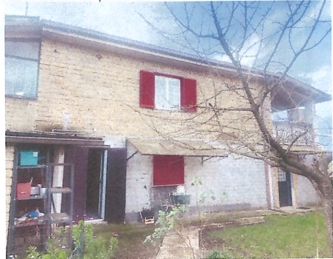
Facciata lato nord-est - punto di vista 4
