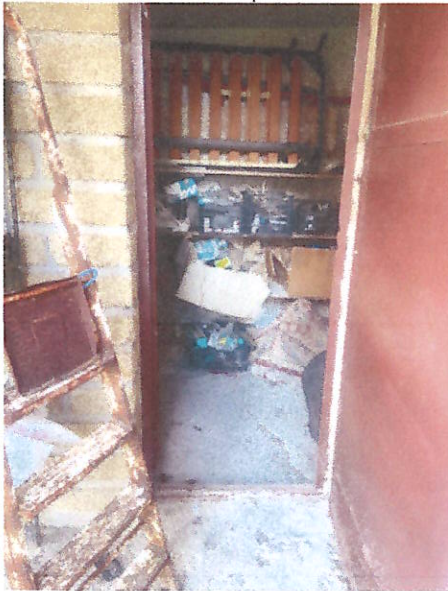
Ripostiglio esterno facciata nord-est - punto di vista 35
