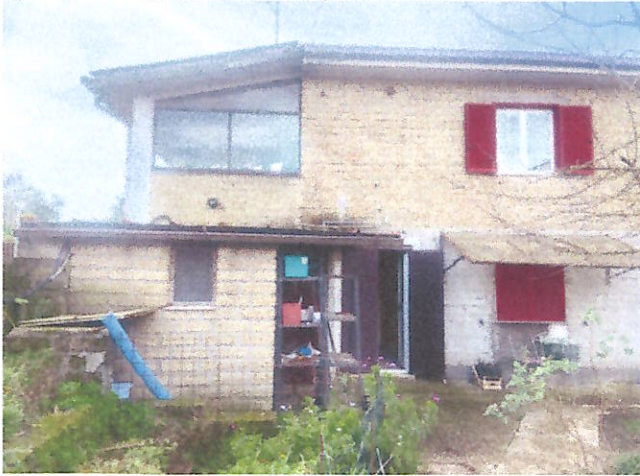
Ripostiglio esterno facciata nord-est - punto di vista 33
