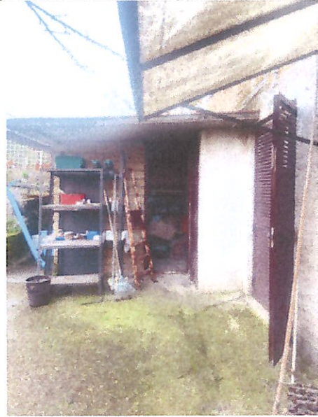
Ripostiglio esterno facciata nord-est - punto di vista 34
