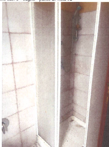
Magazzino sub. 5 - bagno - punto di vista 32
