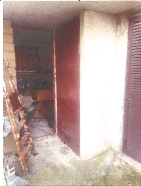
Ripostiglio esterno facciata nord-est - punto di vista 36
