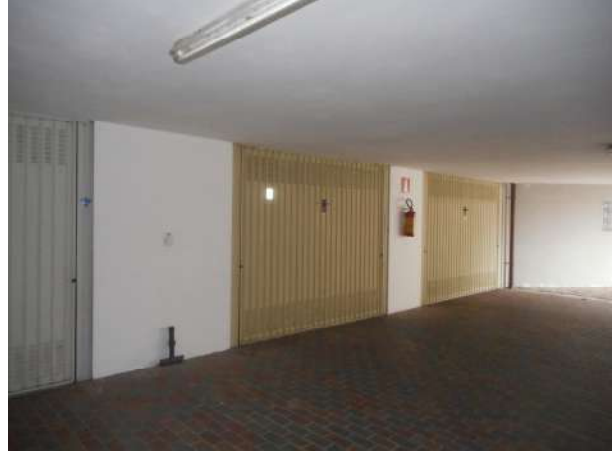
Foto 8 – garage piano interrato
