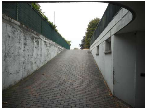
Foto 6 – rampa per i garage
