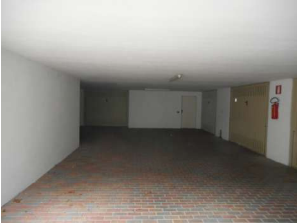
Foto 7 – area manovra comune garage
