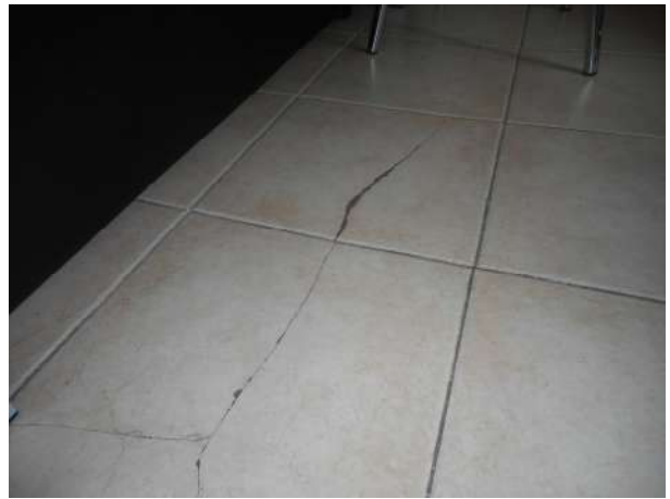
Foto 16 – particolare piastrelle zona giorno
