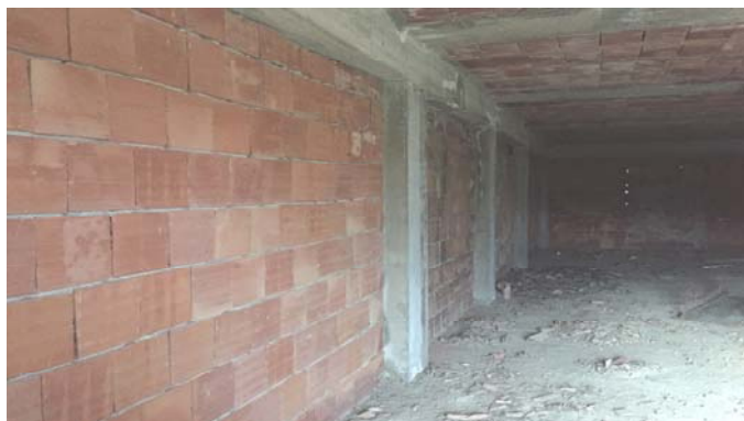
Interni (sub. 8 e 9)
