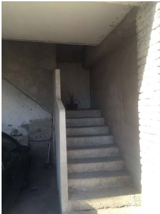
Esterni (corpo scala)
