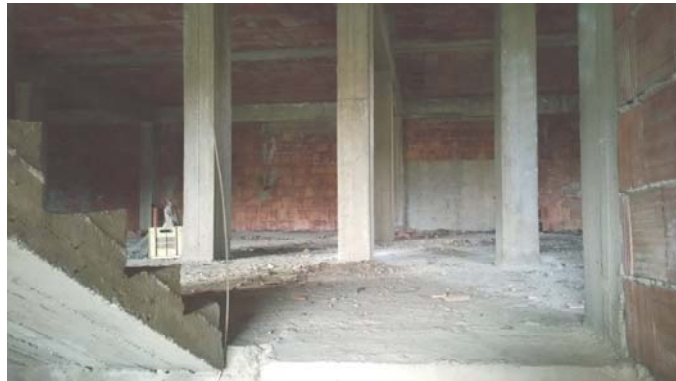
Interni (sub. 8 e 9)
