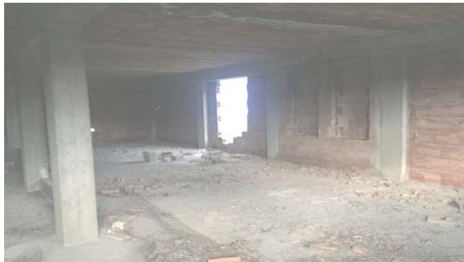
Interni (sub. 8 e 9)
