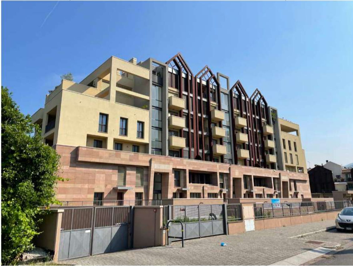
FOTO 1 (vista esterna fabbricato da via Alberto Torricini)
