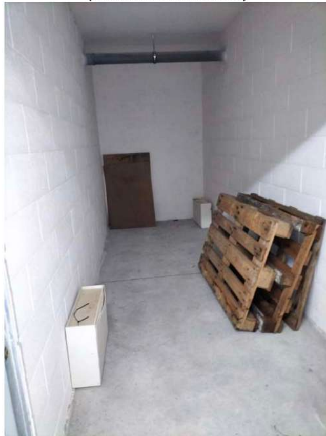
FOTO 16 (vista interna cantina)
