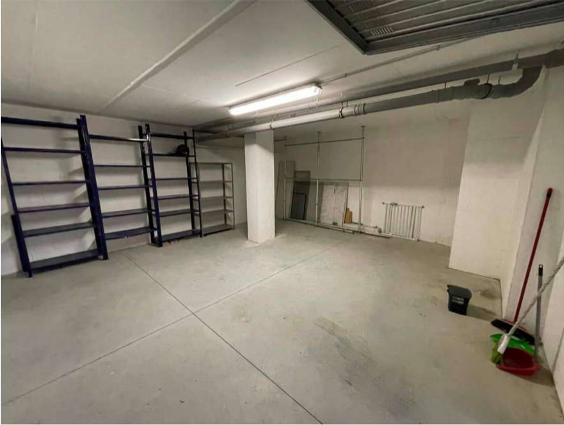
FOTO 15 (vista interna autorimessa)
