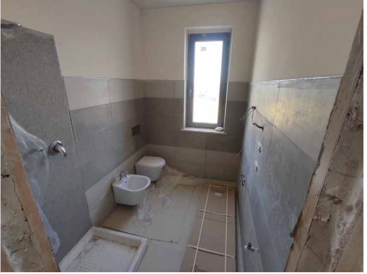
Servizi in camera al piano terra
