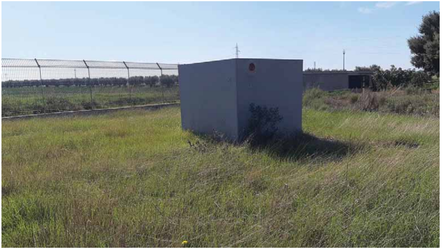
Foto terreno, Foglio 123, part. 45/59/100, impianti tecnologici
