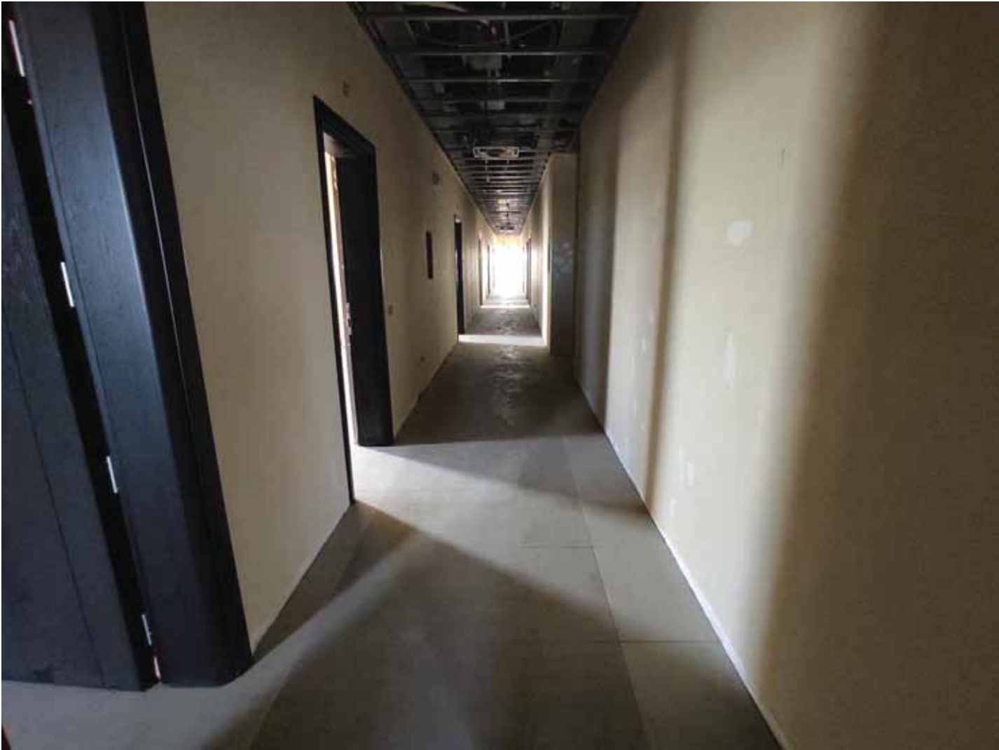
Corridoio piano primo
