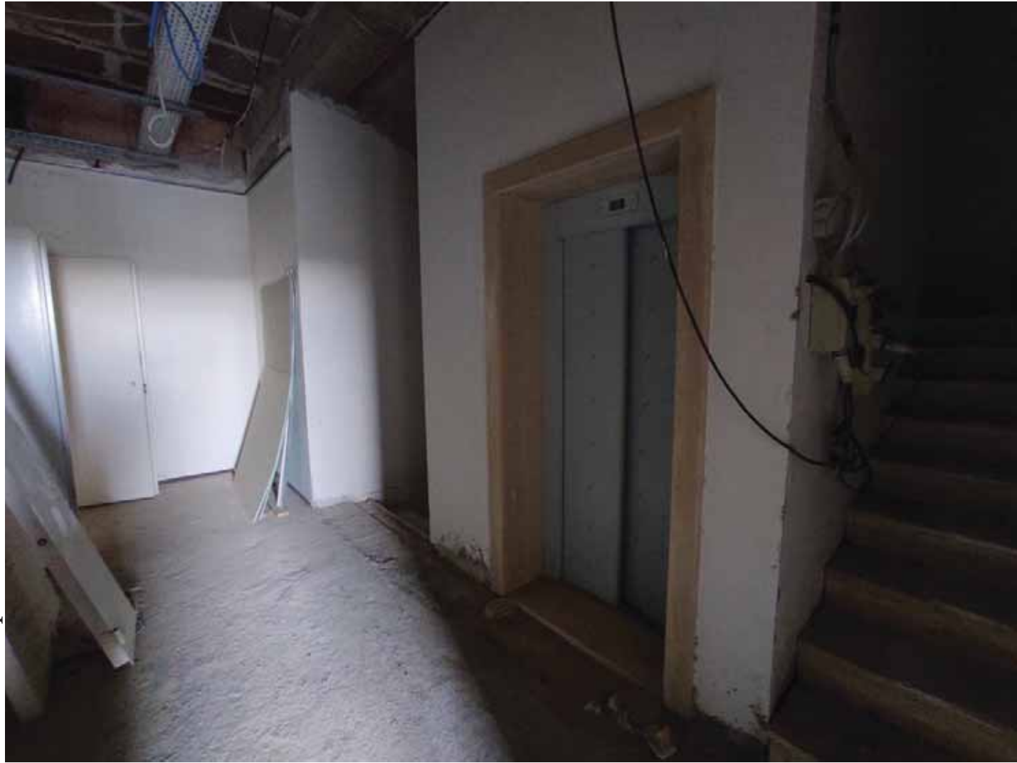
Ascensore piano seminterrato
