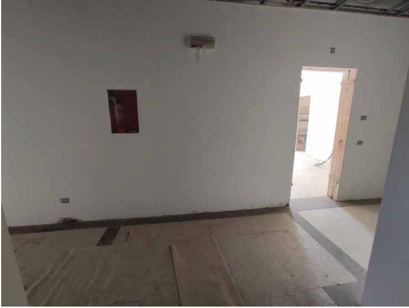
Corridoio piano terra
