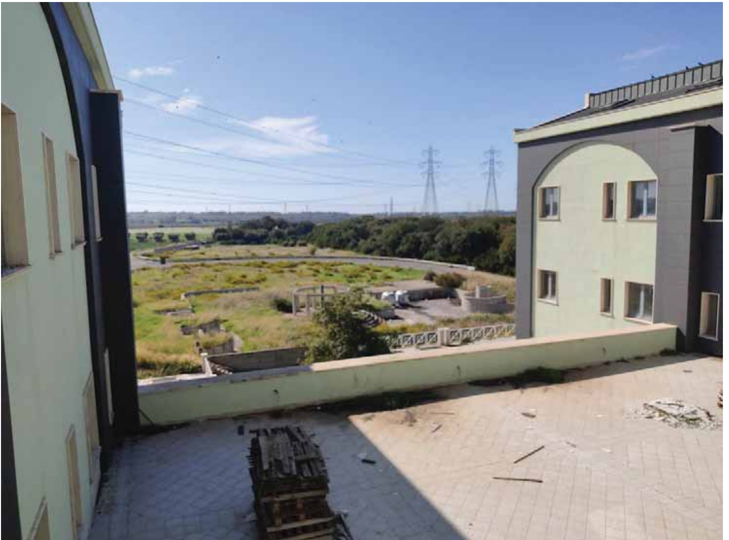
Vista terrazzo da balcone al primo piano
