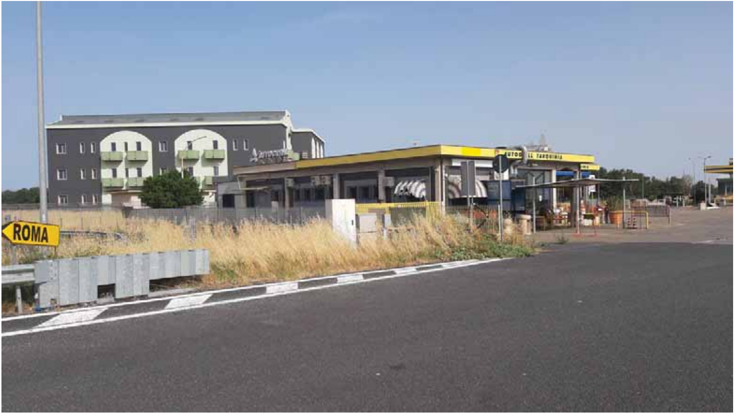
Struttura ricettiva lato autogrill
