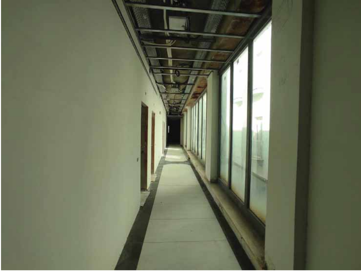
Corridoio piano terra
