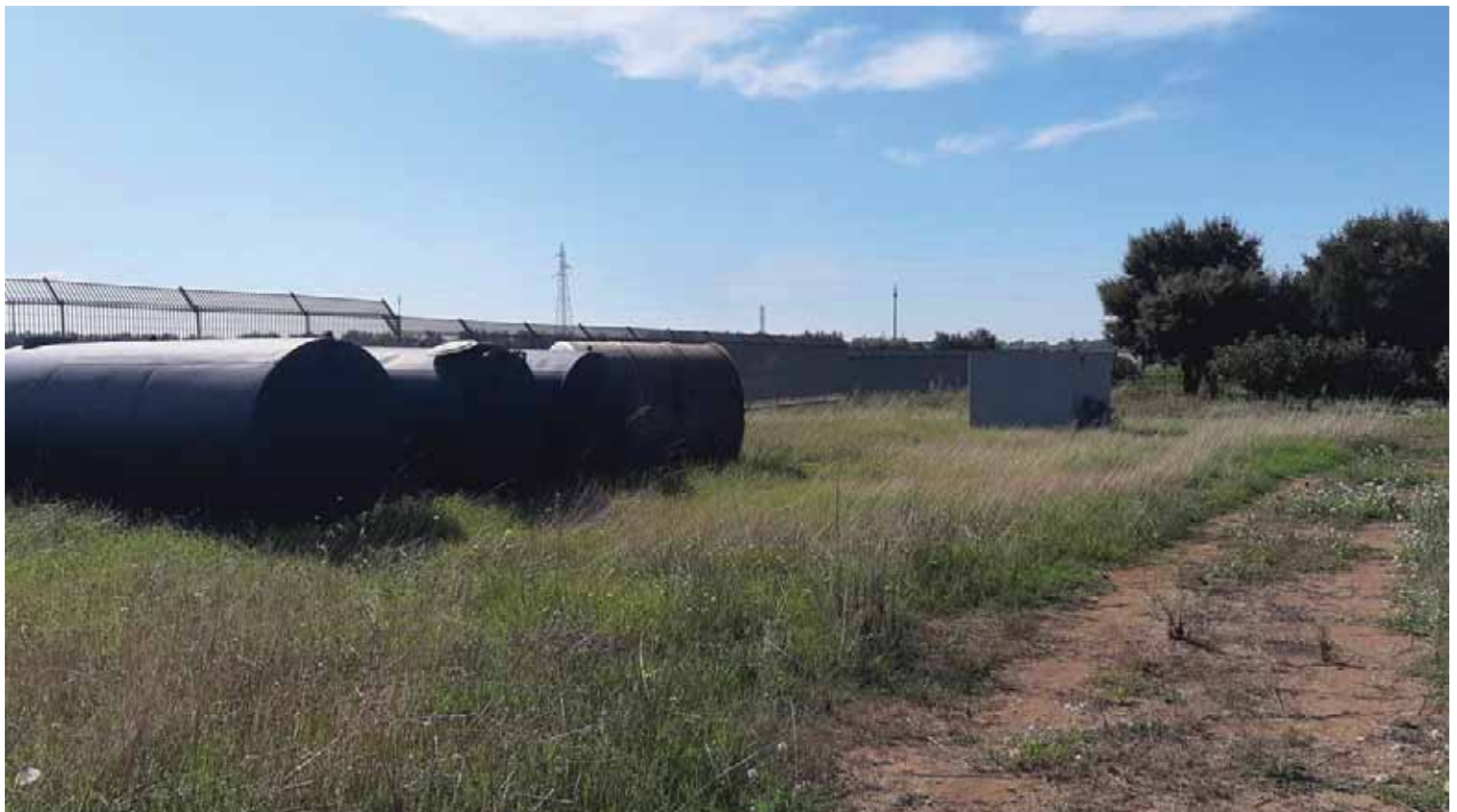
Foto terrreno Foglio 123, part.45/59/100 , impianti tecnologici
