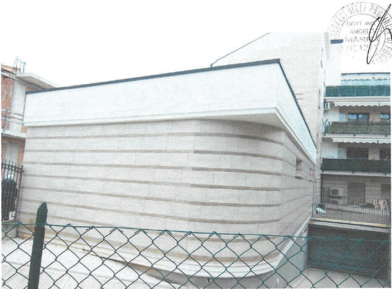
5 – Part. prospetto secondario e laterale locale commerciale in fase di ultimazione via L. B. Alberti
