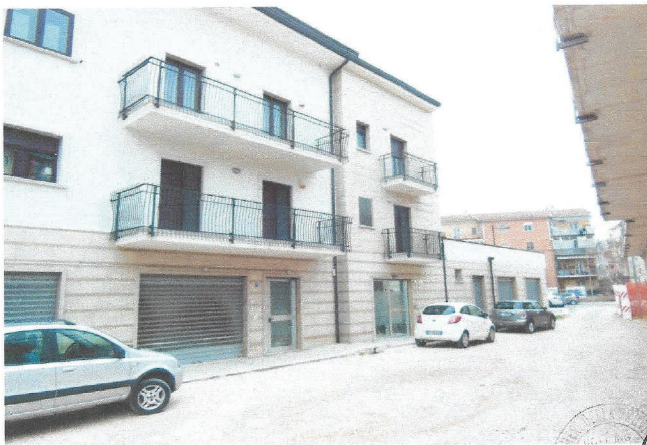
4 – Part. prospetto principale locale commerciale in fase di ultimazione via L. B. Alberti
