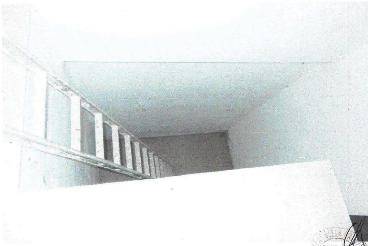
8 – Part. vano scala locale commerciale in fase di ultimazione via L. B. Alberti
