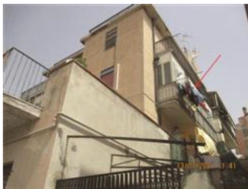
Chiusura a veranda balcone lato EST da parte del debitore MACELI Carmelo
