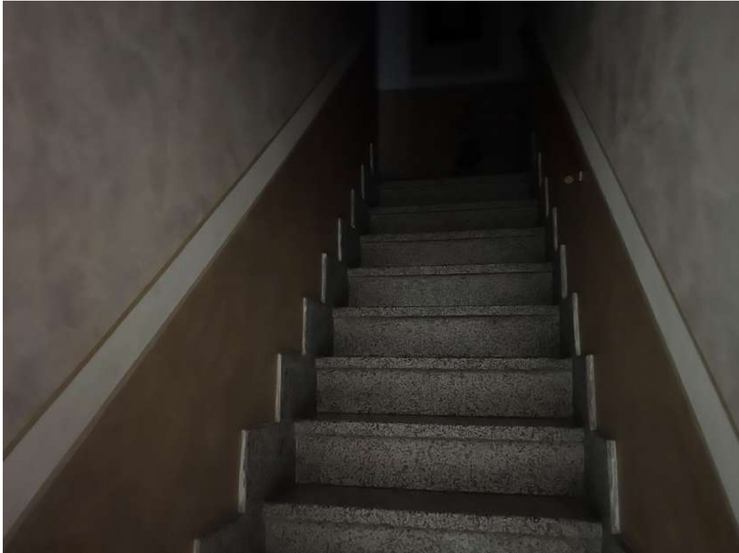
Figura 28 abitazione nm. 153 scala di accesso al P1
