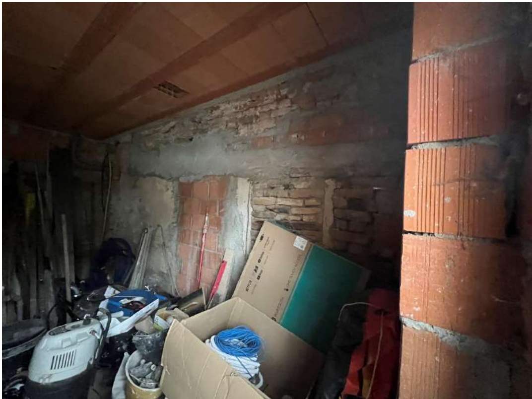
Figura 8 vano al grezzo PT nm. 946
