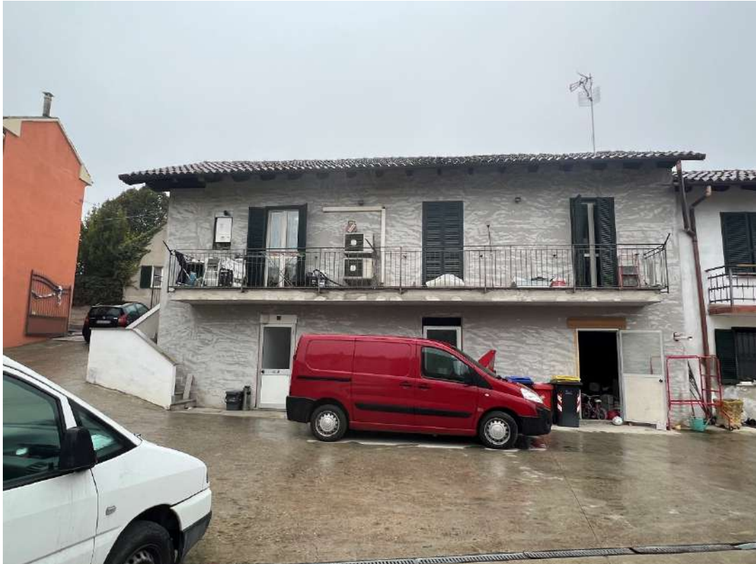
Figura 3 Abitazione nm 946 prospetto sud
