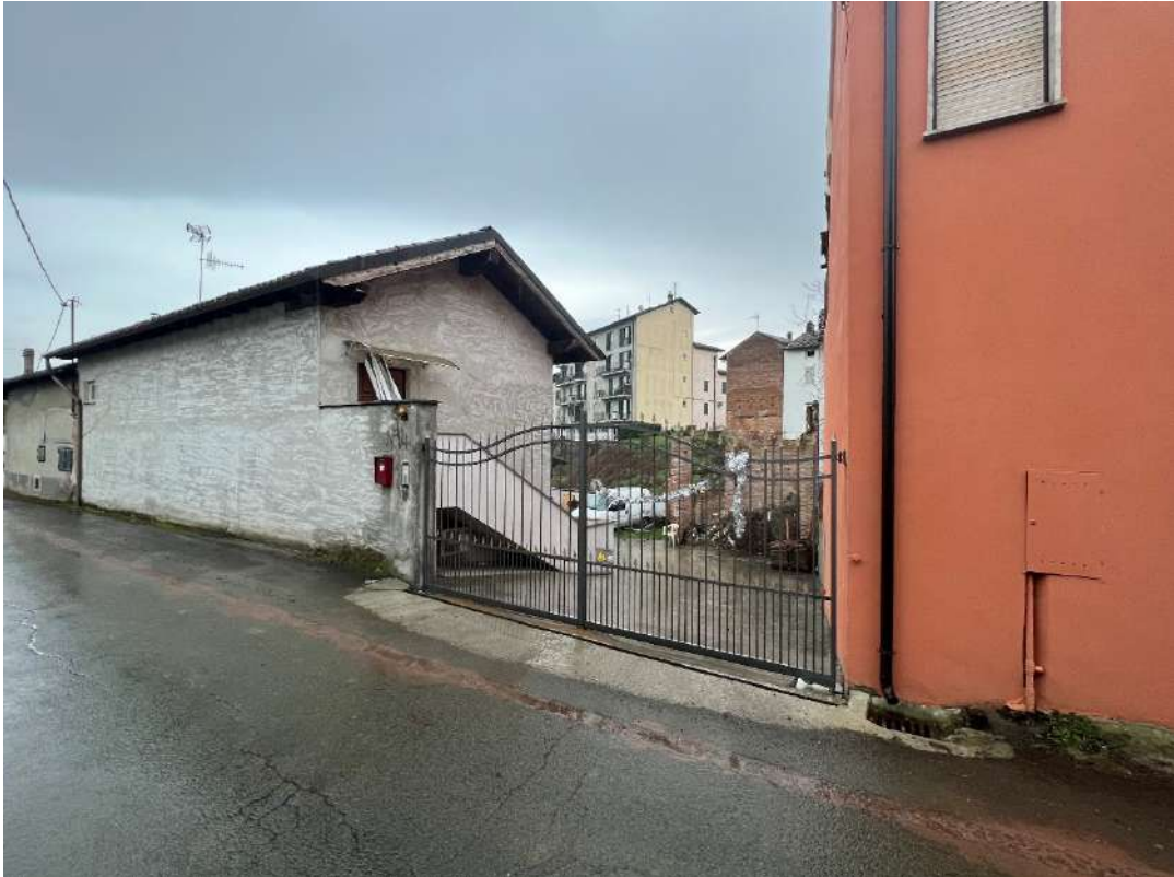
Figura 1 ingresso proprietà da Via Carducci
