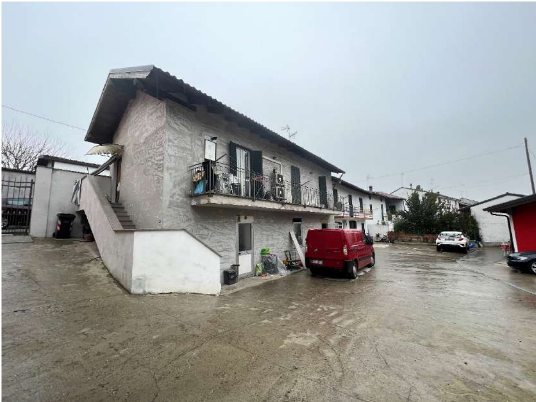
Figura 2 Abitazione nm 946 prospetto sud
