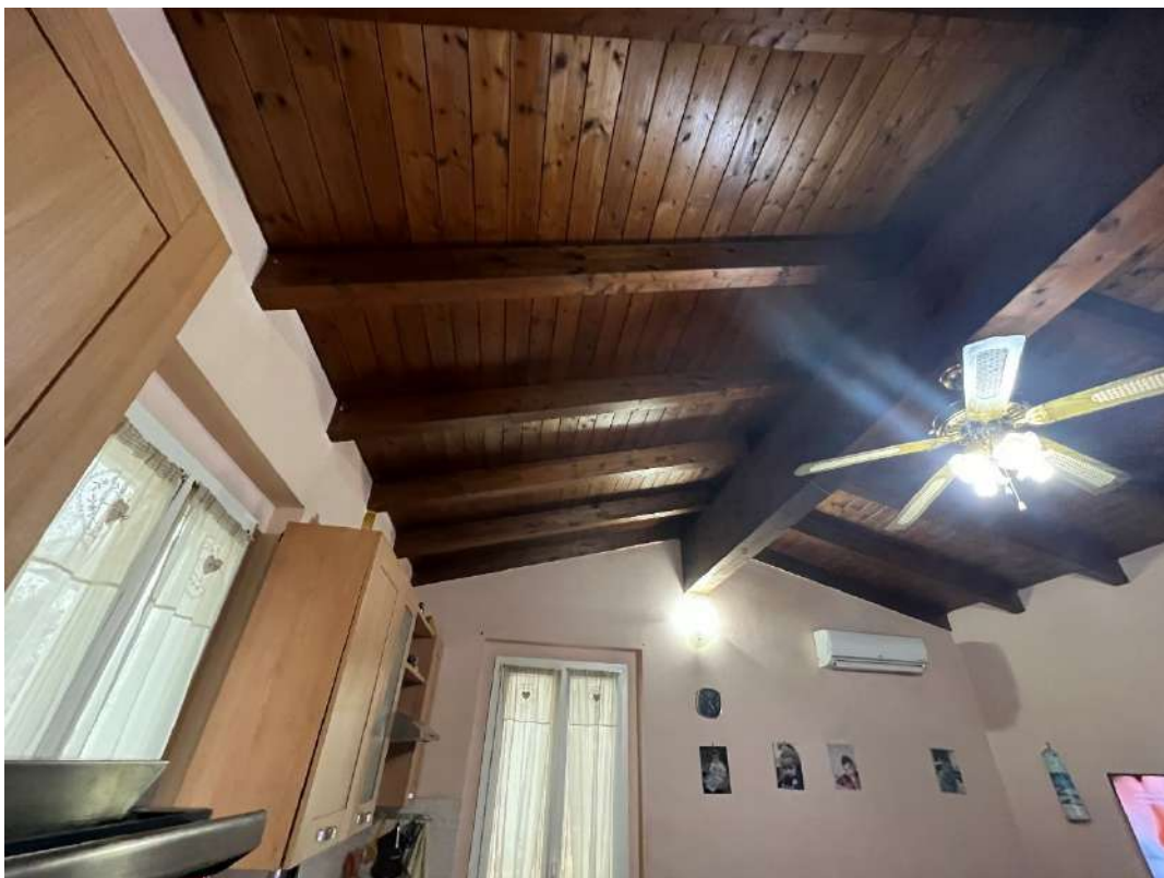
Figura 24 interno locale accessorio n., 153
