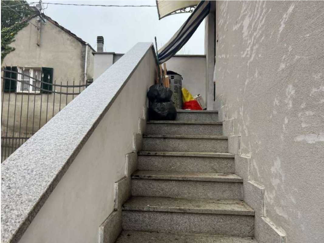
Figura 9 scala accesso abitazione P1 nm. 946
