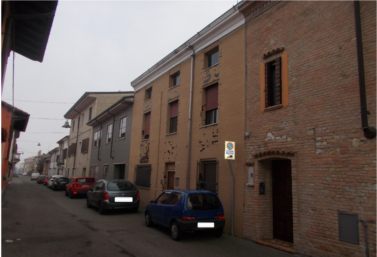
1. Fabbricato ad uso civile abitazione - particolare accesso da Via Cavour civico nr. 4, oggetto della presente Esecuzione Immobiliare
