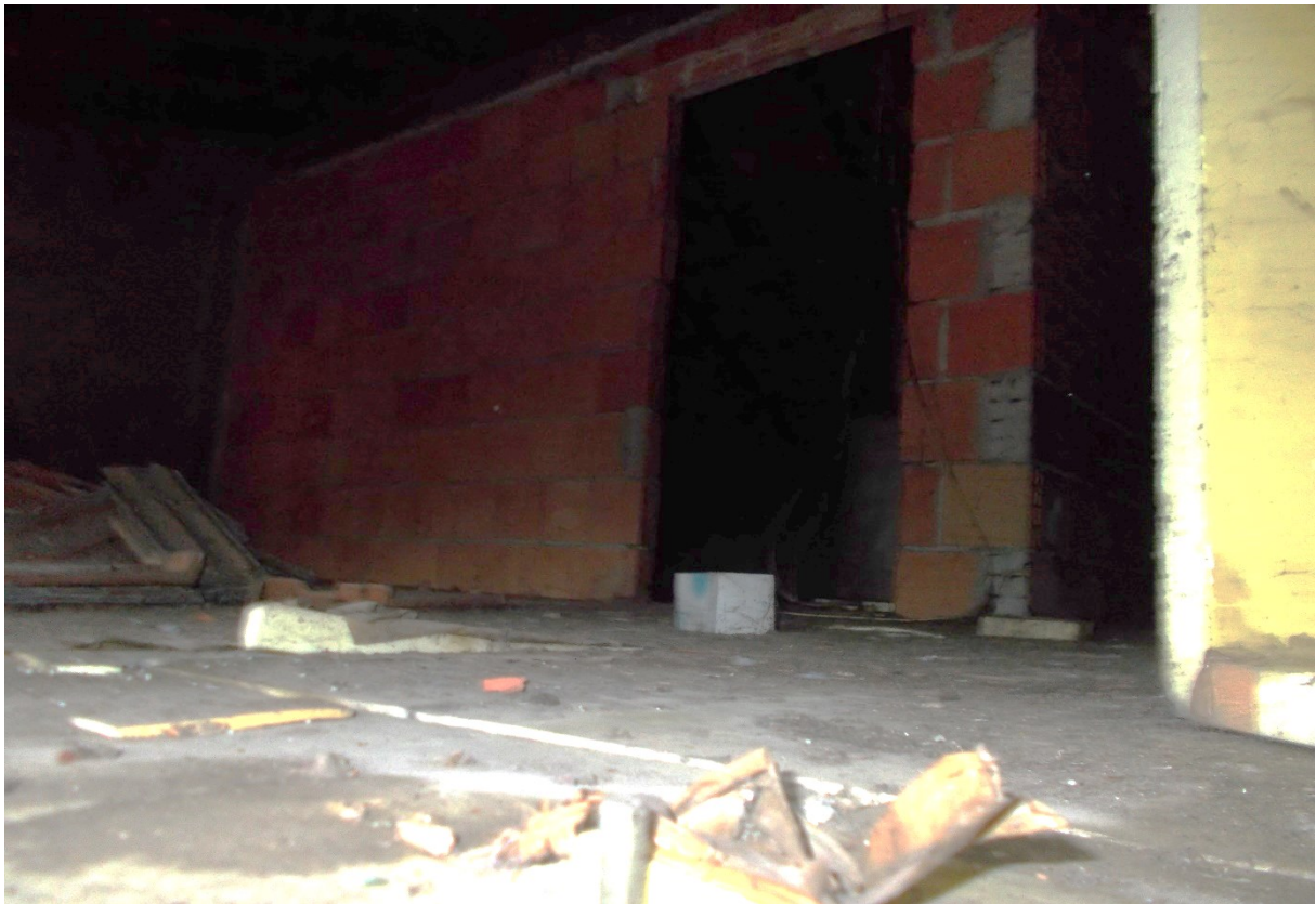
8. Particolare interno - locali sottotetto
