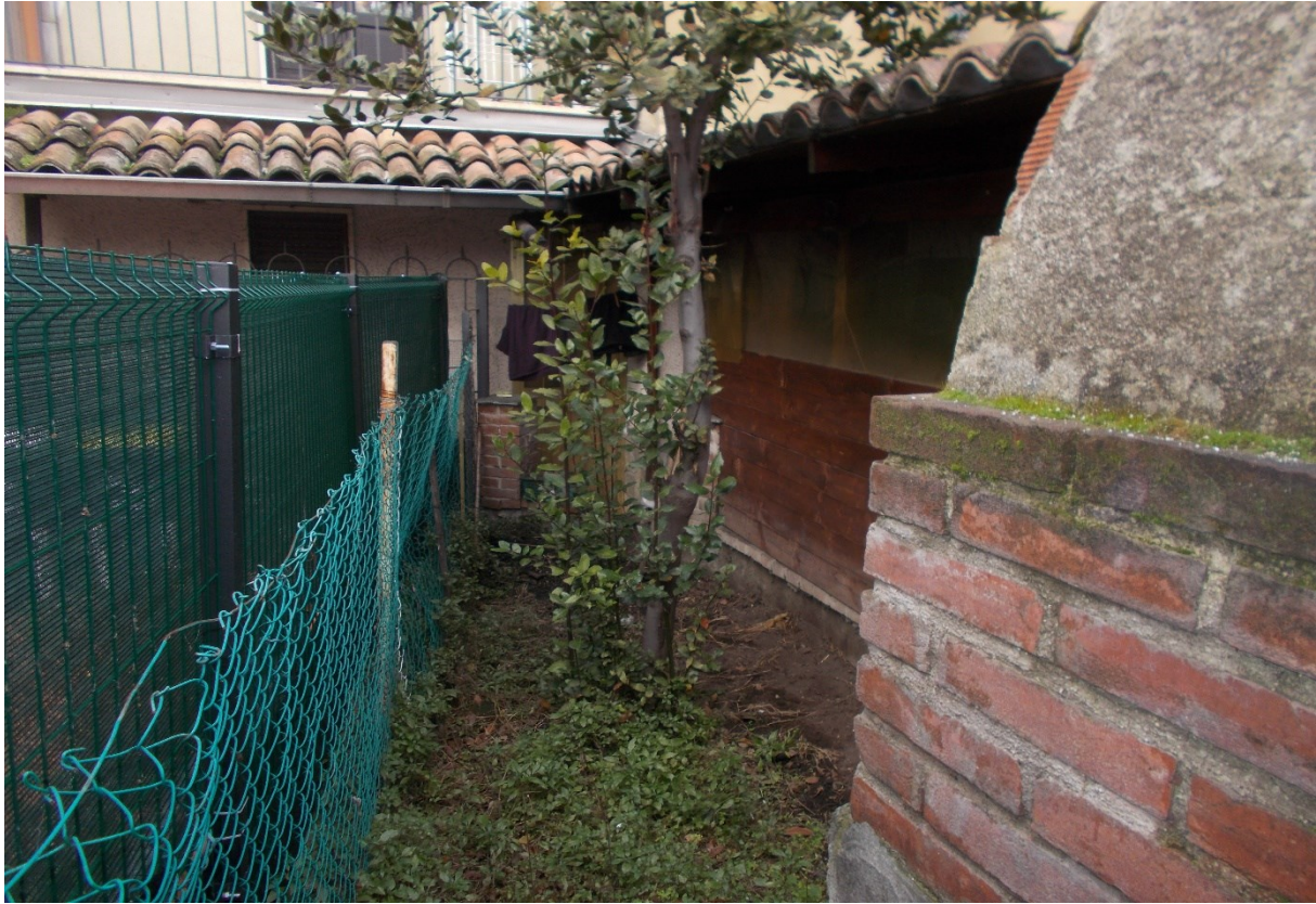
3. Particolare esiguo sedime cortilizio di pertinenza
