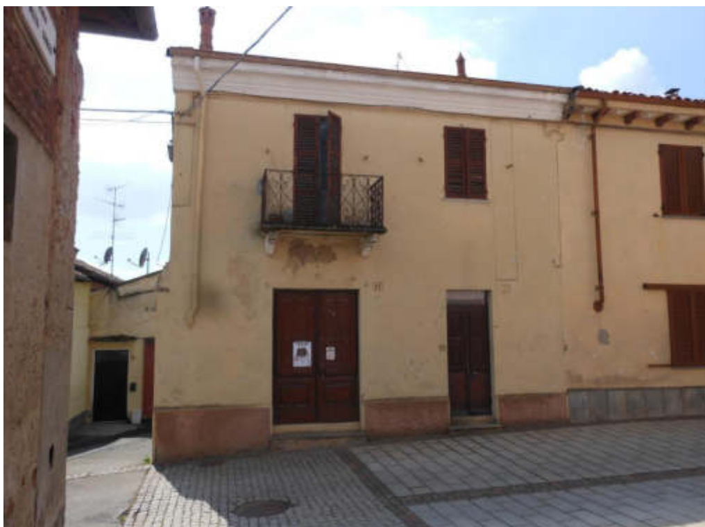
Foto 35 Prospetto su Via Italia Lotto 2
