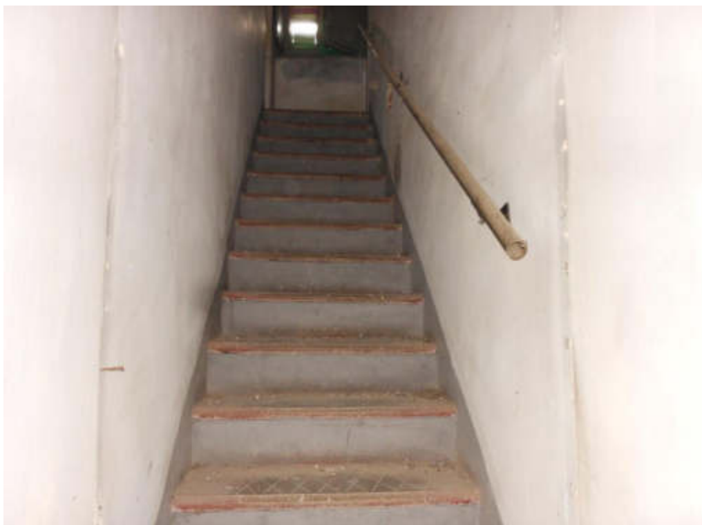
Foto 42 Scala accesso piano primo Lotto 2
