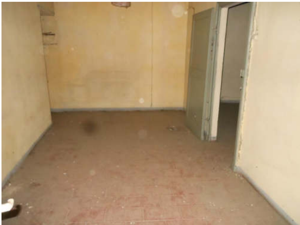
Foto 44 Camera piano primo Lotto 2
