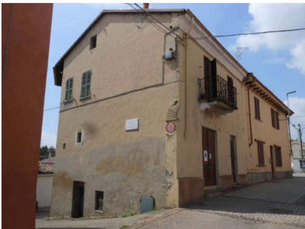
Foto 36 Prospetto Sud Lotto 2
