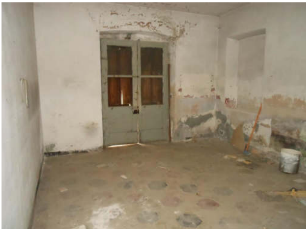
Foto 40 Camera piano terra Lotto 2
