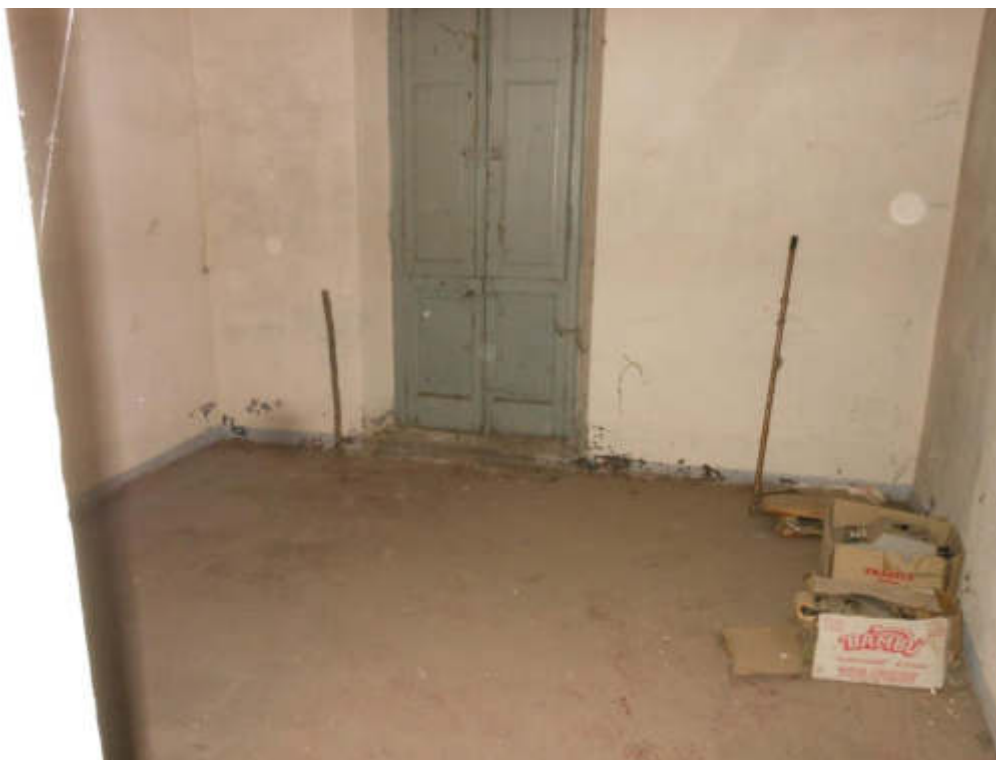
Foto 45 Camera piano primo Lotto 2
