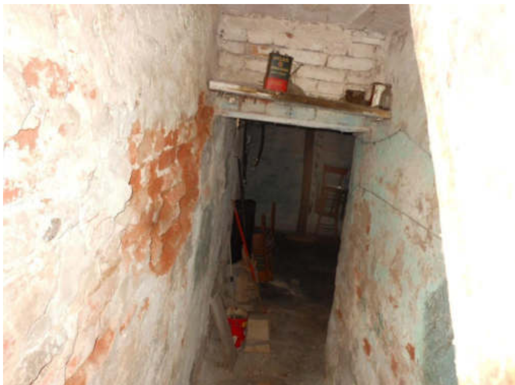
Foto 47 Scala accesso piano seminterrato Lotto 2
