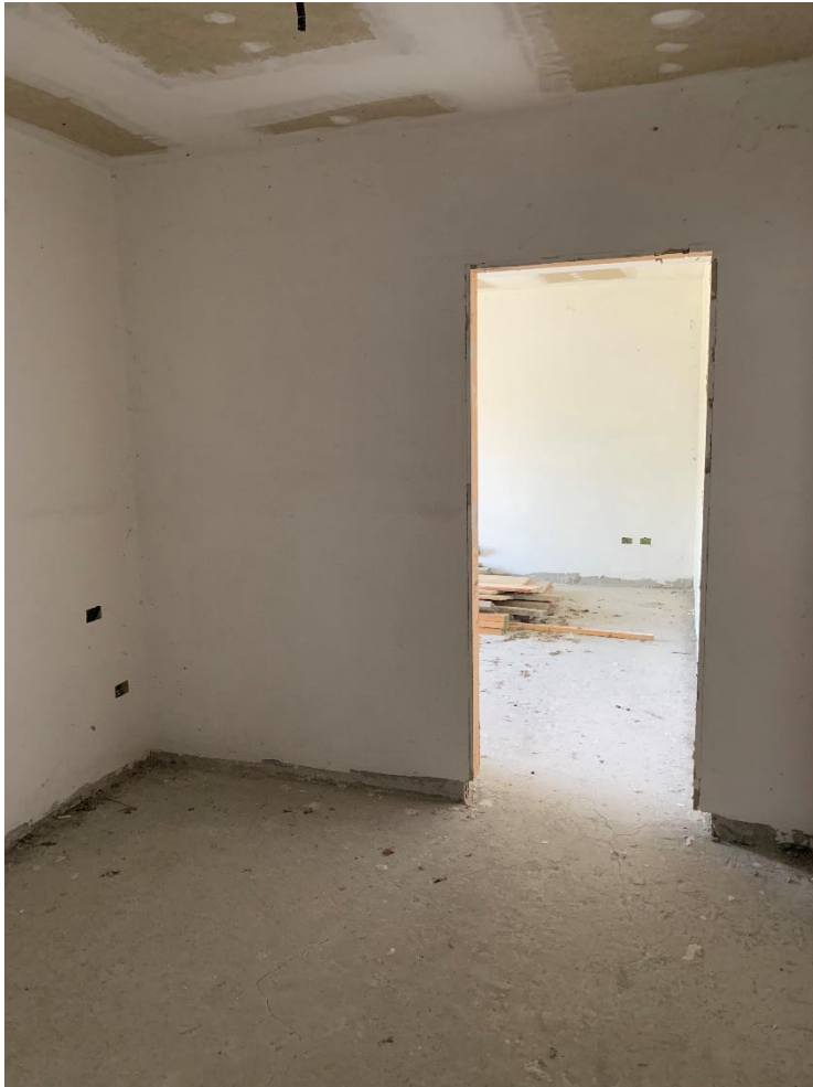
13 zona di collegamento con soggiorno/cucina
