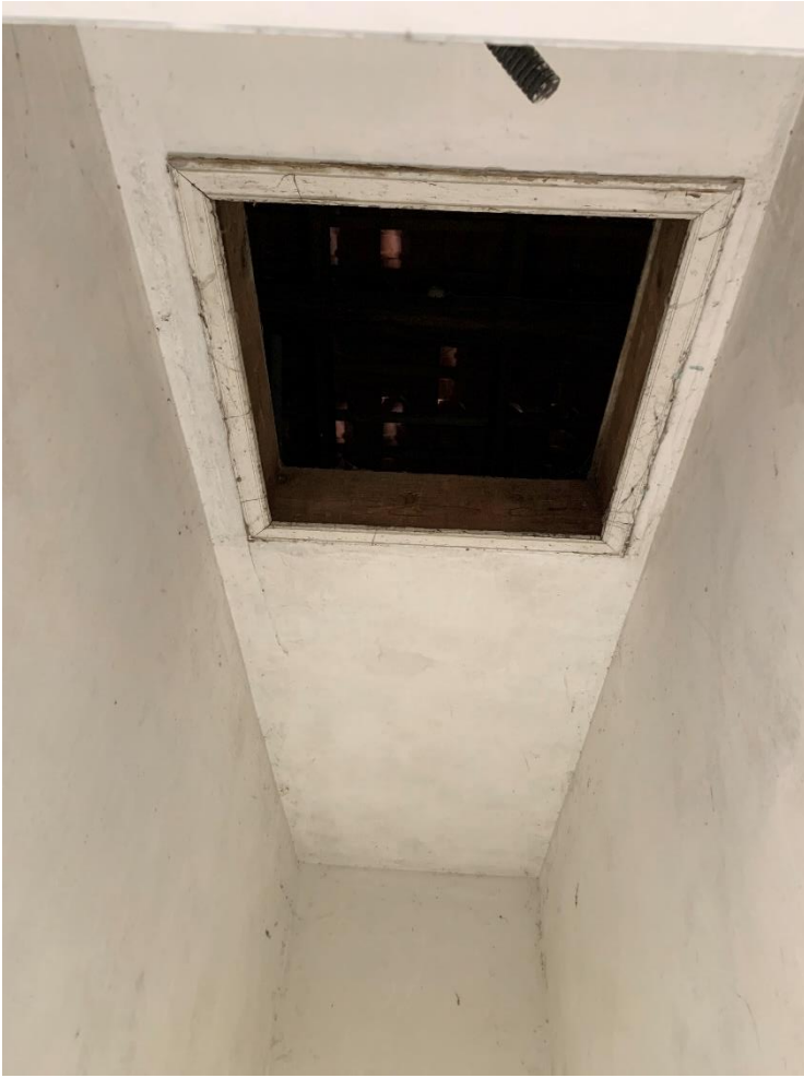
32 botola per sottotetto sopra scala d'ingresso
