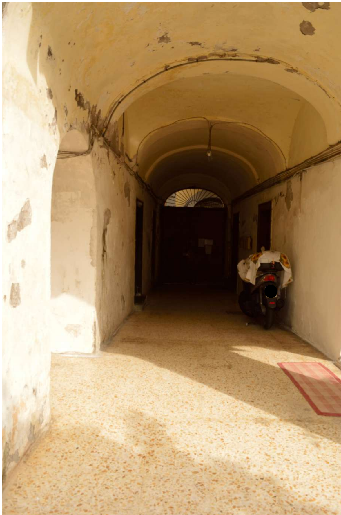
Figure 3- androne di accesso al fabbricato
