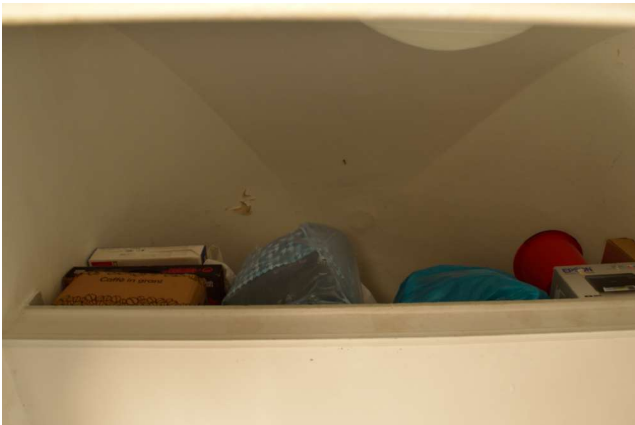
Figure 28- vista soppalco non abitabile
