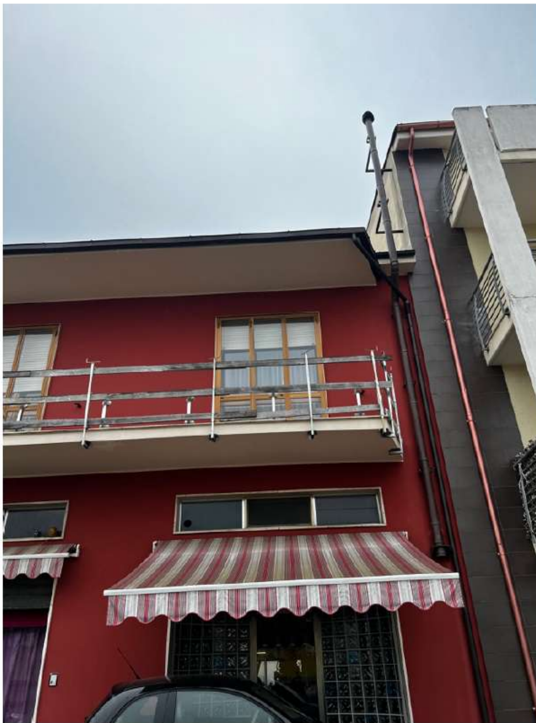
Foto n° 30 vedute esterne fabbricato
