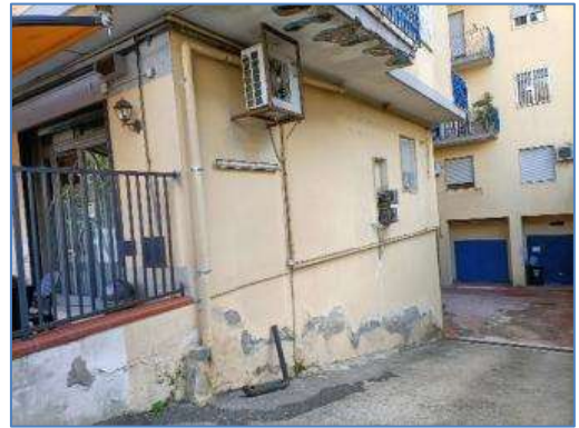
Fotografia 2 – Prospetto Ovest (rampa carrabile)
