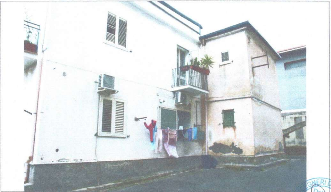
Foto n. 4 – Prospetto lato est
