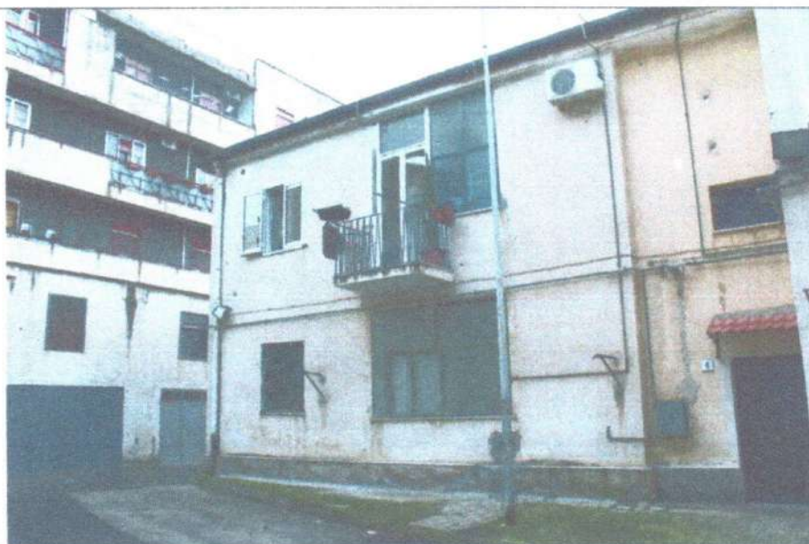
Foto n. 3 – Ingresso al condominio
