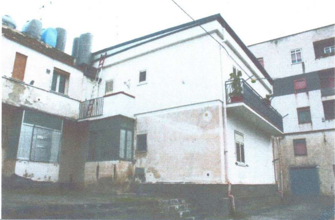
Foto n. 6 - Prospetto lato sud-ovest
