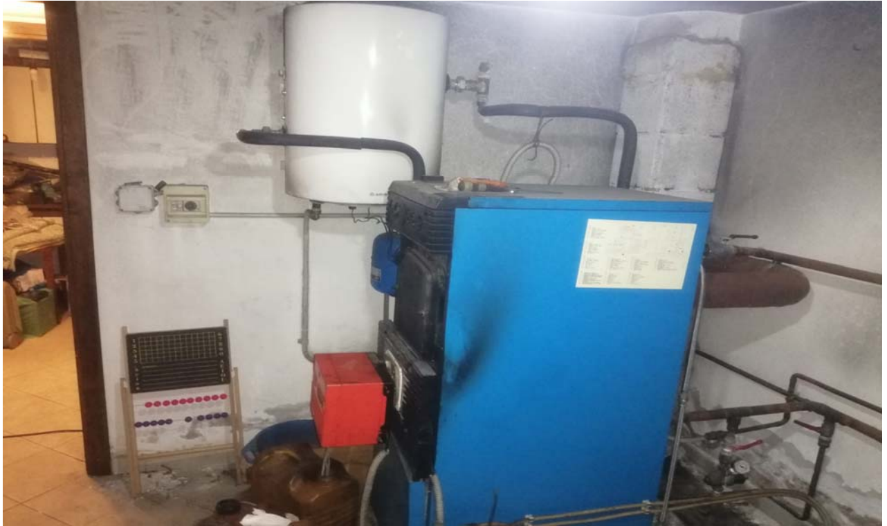
Foto 15: Vista vano caldaia.
