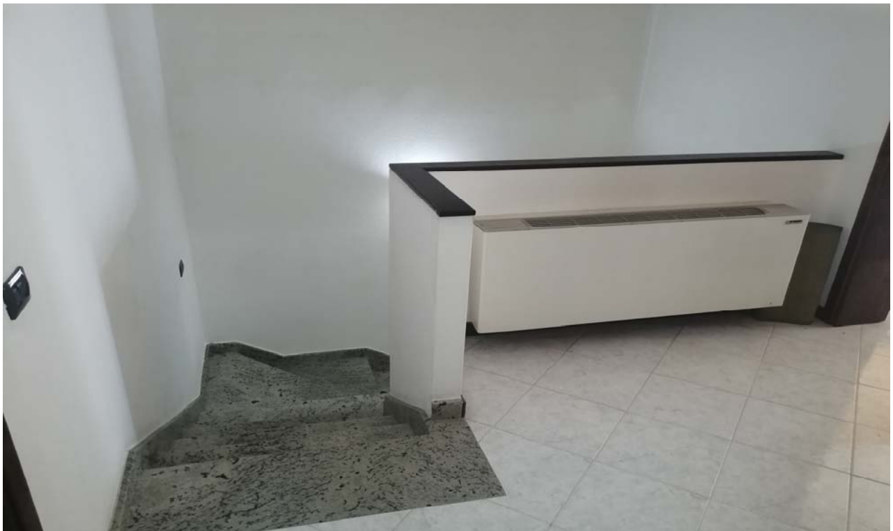
Foto 18: Vista rampa scale (piano primo).
