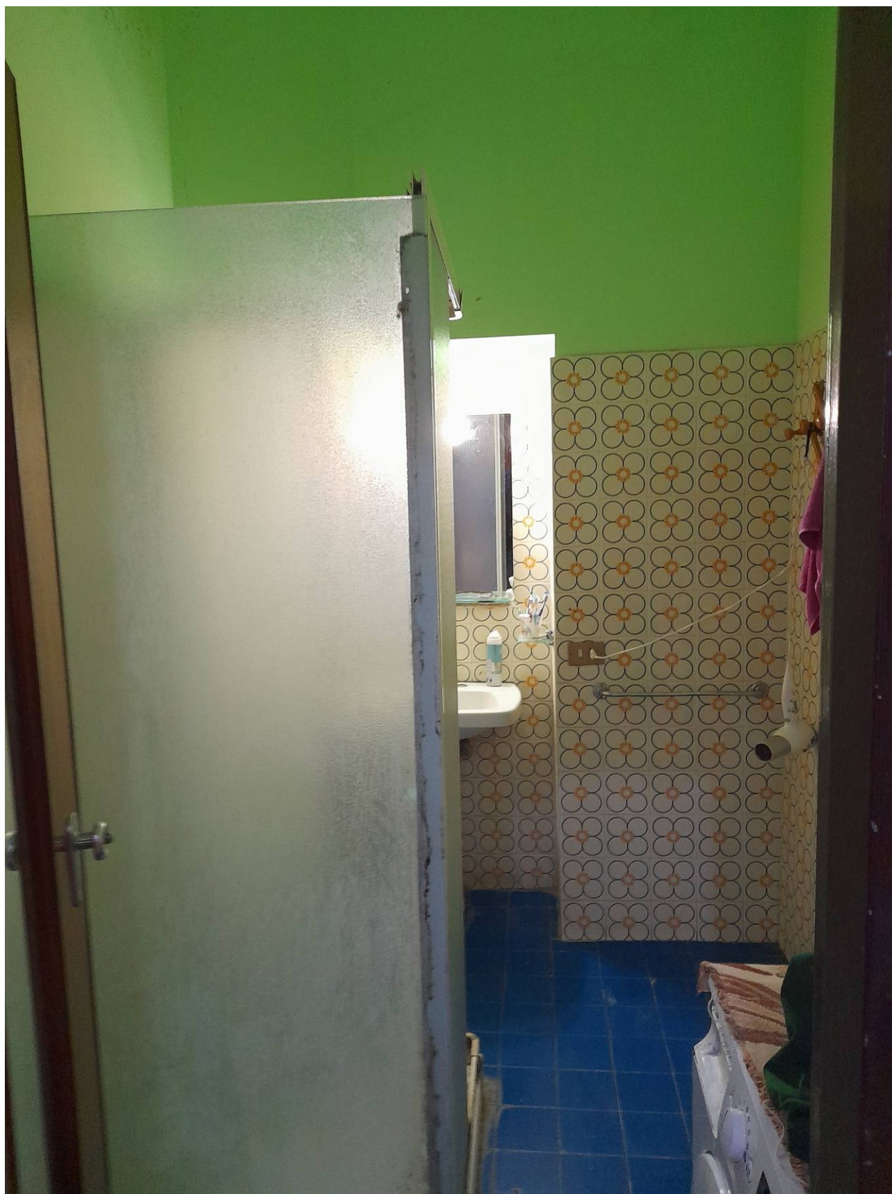
Foto 14 – vano n. 5 bagno
