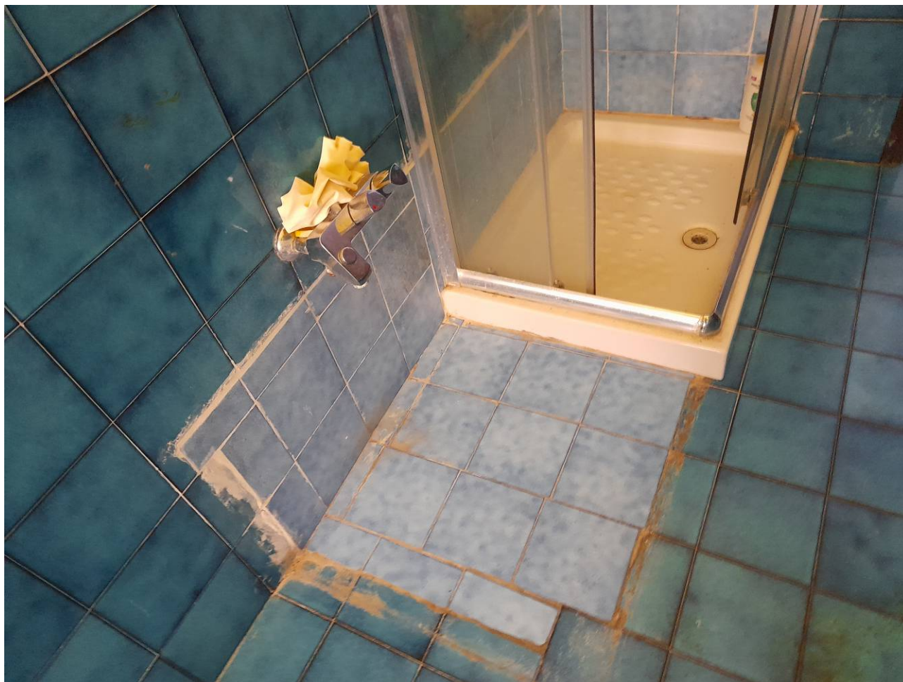
Foto 12 – vano n. 3 bagno principale – sostituzione vasca con doccia
