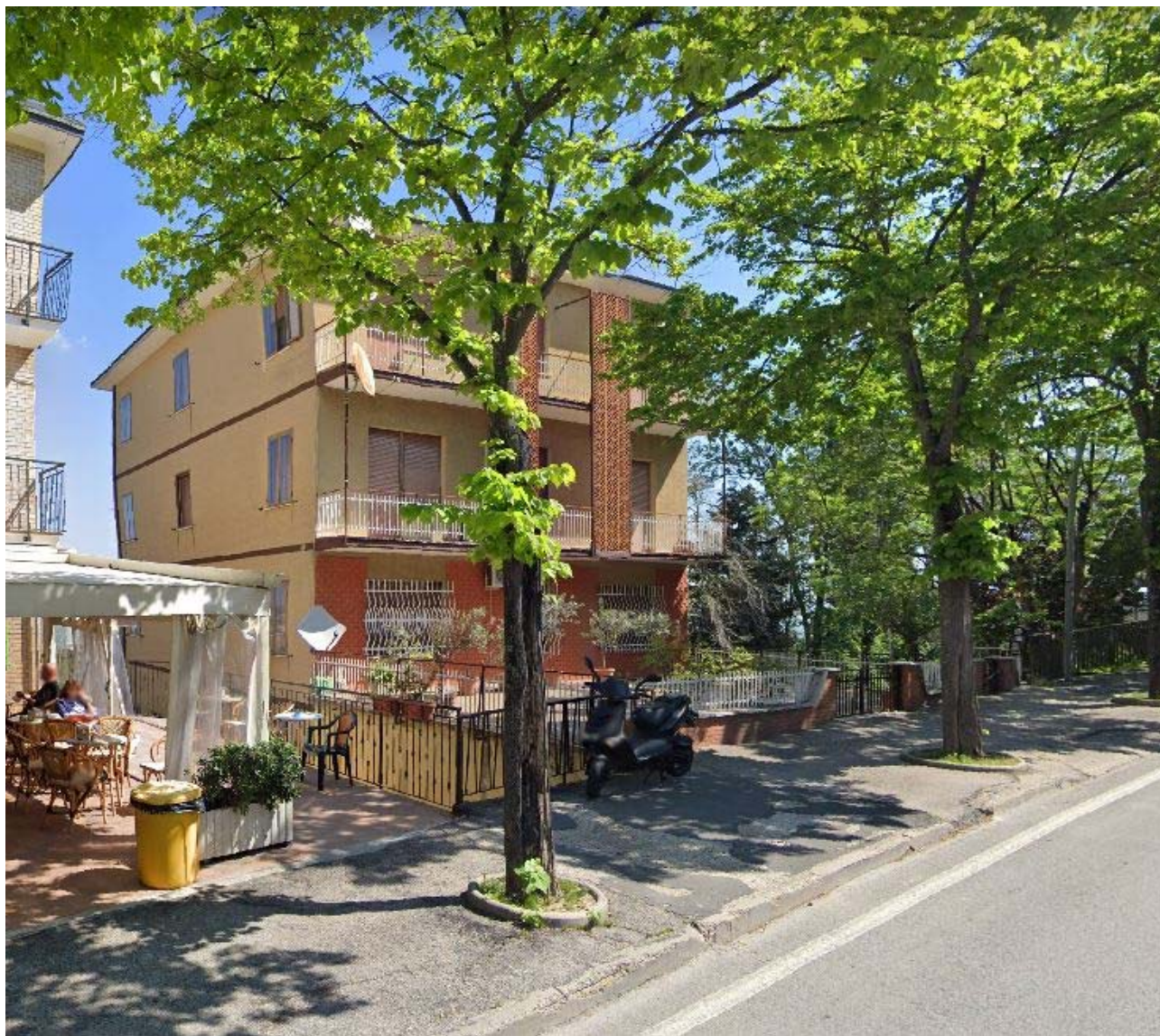
Foto 2 – condominio visto da Viale Trento
