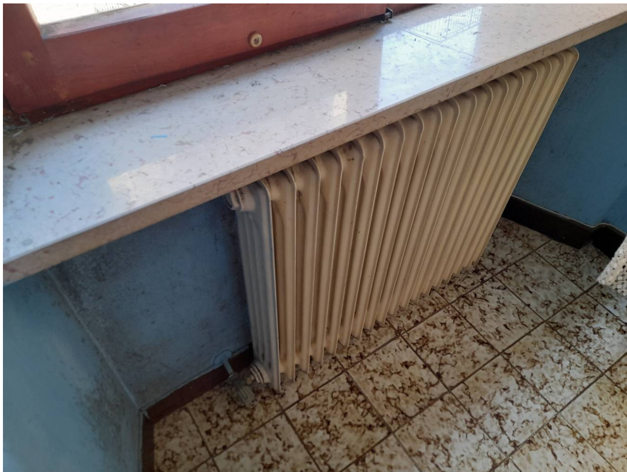
Foto 10 – particolare radiatori camera 2
