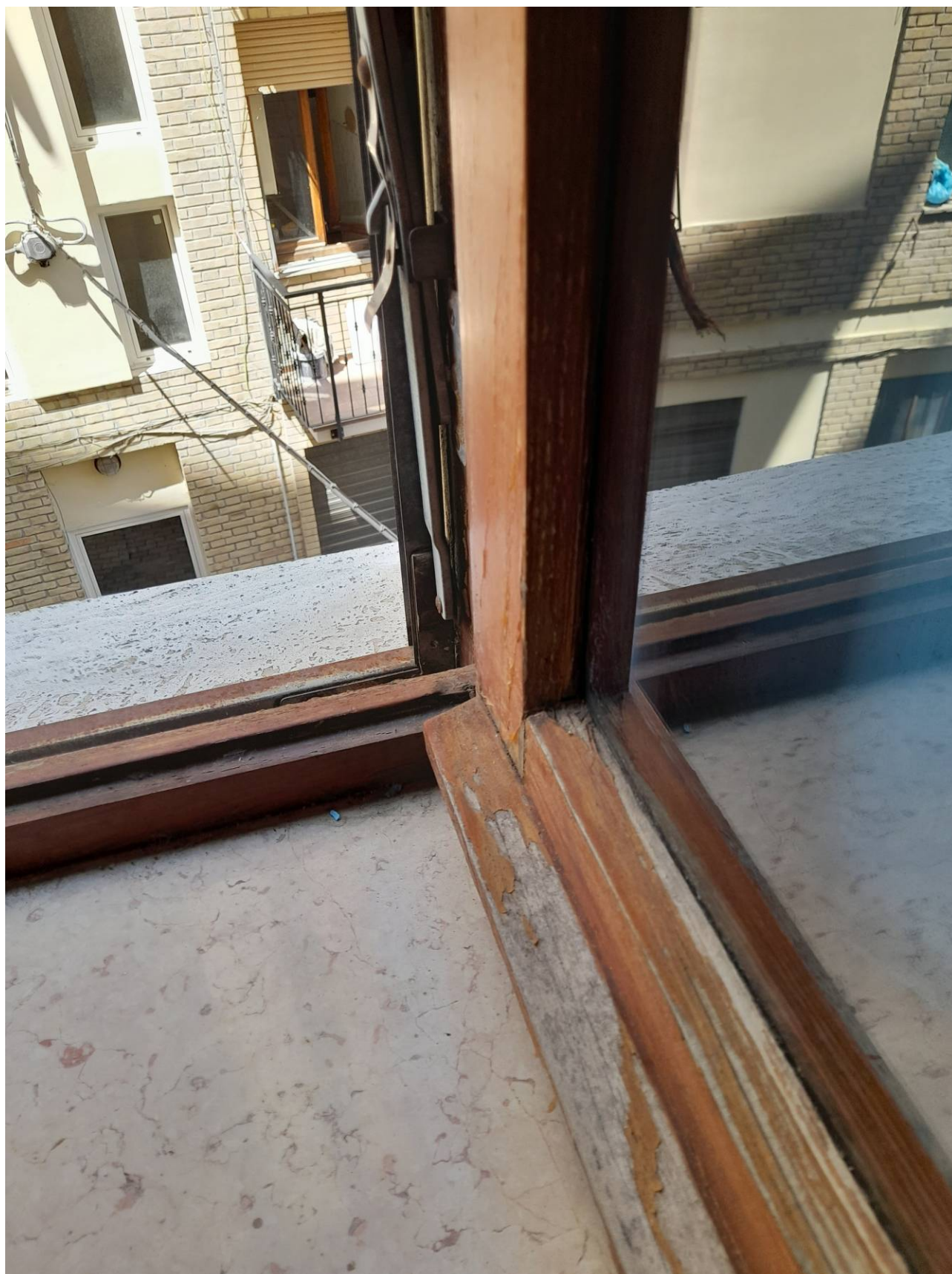
Foto 9 – particolare infisso camera 2
