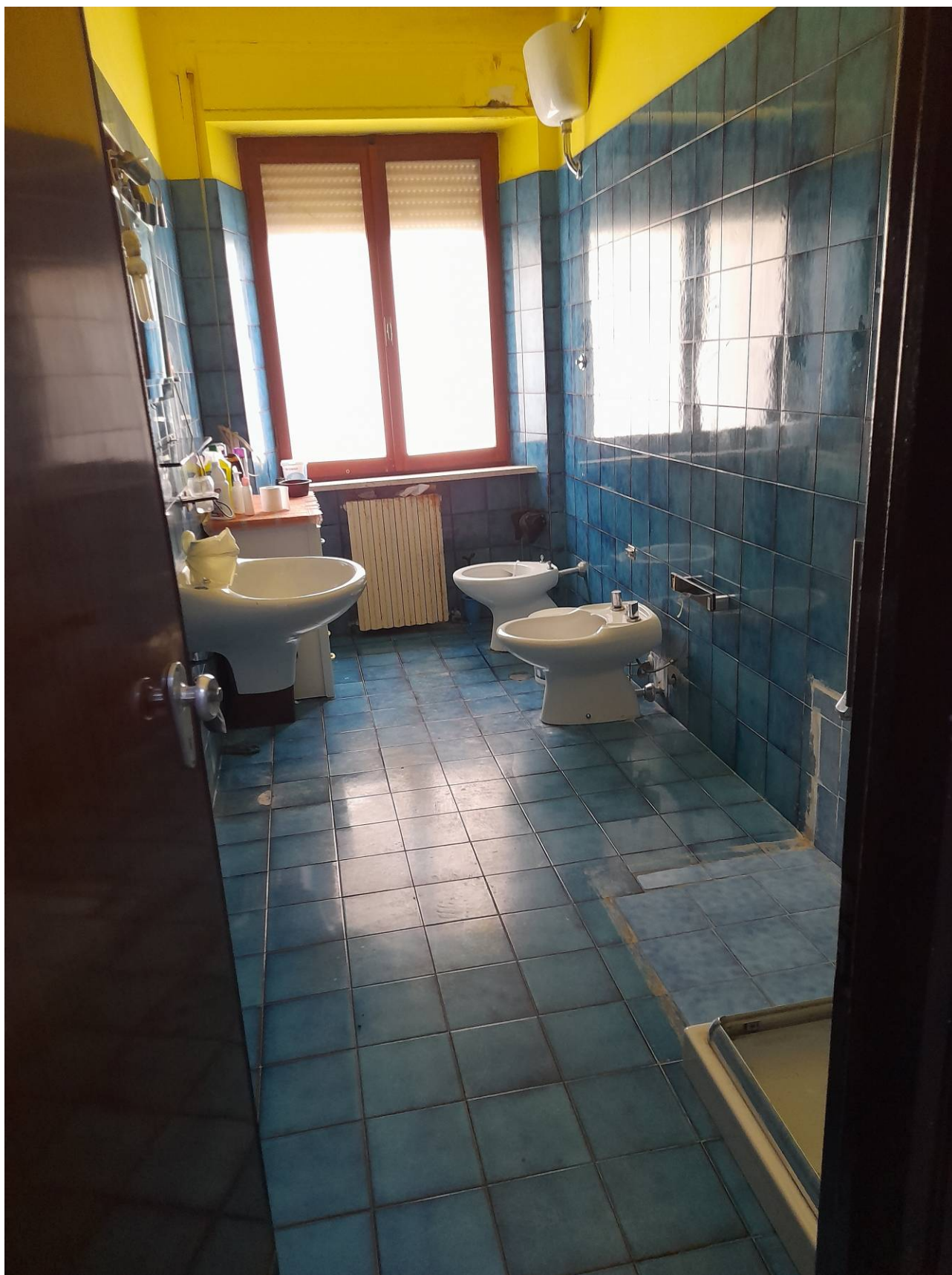
Foto 11 – vano n. 3 bagno principale
