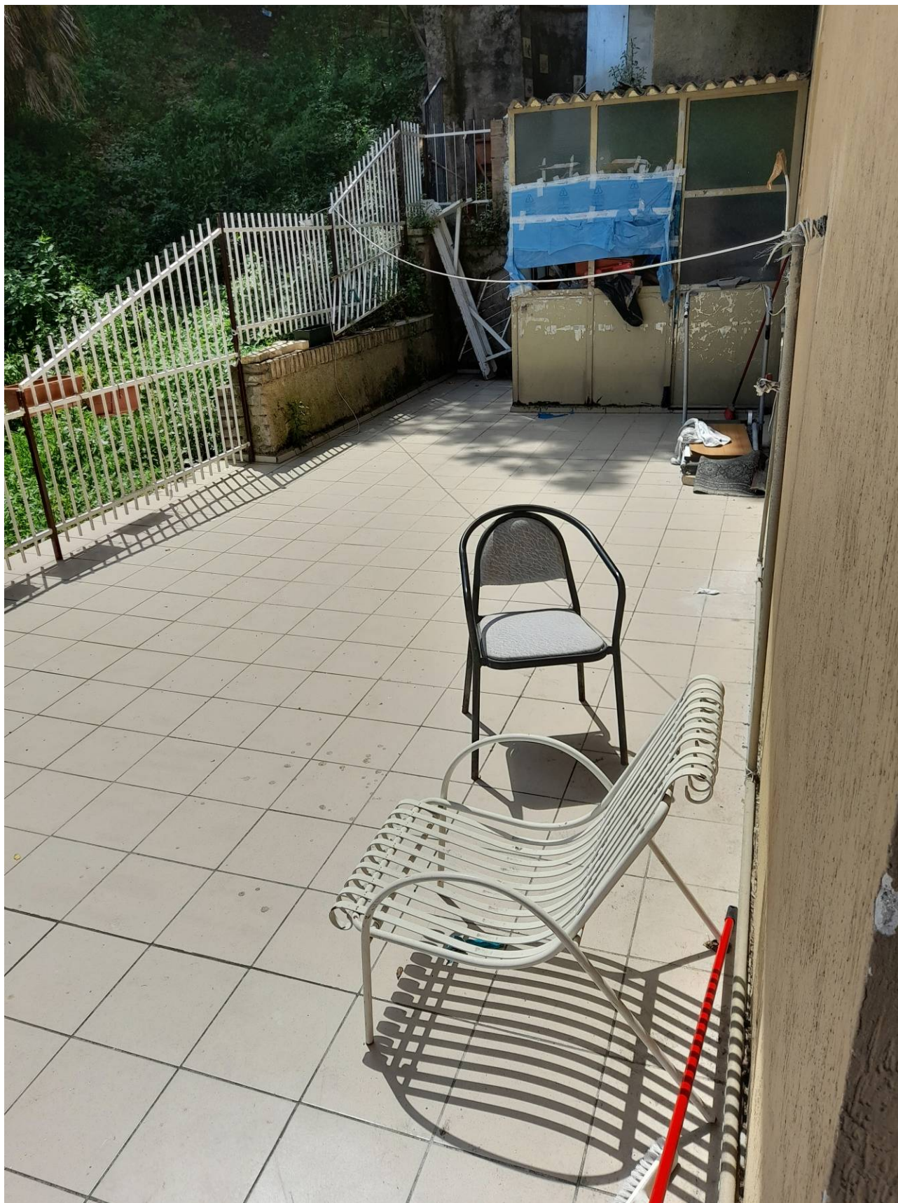
Foto 17 – terrazzo superiore – si noti sul fondo il manufatto abusivo in lamiera a vetro
