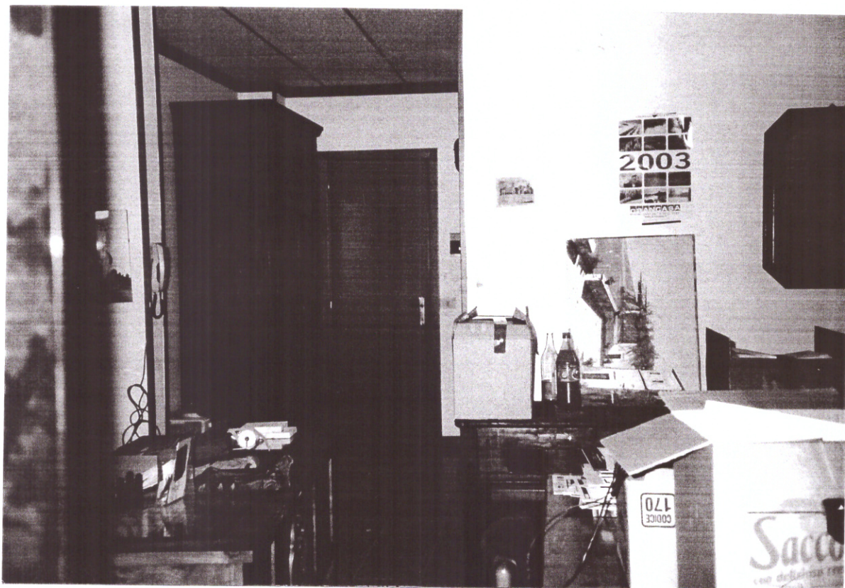
Foto n° 3 Interno fabbricato – ufficio
