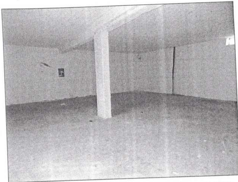
Foto 7 – Vista dello stato interno del locale magazzino.
