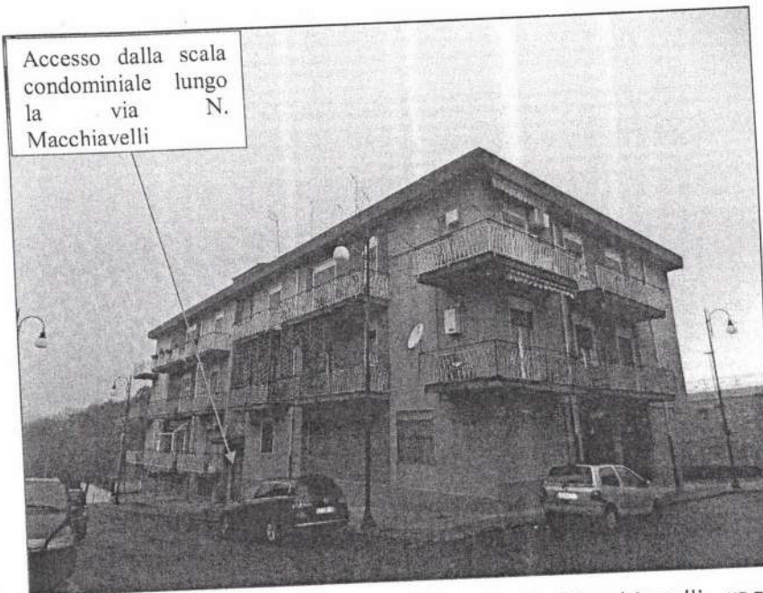
Foto 5 - Vista del corpo di fabbrica dalla via N. Macchiavelli, raggiungibile l'immobile oggetto di stima al piano seminterrato, mediante la scala condominiale.
