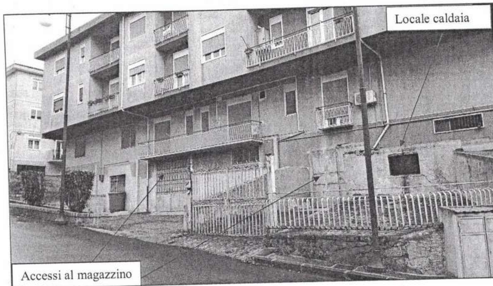
Foto 3 - Vista del corpo di fabbrica dalla via Napoli lungo il piano seminterrato, con gli accessi al piano magazzino e l'ubicazione del locale caldaia
