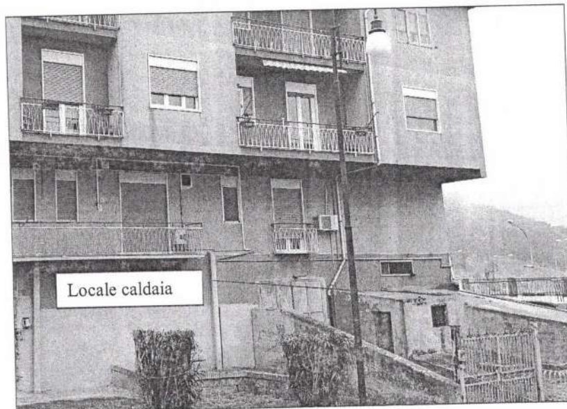
Foto 4 - Vista del locale caldaia.
