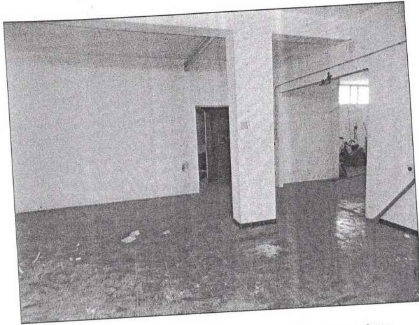
Foto 9 – Immagine interna del locale magazzino.
