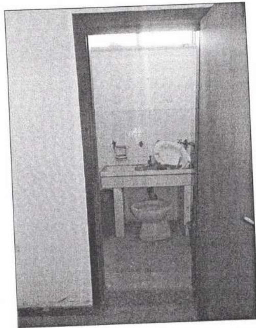
Foto 11 – Vista interna del bagno nel locale magazzino.
