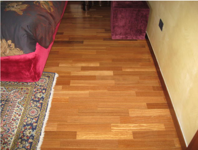
particolare pavimento camera
