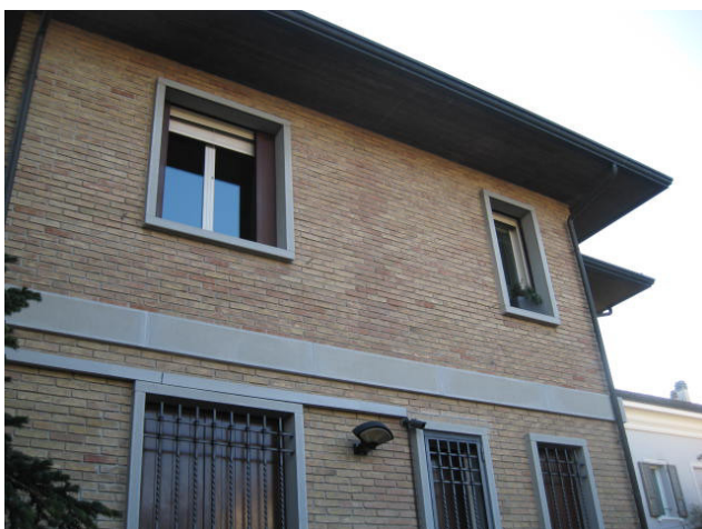
Particolare prospetto e balcone fianco nord
