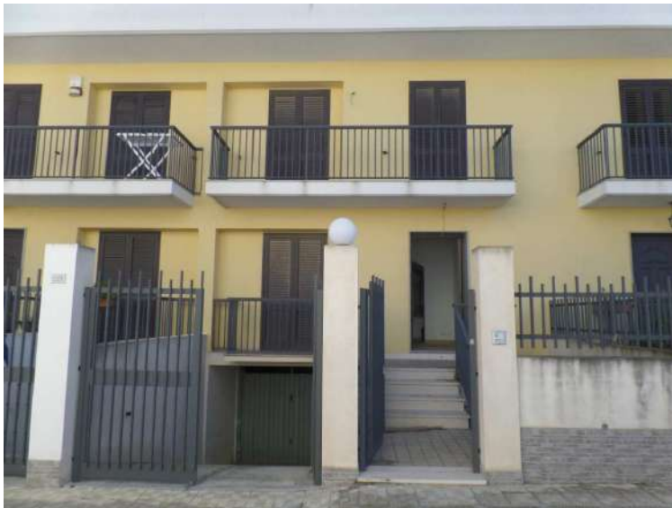
Foto n° 1.3. Prospetto su Via Concetto Olindo
