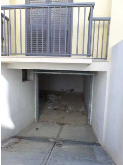
Foto n° 1.1. Garage: rampa d'accesso
