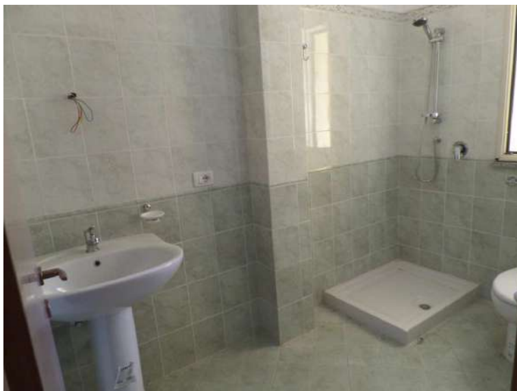
Foto n° 2.8. Piano Terra: Bagno
