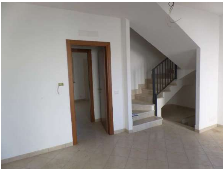
Foto n° 1.5. Piano Terra: Soggiorno
