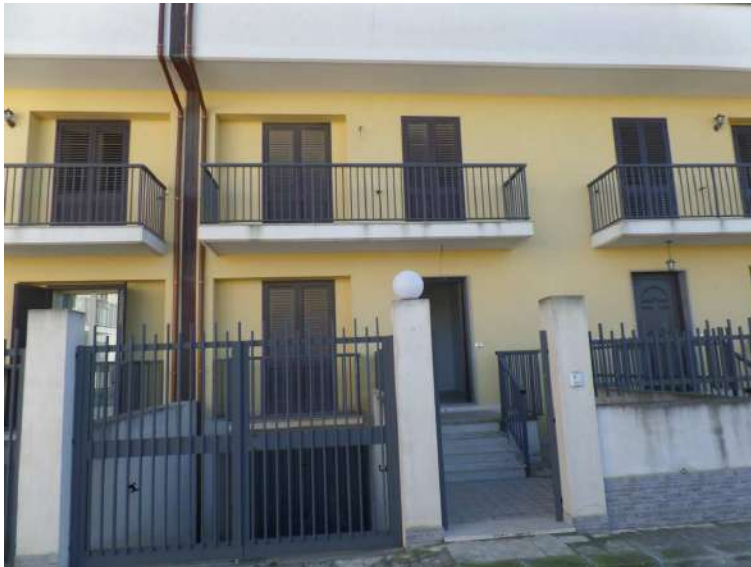
Foto n° 2.3. Prospetto su Via Concetto Olindo
