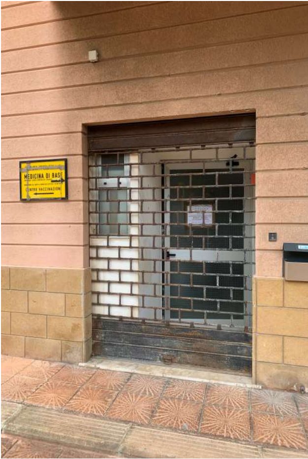
Foto 25 Ingresso sul prospetto esposto a nord-est
