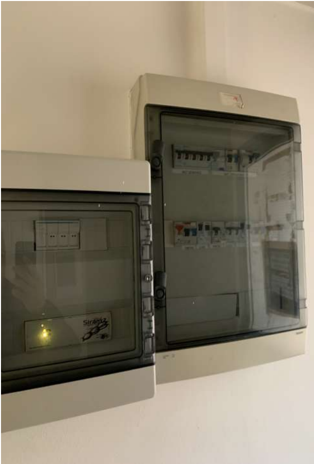
Foto 27 - 28 Il quadro elettrico generale
