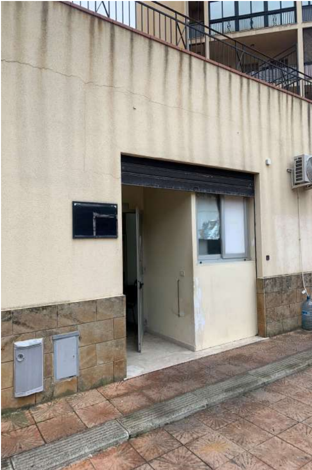
Foto 3 - Ingresso del fabbricato esposto a nord
