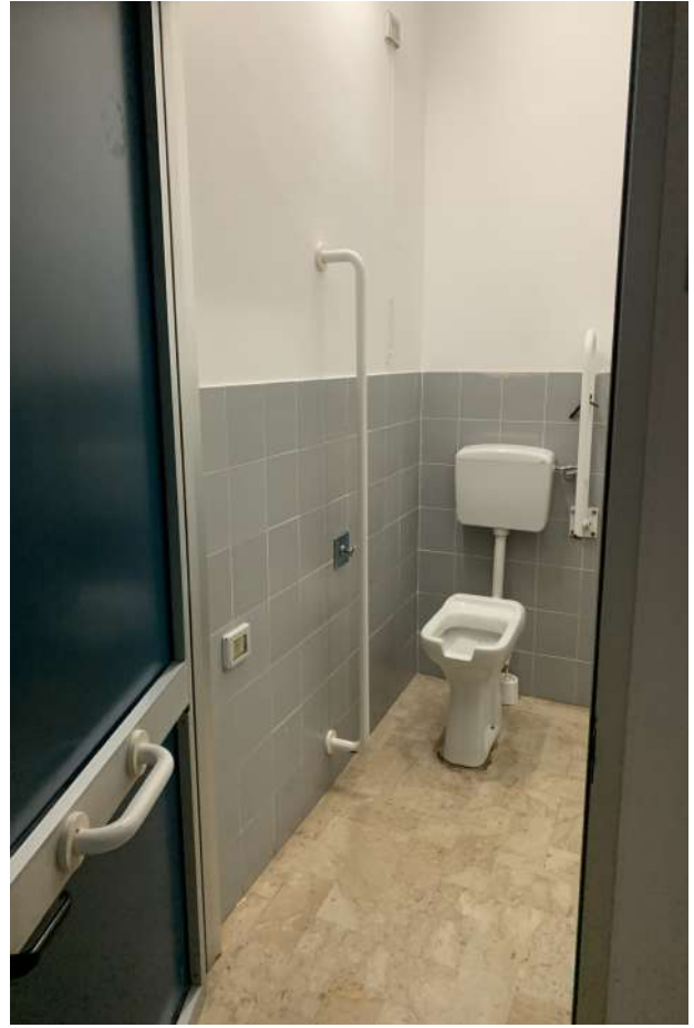
Foto 10 Il Bagno disabili
