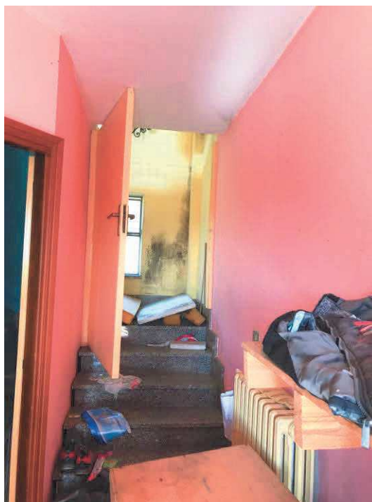
Scala accesso al primo piano (soppalco)
