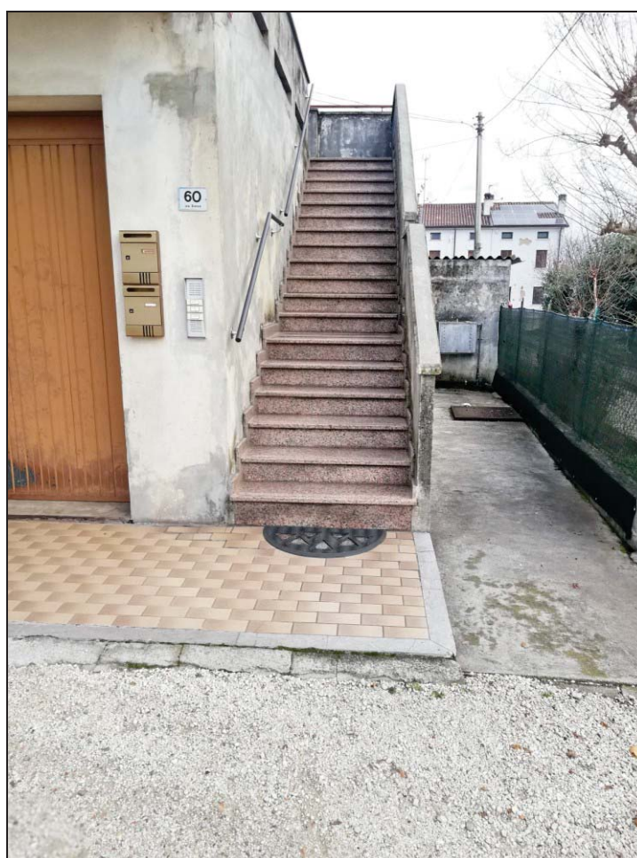
Foto 06 –Scala comune esterna di accesso al piano 1°
