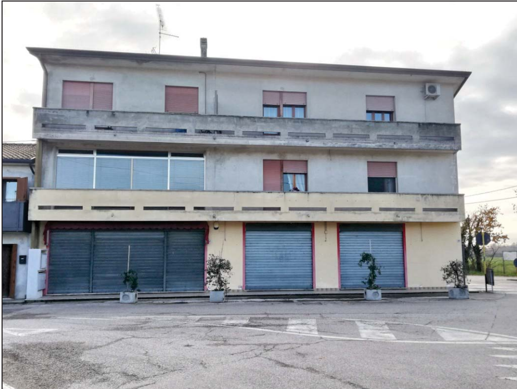
Foto 01 – Fronte nord da via Salvatoronda
