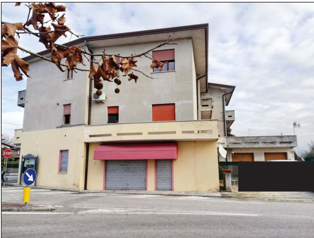
Foto 02 – Fronte ovest da via Zoncè
