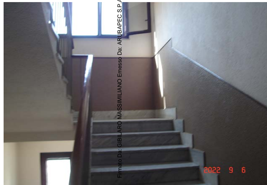
Scala di accesso
