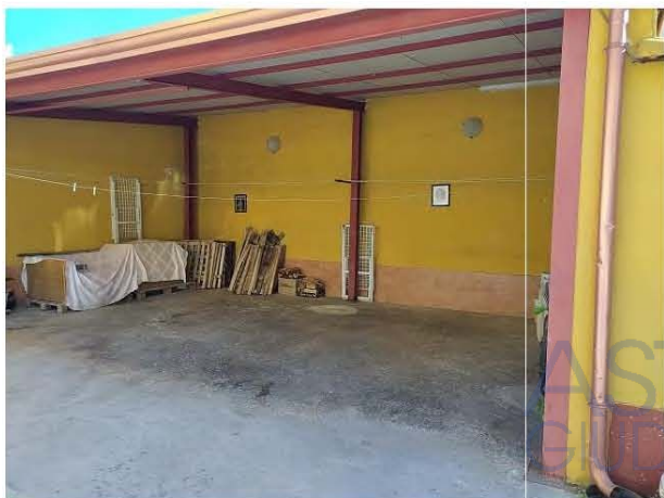
Tettoia insistente su parte del cortile
