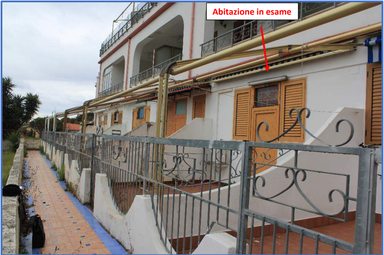
1.13 – Vista del percorso pedonale esterno che accede alle unità abitative del piano seminterrato
