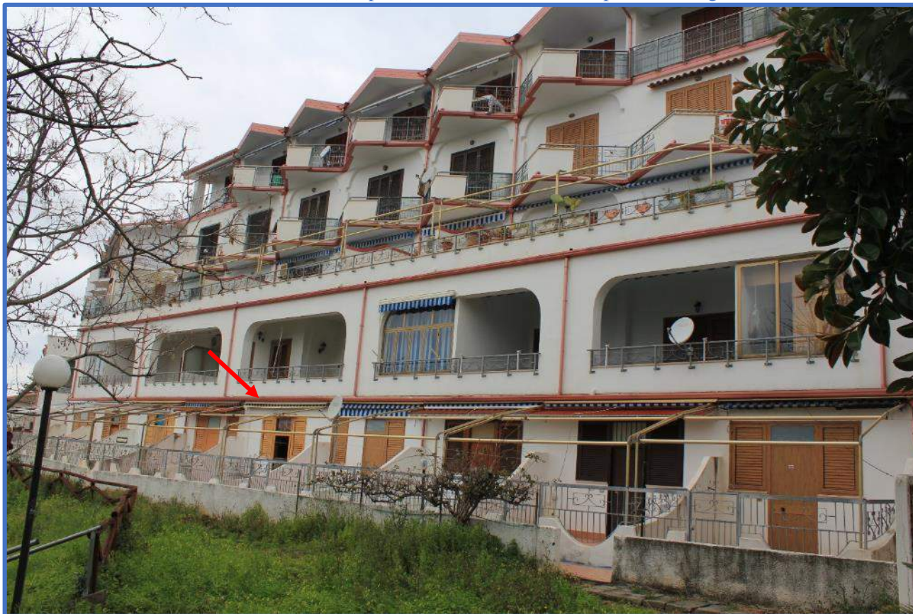
1.4 – Vista del fabbricato condominiale (Corpo A) con indicazione della posizione degli immobili – Fronte Sud
