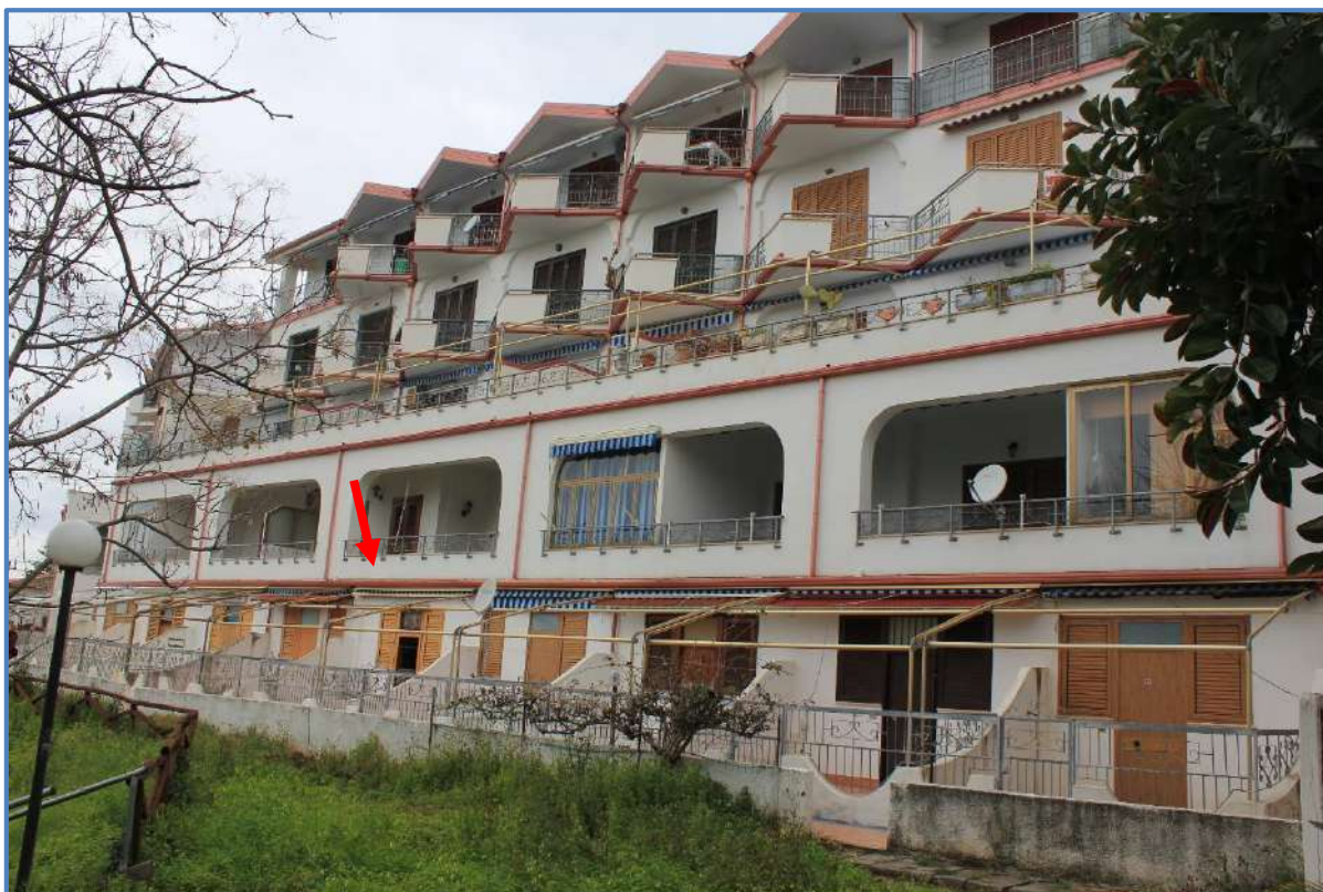
Fabbricato del quale fanno parte le unità immobiliari oggetto del presente procedimento – Vista angolo S/E.
