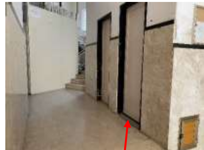
Ingresso all'immobile dall'androne
