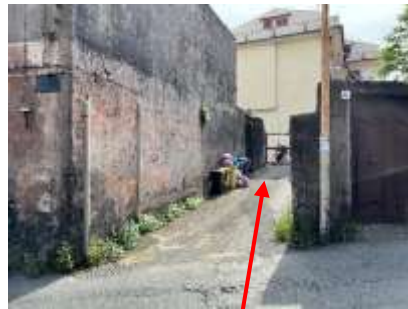
Ingresso alla strada privata dalla via Miracoli
