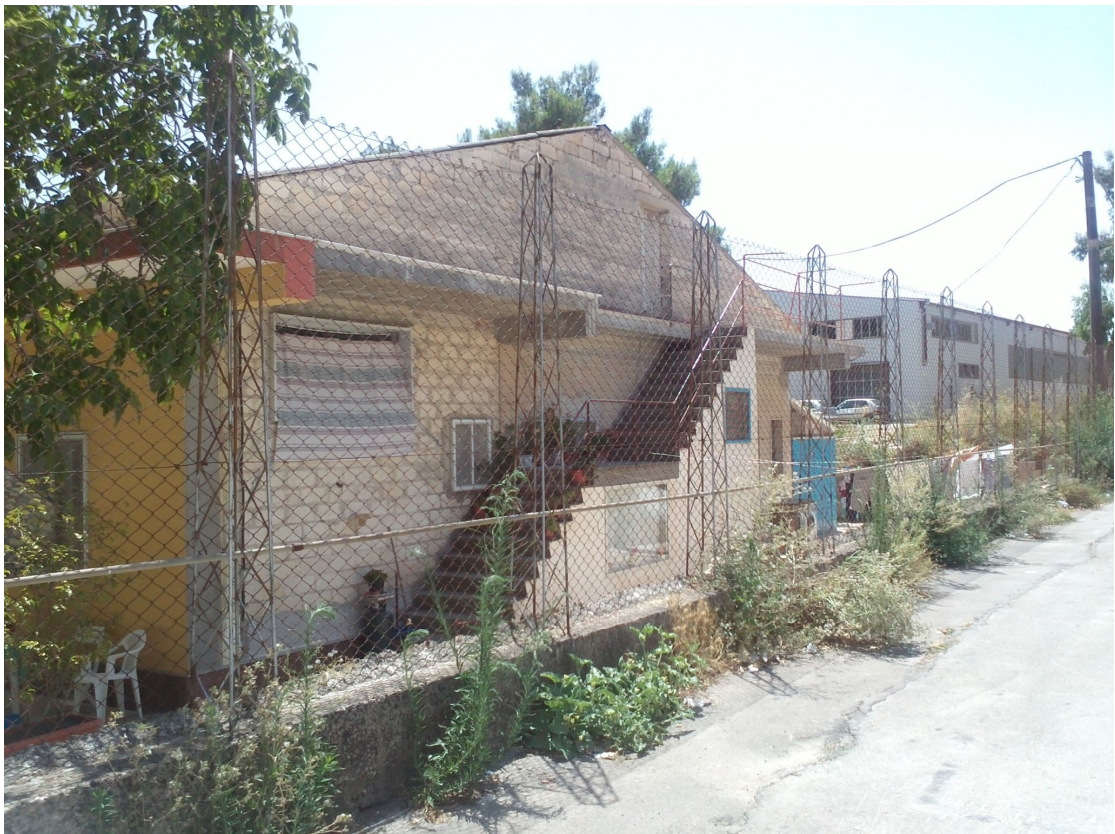
Foto 10. Muratura esterna senza intonaco al sub 8
