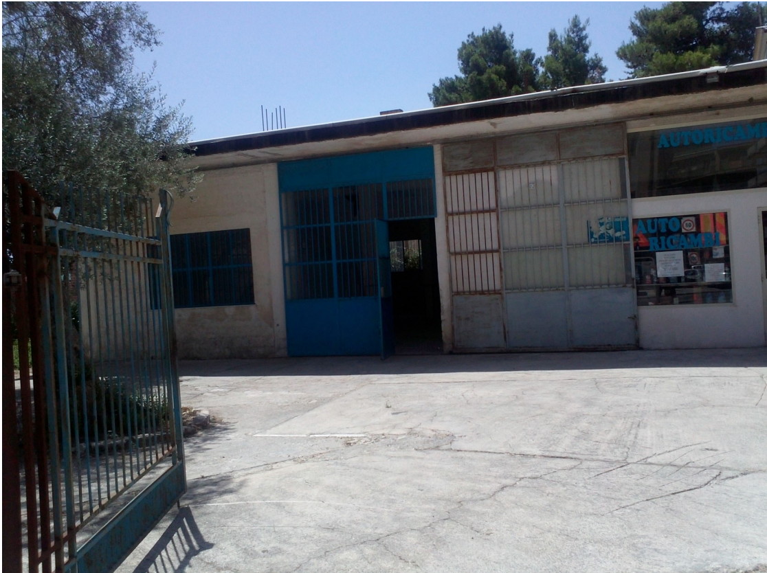
Foto 01. Piazzale d'ingresso ai beni pignorati.
