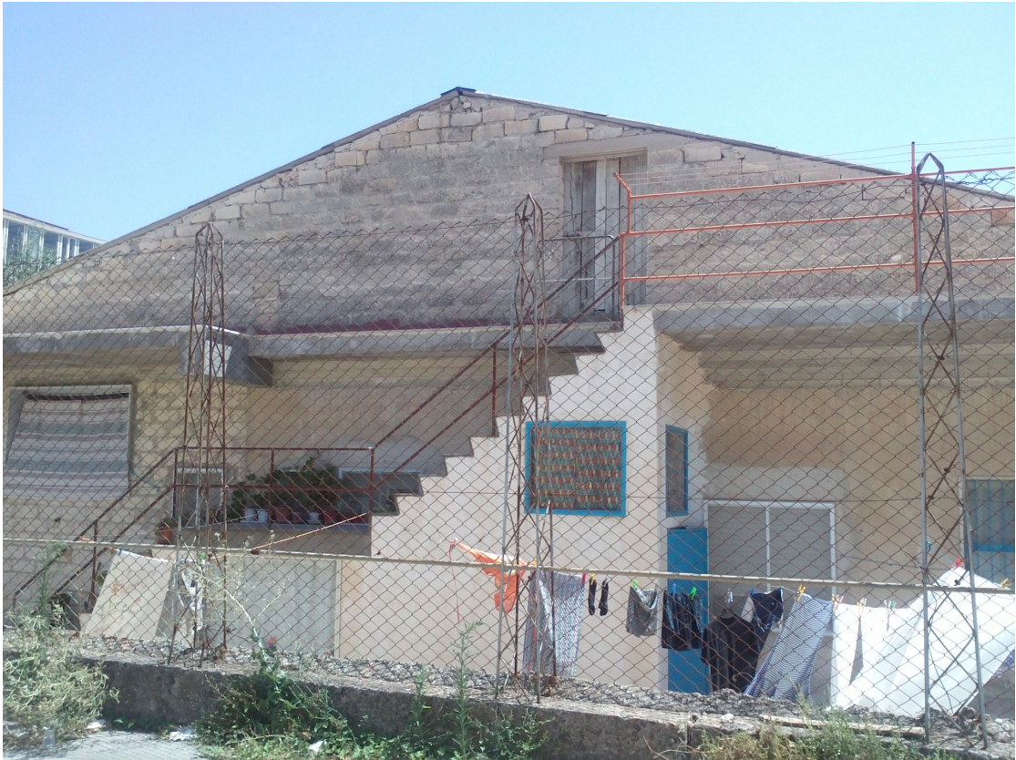
Foto 03. Tetto a due falde.
