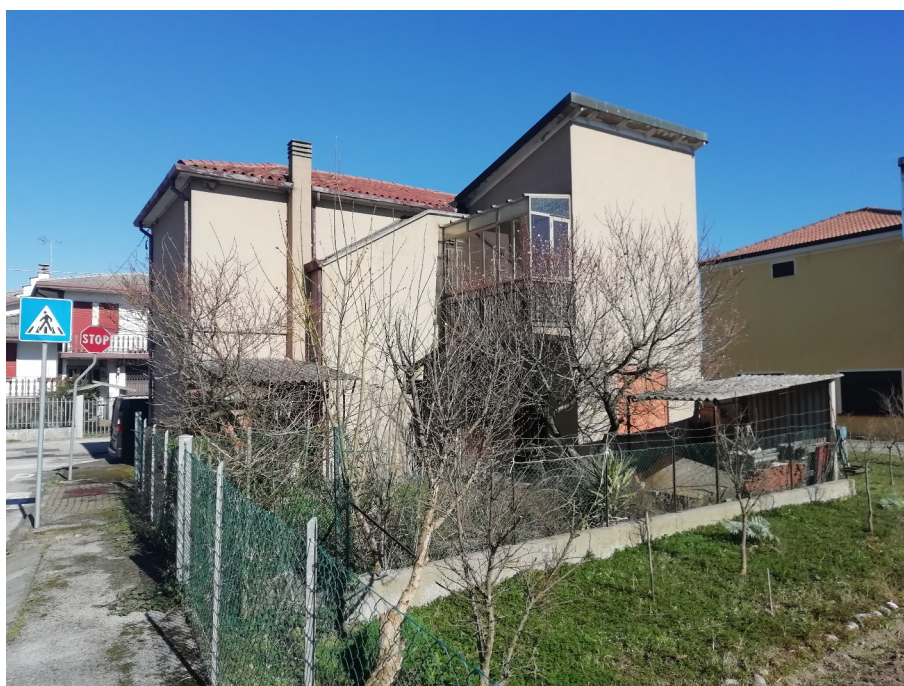
Foto 2 – vista da sud
