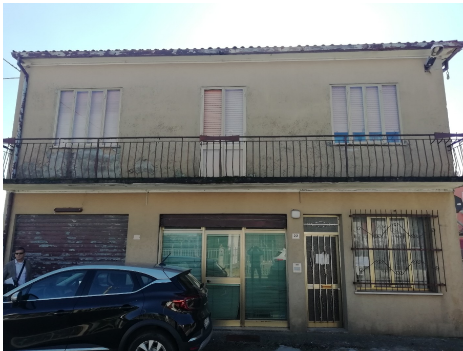
Foto 1 – vista da via Rosara
