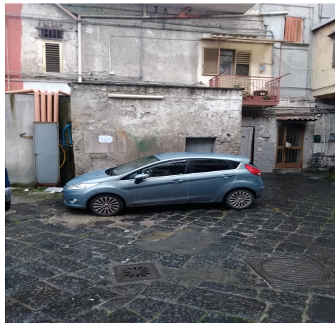
Foto n° 2 – Piano terra altra veduta esterna del locale magazzino.
