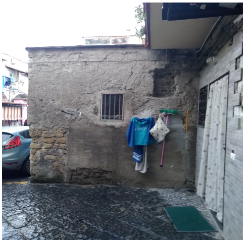
Foto n° 1 – Piano terra veduta esterna del locale magazzino.
